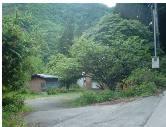
写真2-1 発生土置き場（旧荒川荘）計画地の現況
