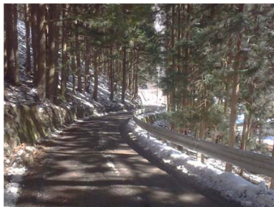
上蔵集落周辺の県道 253 号の状況
