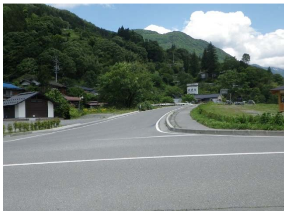
県道 253 号の始点の状況
