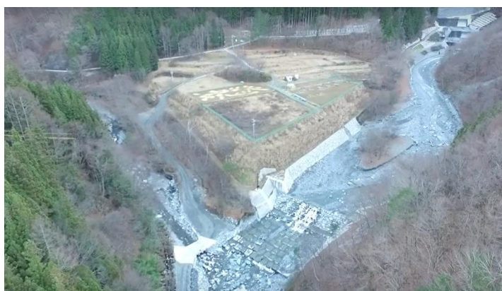
写真2-2 発生土仮置き場計画地Bの現況
