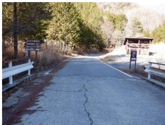
露頭入口(南側)周辺の状況
