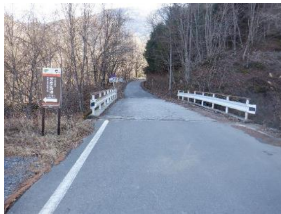
露頭入口(南側)の状況
