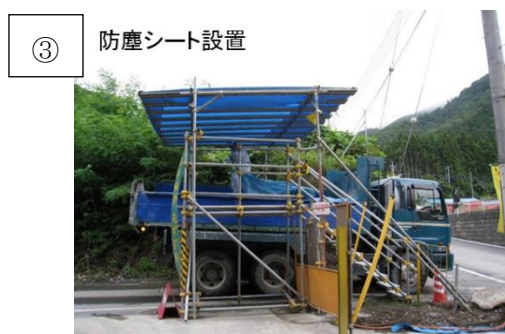
図 3-33 資材及び機械の運搬に用いる車両の運行による影響を低減するための環境保全措置
