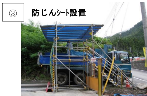
図 3-33 資材及び機械の運搬に用いる車両の運行による影響を低減するための環境保全措置
