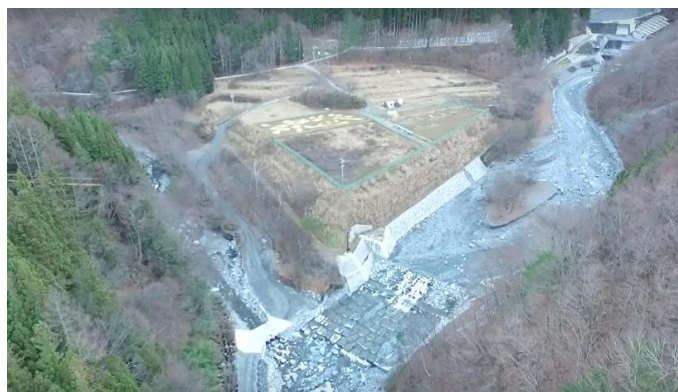
写真2-2 発生土仮置き場計画地Bの現況
