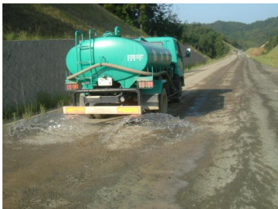
写真① 周辺道路の清掃及び散水、タイヤ洗浄機の設置
