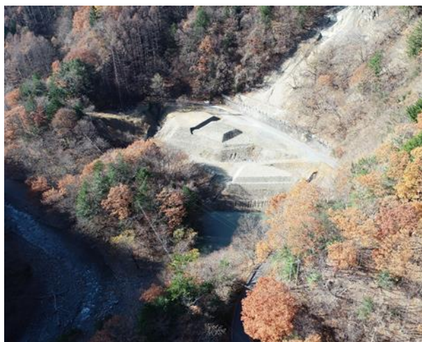
写真2-1 発生土置き場（青木川）計画地の現況
