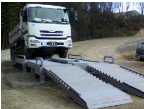
写真① 周辺道路の清掃及び散水、タイヤ洗浄機の設置
