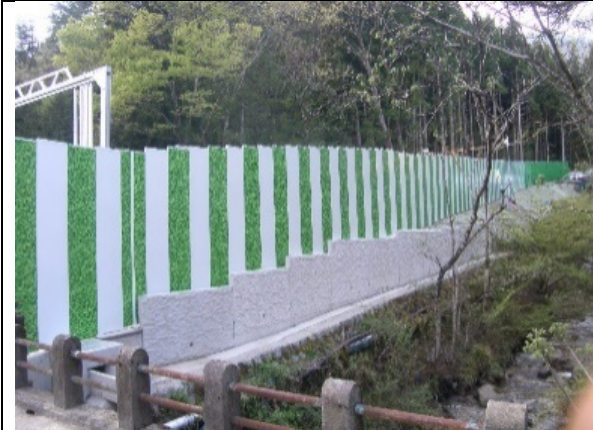
写真4-1-94 仮囲いの設置状況
