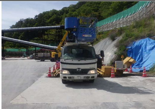
写真4-1-74 タイヤ洗浄機設置の状況
