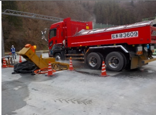
写真4-1-39 タイヤ洗浄機設置の状況
