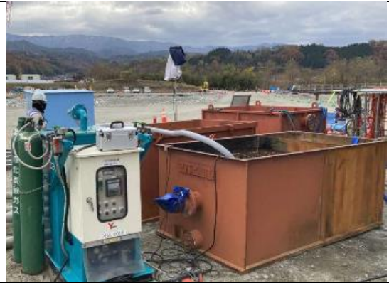
写真4-1-83 中和処理装置及び沈砂池の設置状況
