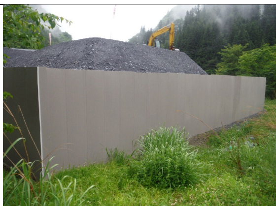
写真4-1-140 仮設物の色合いへの配慮
