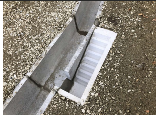
写真4-1-56 小動物等の移動経路の確保 (幅約25cmの階段を設置)
