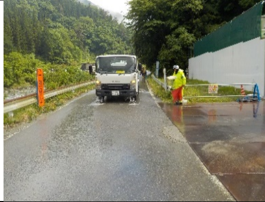
写真4-1-42 周辺道路の散水状況
