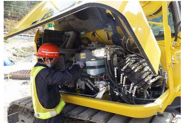
写真4-1-65 建設機械の点検及び整備による性能維持
