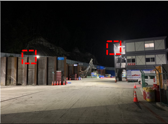
写真4-1-57 昆虫の誘引効果が低い照明 (LED灯) の設置状況
