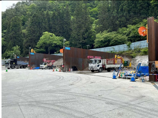
写真4-1-53 重金属等判定用土砂ピットの設置状況
