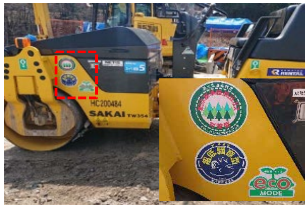
写真4-1-115 排出ガス対策型、低騒音型建設機械の採用
