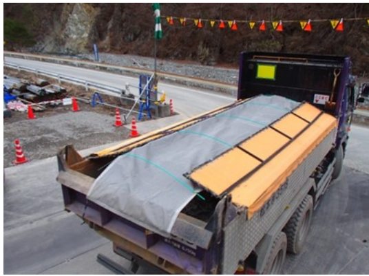
写真4-1-43 荷台への防じんシート敷設
