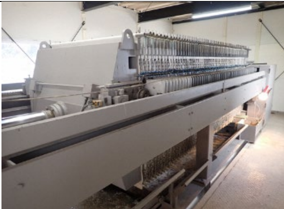
写真4-1-110 建設汚泥の処理状況
