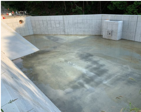
写真 参 1-3 沈砂池兼調整池の設置 (発生土置き場 (下久堅))
