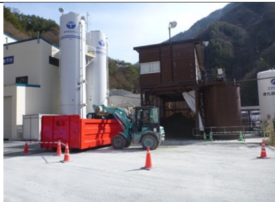
写真4-1-19 建設汚泥の処理状況
