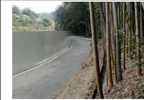
写真4-1-45 仮囲いの設置状況
