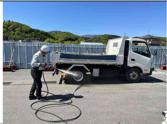
写真4-1-93 タイヤ洗浄の実施状況
