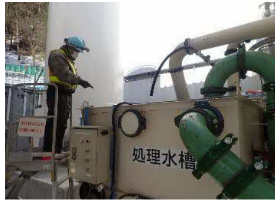
写真4-1-101 工事排水の監視状況
