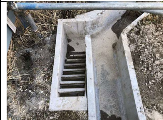
写真4-1-137 小動物等の移動経路の確保 (幅約25cmの階段を設置)
