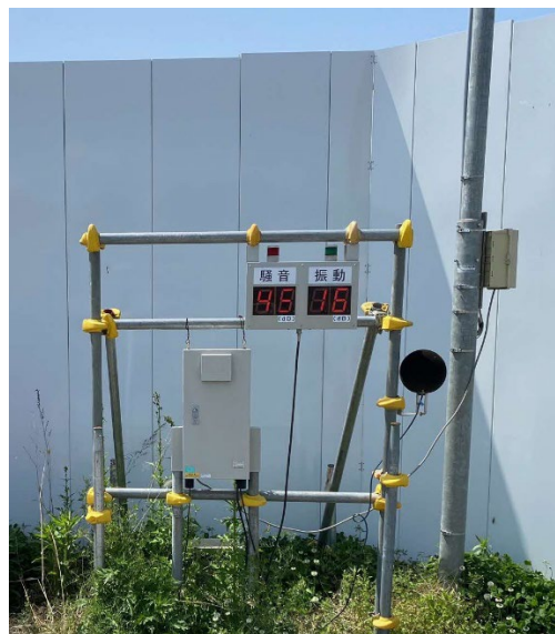
写真 参 2-1 モニター表示例 (07 発生土置き場 (堰下))
