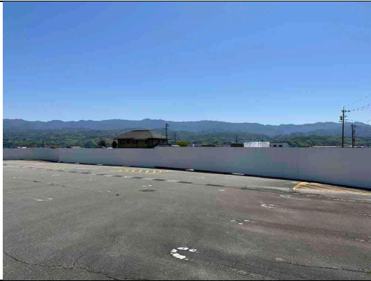
写真4-1-88 仮囲いの設置状況
