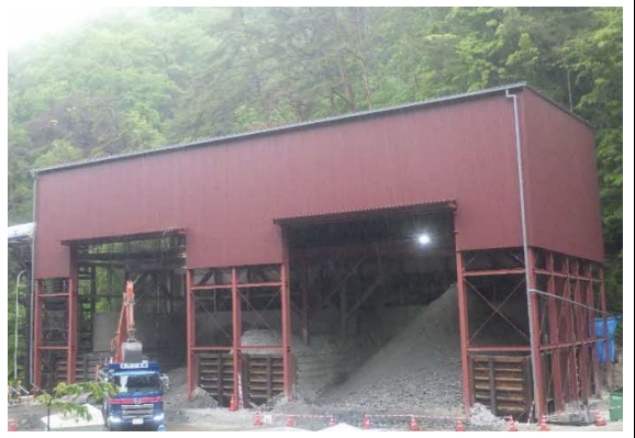
写真4-1-71 重金属等判定用土砂ピットの設置状況
