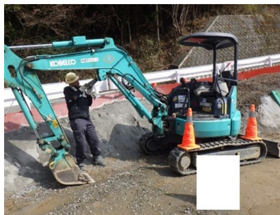
写真4-1-97 建設機械の点検及び整備による性能維持
