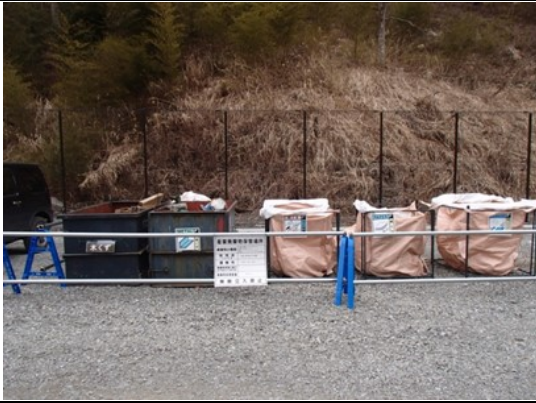
写真4-1-41 建設副産物の分別
