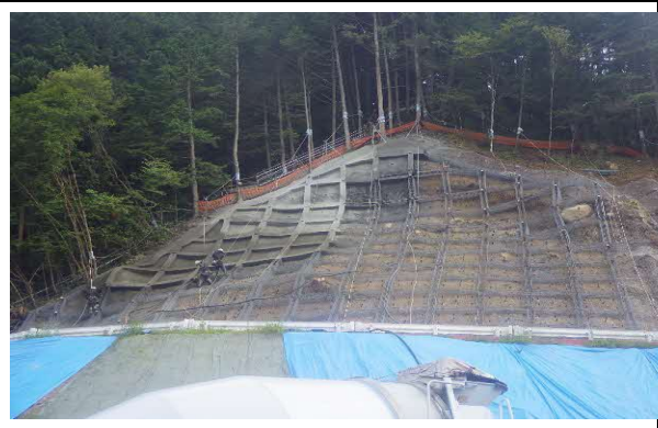
写真4-1-54 法面、斜面の保護の状況
