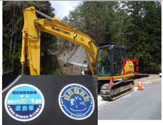
写真4-1-46 排出ガス対策型、低騒音型建設機械の採用
