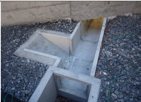
写真4-1-15 小動物等の移動経路の確保 (幅約50cmのスロープを設置)
