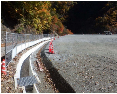
写真 参 1-1 外周の側溝の設置 (発生土置き場 (青木川))
