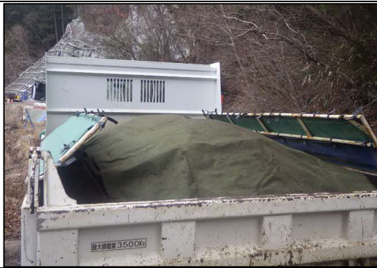
写真4-1-61 荷台への防じんシート敷設
