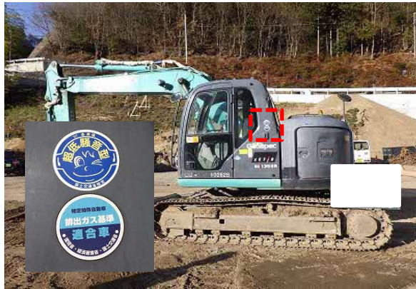
写真4-1-64 排出ガス対策型、低騒音型建設機械の採用
