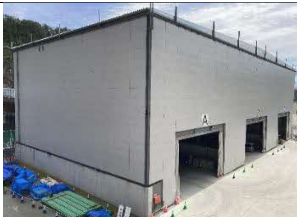
写真4-1-104 重金属等判定用土砂ピットの設置状況
