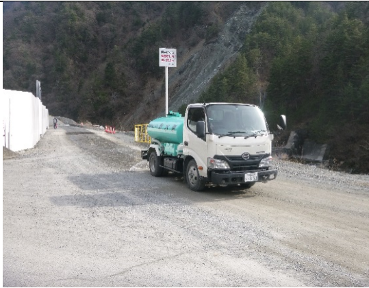
写真4-1-150 周辺道路の散水状況
