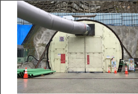
写真4-1-47 防音扉の設置状況
