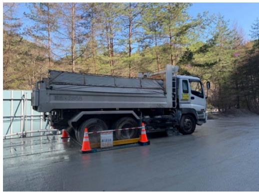
写真4-1-58 タイヤ洗浄の実施状況
