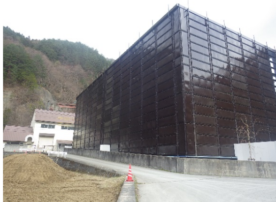
写真4-1-18 仮設物の色合いへの配慮
