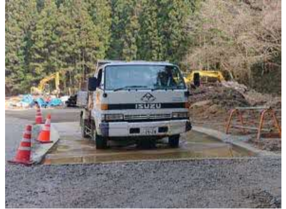
写真4-1-119 タイヤ洗浄の状況
