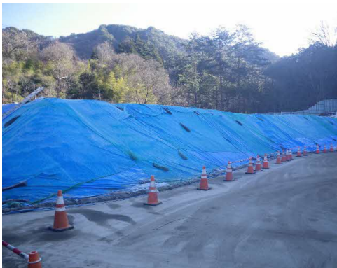
写真 参 1-7 遮水シート等による浸透防止 (発生土仮置き場 (坂島))
