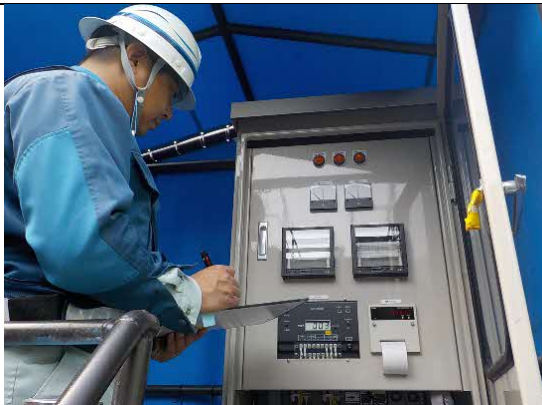
写真4-1-31 工事排水監視状況
