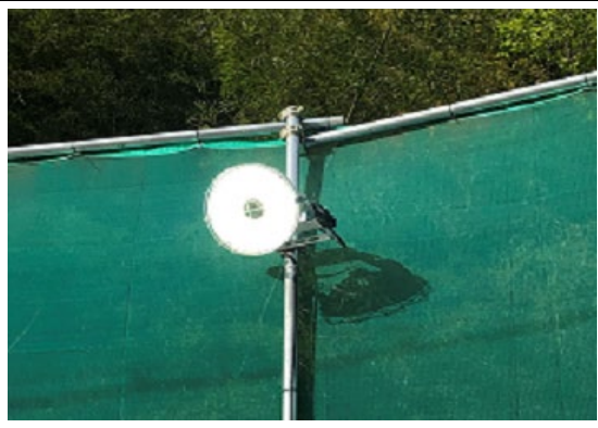
写真4-1-73 昆虫の誘引効果が低い照明 (LED灯) の設置状況
