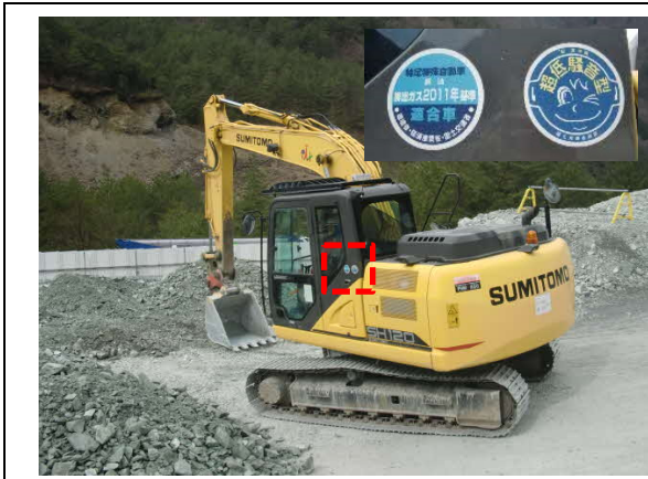
写真4-1-142 排出ガス対策型、低騒音型建設機械の採用
