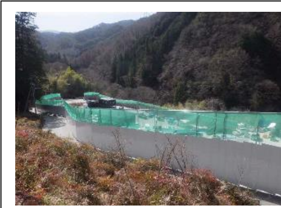
写真4-1-62 仮囲いの設置状況
