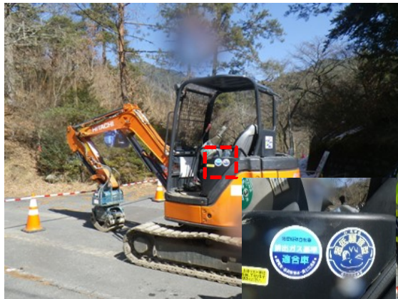
写真4-1-96 排出ガス対策型、低騒音型建設機械の採用
