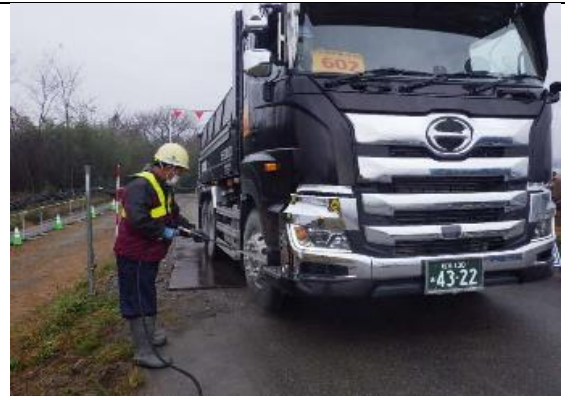
写真4-1-87 タイヤ洗浄の実施状況
