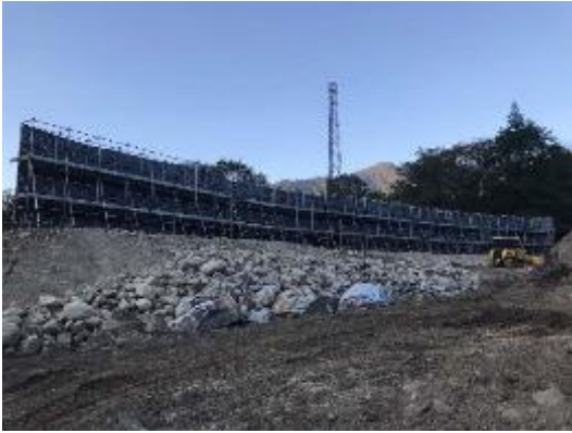
写真4-1-121 防音シート設置状況
