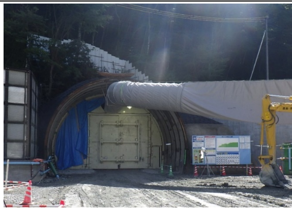
写真4-1-2 防音扉の設置状況
