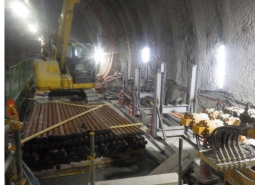
写真4-1-8 先進ボーリングの実施状況 (地盤の状況を把握し、適切な支保工パターン等を選定)
