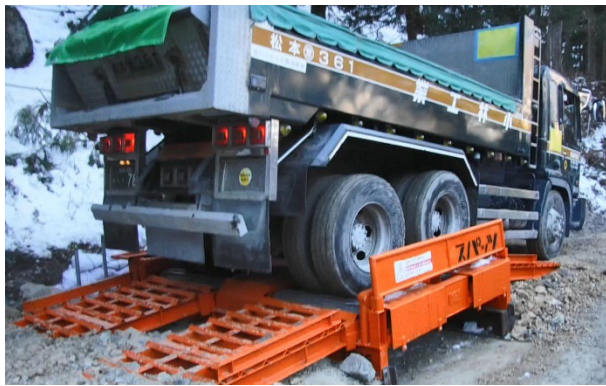
写真4-1-17 タイヤ洗浄機設置の状況
