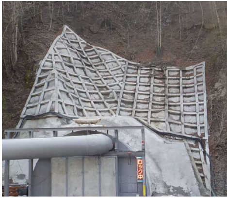
写真4-1-35 法面、斜面の保護状況
