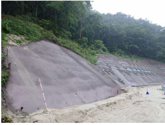
写真4-1-106 法面・斜面保護の状況
