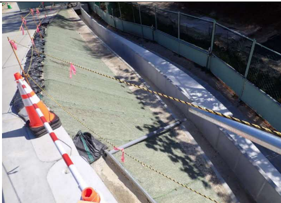
写真4-1-108 切土法面等の緑化による植生復元の状況
