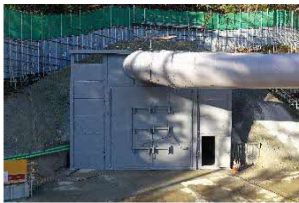
写真4-1-95 防音扉の設置状況
