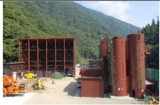
写真4-1-40 仮設物の色合いへの配慮
