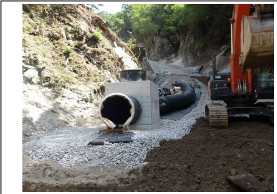
写真4-1-133 暗渠管敷設状況
