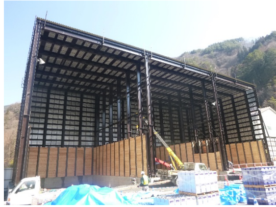
写真4-1-12 重金属等判定用土砂ピットの設置状況
