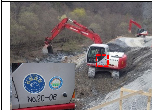
写真4-1-3 排出ガス対策型、低騒音型 建設機械の採用
