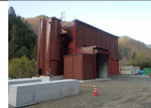
写真4-1-75 仮設物の色合いへの配慮
