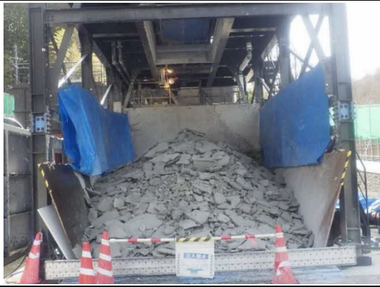
写真4-1-76 建設汚泥の処理状況
