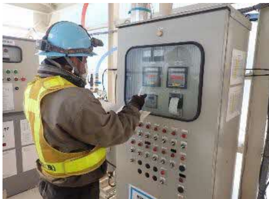
写真4-1-102 濁水処理設備の点検状況
