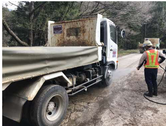
写真4-1-126 タイヤ洗浄の実施状況
