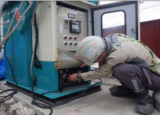
写真4-1-86 中和処理装置の整備状況
