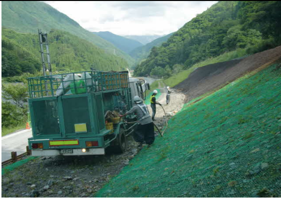
写真4-1-13 法面、斜面の保護の状況
