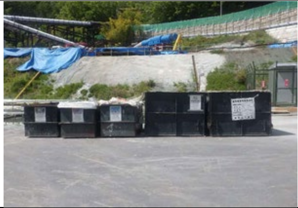
写真4-1-77 建設副産物の分別
