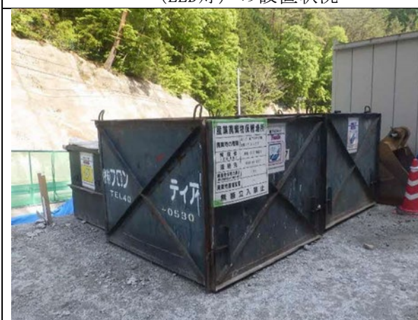
写真4-1-141 副産物の分別、再資源化
