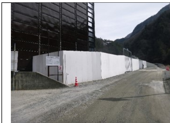
写真4-1-1 仮囲いの設置状況
