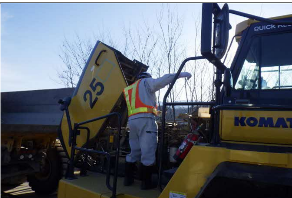
写真4-1-80 建設機械の点検及び整備による性能維持
