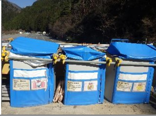
写真4-1-112 建設副産物の分別
