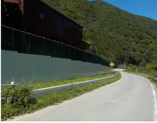
写真4-1-23 仮囲いの設置状況
