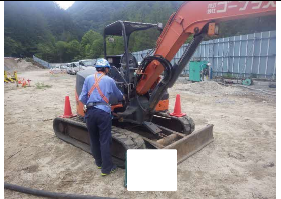
写真4-1-48 建設機械の点検及び整備による性能維持
