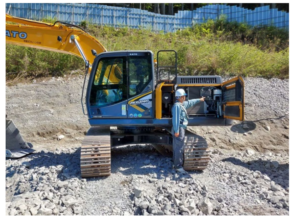
写真4-1-143 建設機械の点検及び整備による性能維持
