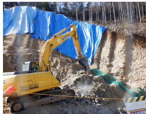
写真 参 1-6 段切り工の実施 (発生土置き場 (下久堅))
