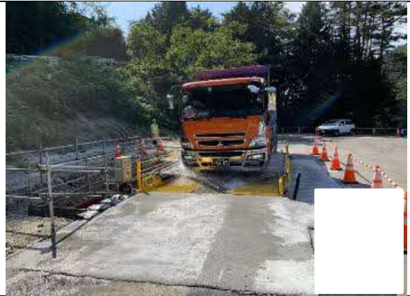
写真4-1-107 タイヤ洗浄の実施状況
