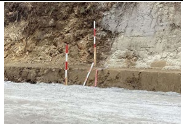
写真4-1-134 段切り施工状況
