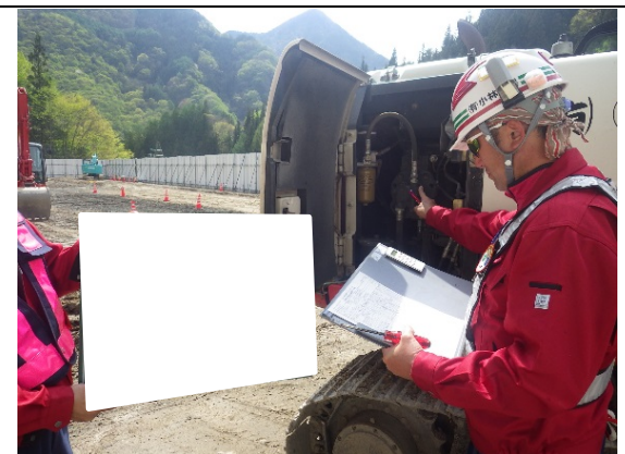
写真4-1-4 建設機械の点検・整備による 性能維持
