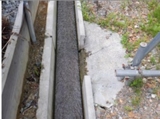
写真4-1-37 小動物等の移動経路の確保 (幅約1mのスロープを設置)
