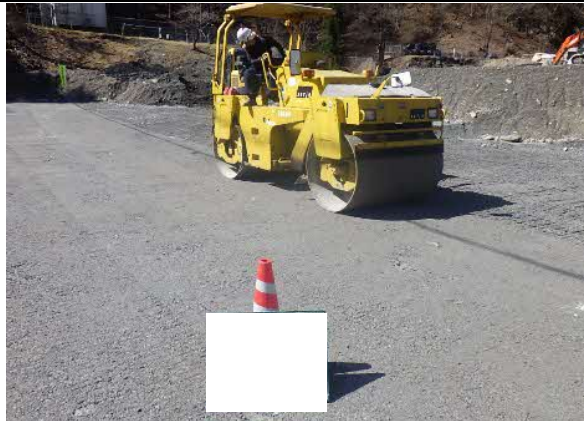
写真4-1-136 盛土材の転圧状況
