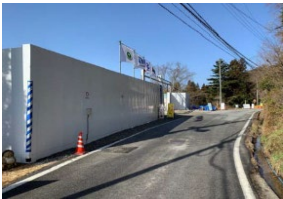
写真4-1-114 仮囲いの設置状況
