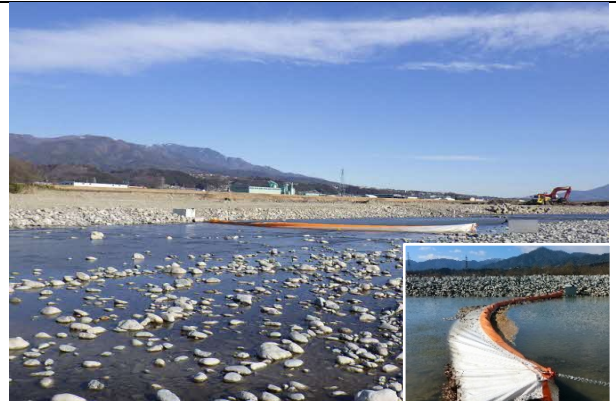
写真4-1-85 汚濁防止膜の設置状況
