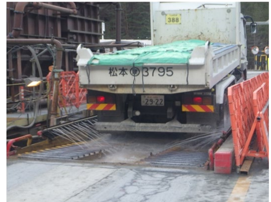
写真4-1-147 タイヤ洗浄の実施状況
