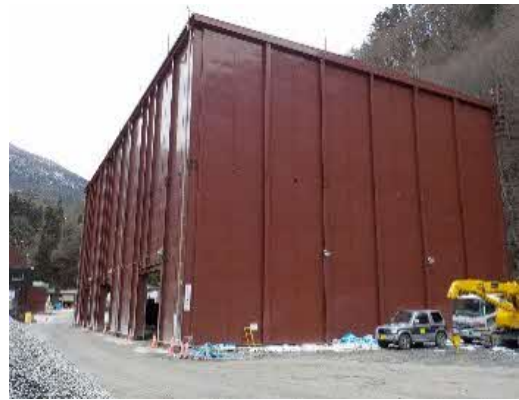
写真4-1-34 重金属等判定用土砂ピットの設置状況
