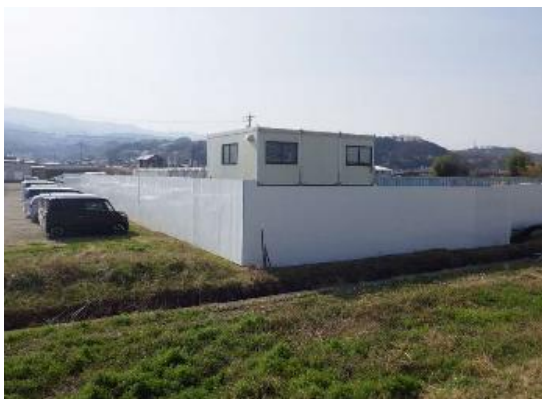
写真4-1-78 仮囲いの設置状況
