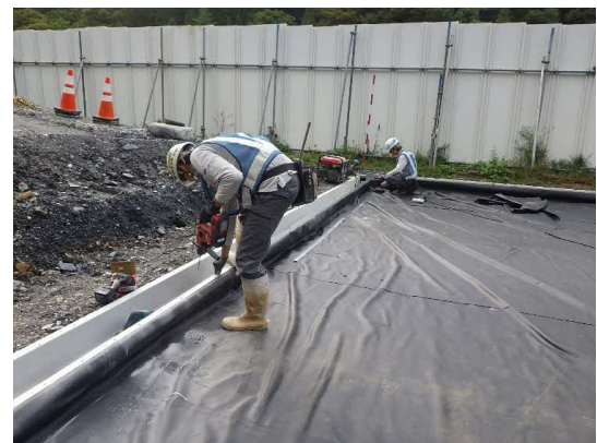
写真4-1-145 排水溝（区分土）設置状況
