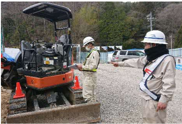
写真4-1-116 建設機械の点検及び整備による性能維持
