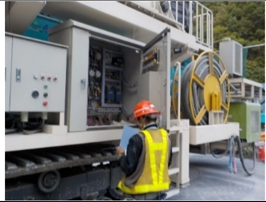
写真4-1-26 建設機械の点検及び整備による性能維持
