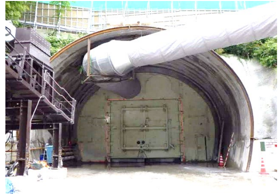
写真4-1-63 防音扉の設置状況
