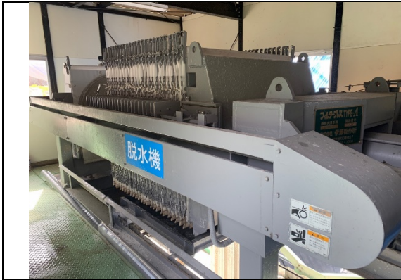
写真4-1-59 建設汚泥の処理状況
