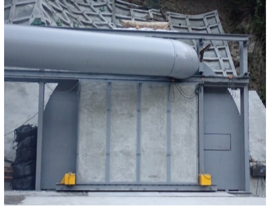
写真4-1-24 防音扉の設置状況
