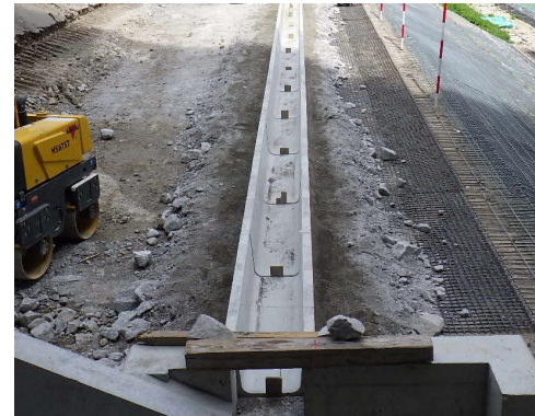
写真 参 1-4 小段排水の設置 (発生土置き場 (戸中))
