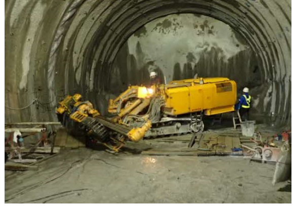
写真4-1-30 水平調査ボーリングの実施状況 (地盤の状況を把握し、適切な支保工パターン等を選定)
