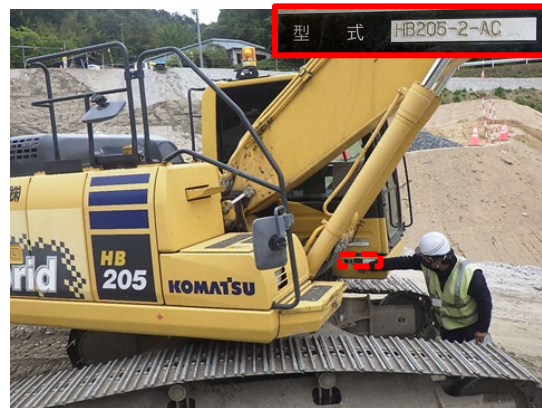
写真4-1-111 低炭素型建設機械の採用
