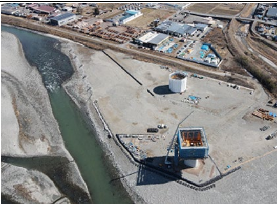
写真4-1-84 仮締切工の実施状況
