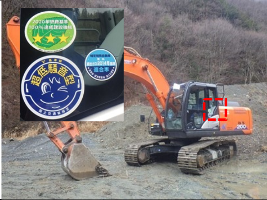
写真4-1-25 排出ガス対策型、低騒音型建設機械の採用
