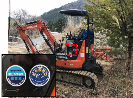
写真4-1-122 排出ガス対策型、低騒音型 建設機械の採用
