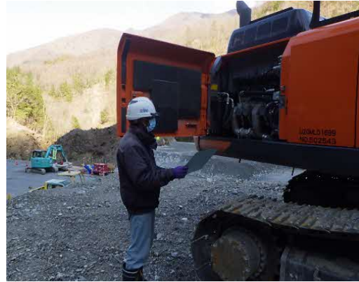
写真4-1-128 建設機械の点検及び整備による性能維持
