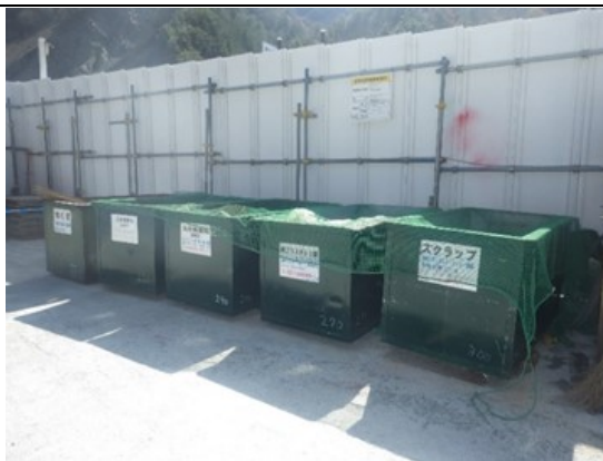
写真4-1-20 建設副産物の分別
