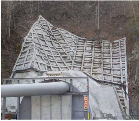
写真4-1-35 法面、斜面の保護状況
