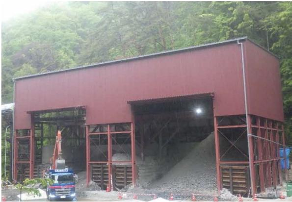
写真4-1-69 重金属等判定用土砂ピットの設置状況
