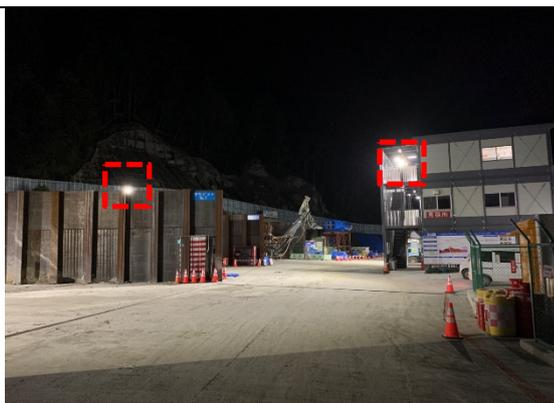
写真4-1-56 昆虫の誘因効果が低い照明 (LED灯) の設置状況
