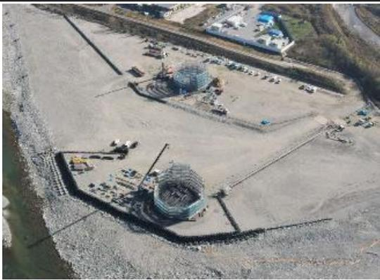
写真4-1-82 仮締切工の実施状況
