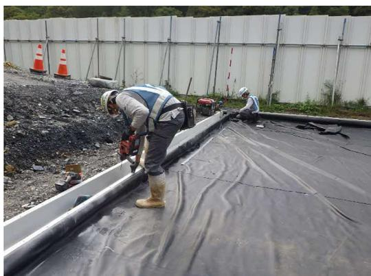
写真4-1-133 排水溝（区分土）設置状況
