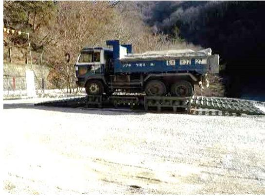
写真4-1-128 タイヤ洗浄装置の設置状況
