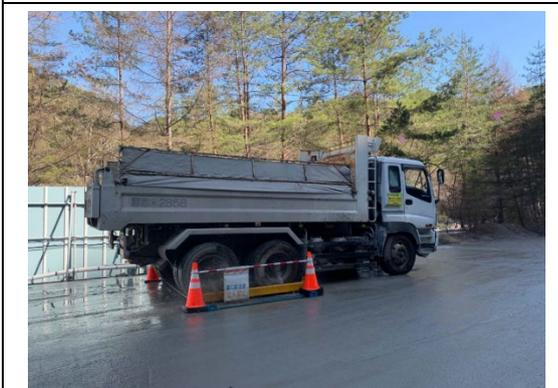
写真4-1-57 タイヤ洗浄の実施状況
