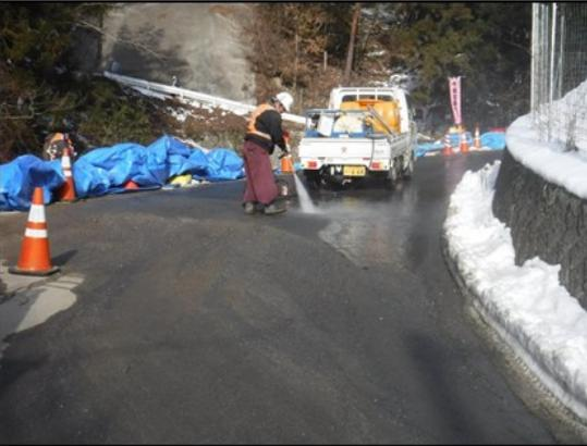
写真4-1-49 工事現場の散水状況
