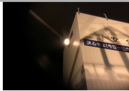
写真4-1-16 昆虫の誘因効果が低い照明（ナトリウム灯）の設置状況
