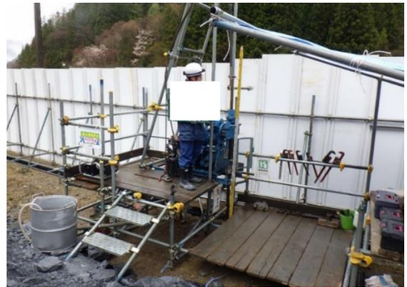
写真4-1-124 ボーリング調査の実施状況
