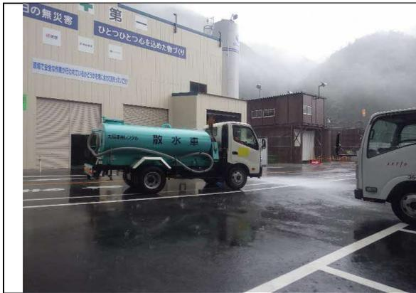
写真4-1-5 工事現場の散水状況
