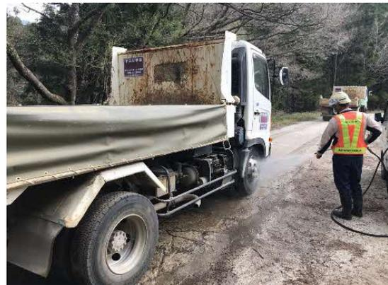
写真4-1-118 タイヤ洗浄の実施状況
