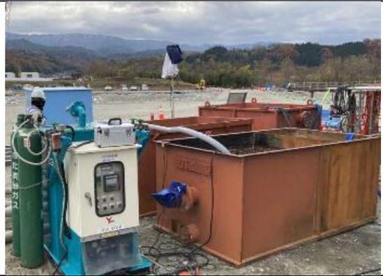
写真4-1-81 中和処理装置及び沈砂池の設置
