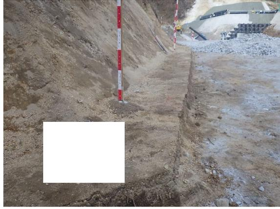
写真4-1-126 段切り施工状況
