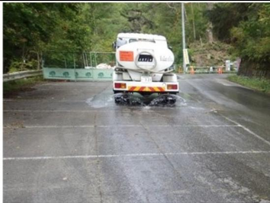
写真4-1-90 工事現場の散水状況
