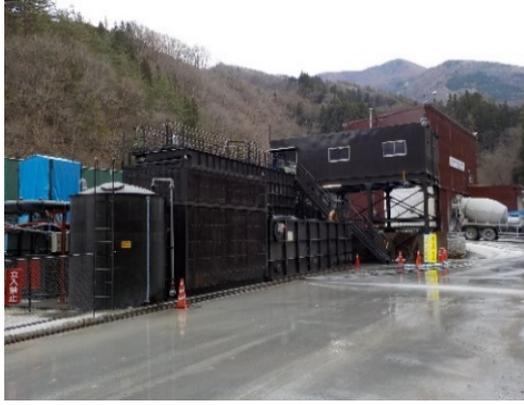
写真4-1-29 濁水処理設備の設置状況
