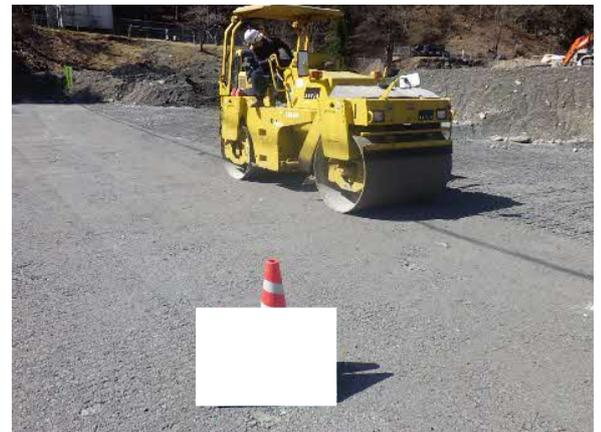
写真 参 1-6 30cm 毎の締固め
