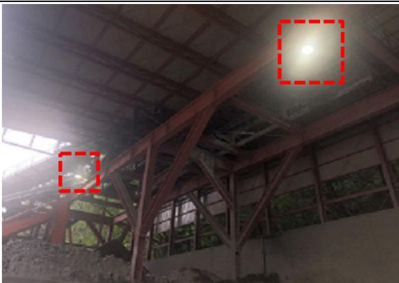
写真4-1-129 昆虫の誘因効果が低い照明 (LED灯) の設置状況
