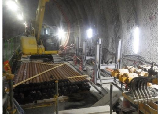
写真4-1-8 先進ボーリングの実施状況
