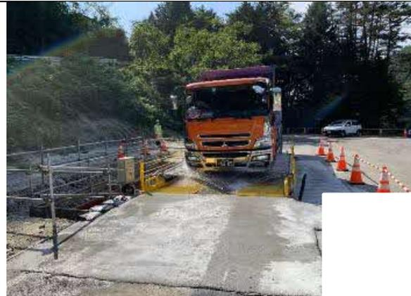
写真4-1-100 タイヤ洗浄の実施状況
