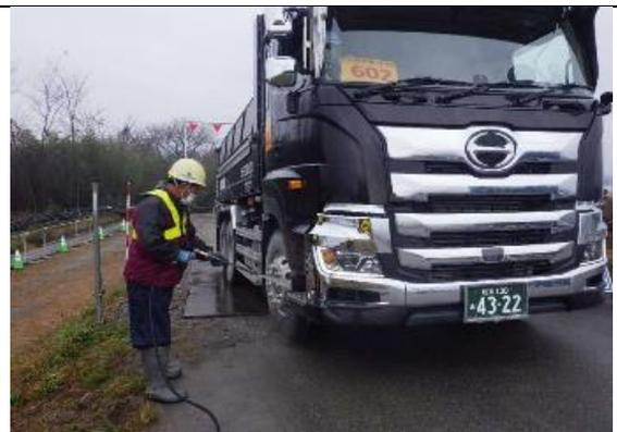
写真4-1-85 タイヤ洗浄の実施状況
