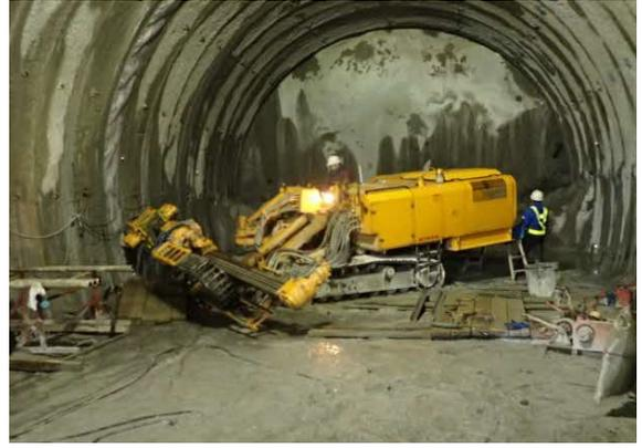
写真4-1-30 水平調査ボーリングの実施状況
