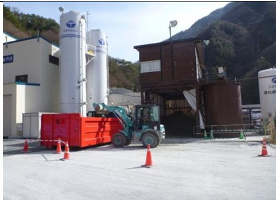
写真4-1-19 建設汚泥の処理状況
