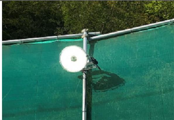
写真4-1-71 昆虫の誘因効果が低い照明 (LED灯) の設置状況
