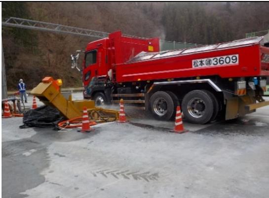
写真4-1-39 タイヤ洗浄機設置の状況
