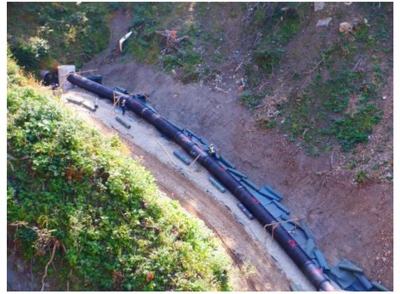
写真 参 1-2 盛土下部の地下排水管の設置
