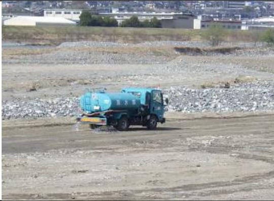
写真4-1-80 工事現場の散水状況
