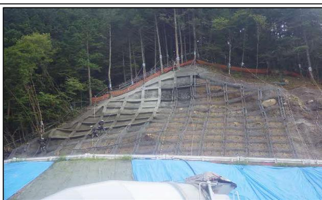
写真4-1-54 法面、斜面の保護の状況
