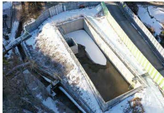
写真4-1-95 排水前の水温調整状況
