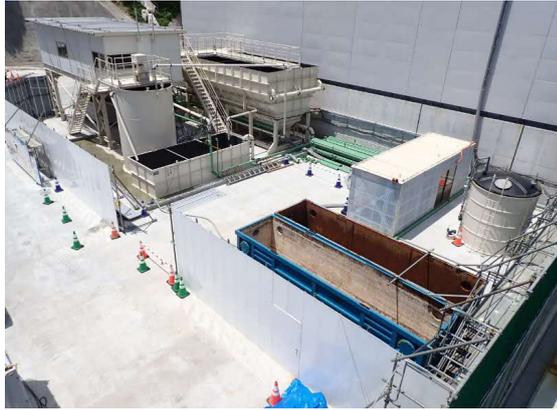
写真4-1-92 濁水処理設備の設置
