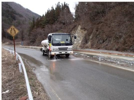
写真4-1-27 工事現場の散水状況
