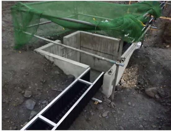
写真 参 1-1 外周の排水溝及び沈砂池の設置
