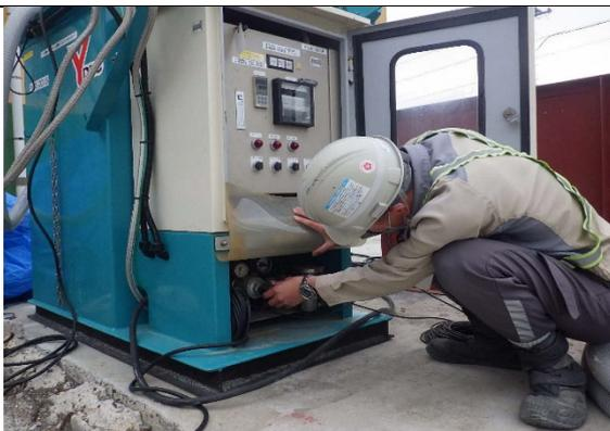
写真4-1-84 中和処理装置の整備状況
