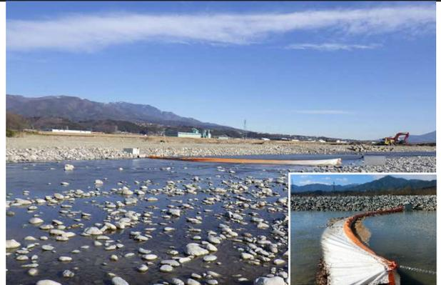
写真4-1-83 汚濁防止膜の設置状況
