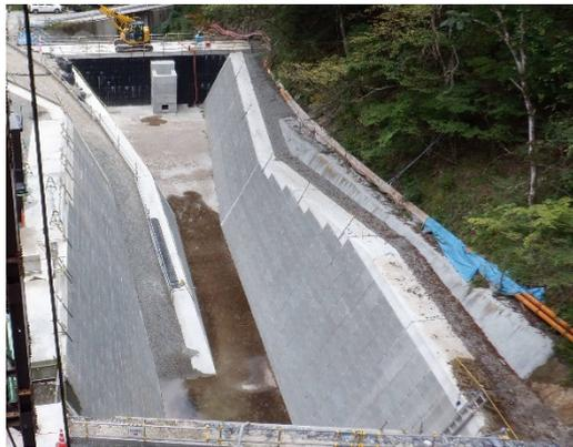
写真4-1-123 排水設備の設置状況
