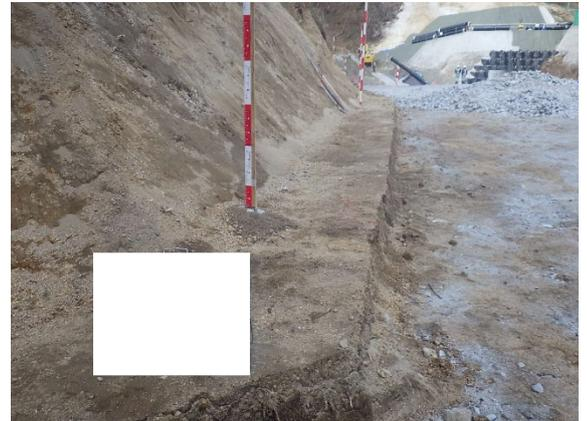
写真 参 1-4 段切り工の実施
