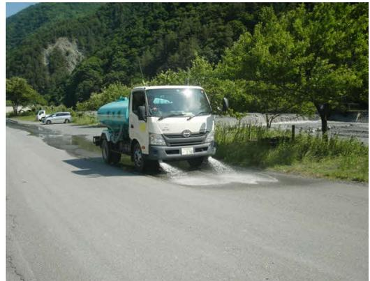
写真4-1-122 工事現場の散水状況
