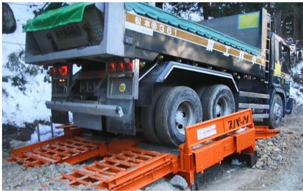
写真4-1-17 タイヤ洗浄機設置の状況
