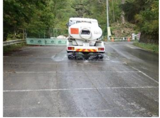
写真4-1-70 工事現場の散水状況（一例）
