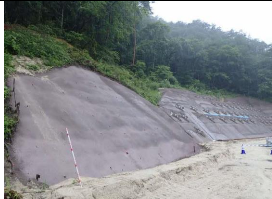
写真4-1-73 法面・斜面保護の状況（一例）
