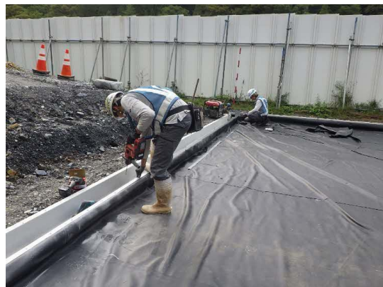
写真4-1-100 排水溝（区分土）設置状況（一例）
