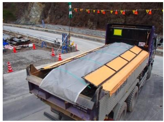
写真4-1-45 荷台への防じんシート敷設 (一例)
