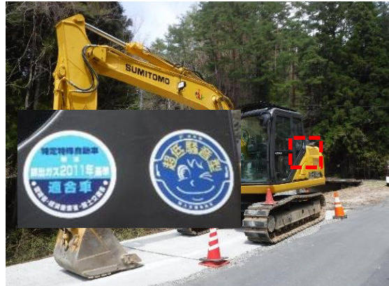
写真4-1-48 排出ガス対策型、低騒音型 建設機械の採用 (一例)
