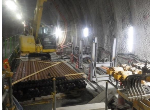
写真4-1-8 先進ボーリングの実施状況 (一例) (地盤の状況を把握し、適切な支保工 パターン等を選定)
