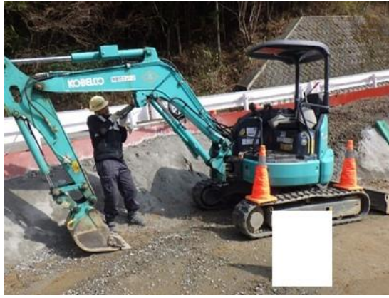
写真4-1-69 建設機械の点検及び整備による性能維持（一例）
