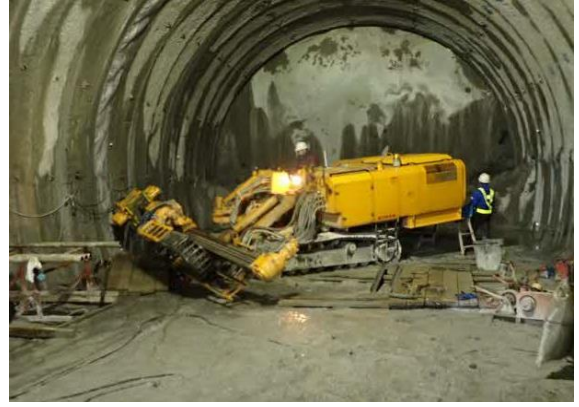
写真4-1-31 水平調査ボーリングの実施状況 (一例) (地盤の状況を把握し、適切な支保工 パターン等を選定)
