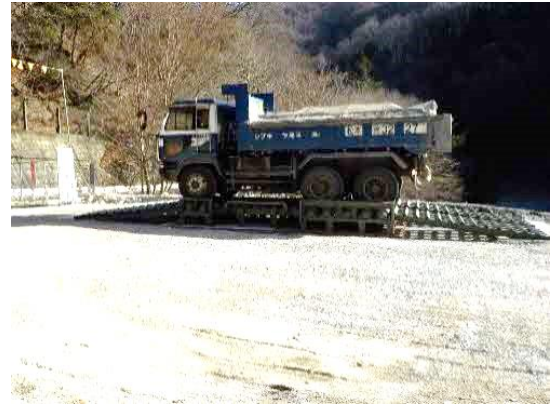
写真4-1-96 タイヤ洗浄装置の設置状況（一例）
