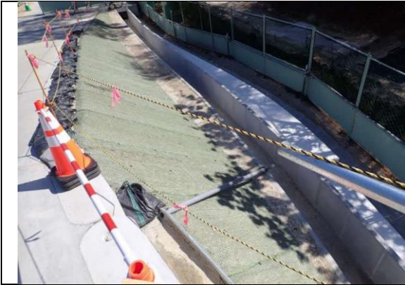
写真4-1-75 切土法面等の緑化による植生復元の状況（一例）
