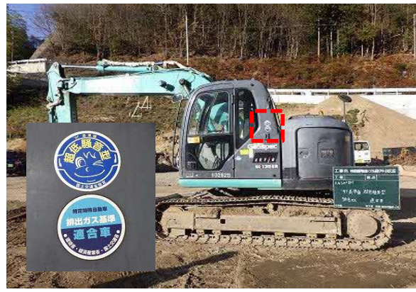
写真4-1-56 排出ガス対策型、低騒音型建設機械の採用 (一例)
