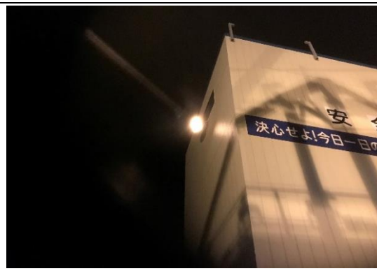
写真4-1-16 ナトリウム灯設置の状況 (一例)
