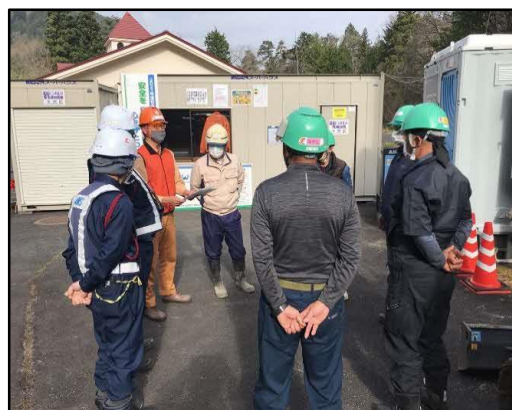
写真4-1-88 工事従事者への講習・指導の実施状況 (一例)
