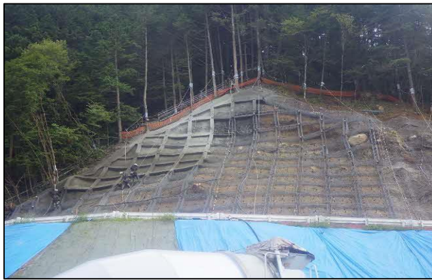
写真4-1-53 法面、斜面の保護の状況（一例）
