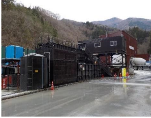
写真4-1-30 濁水処理設備の設置状況 (一例)
