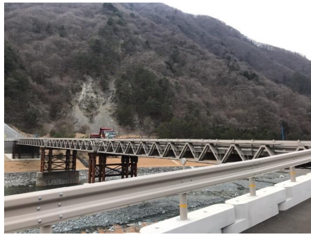
仮栈橋運行状況
