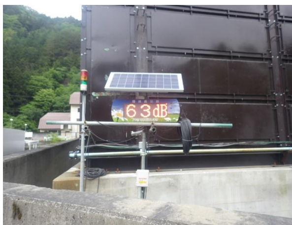
写真 参 1-1 モニター表示例 (02 小渋川非常口)
