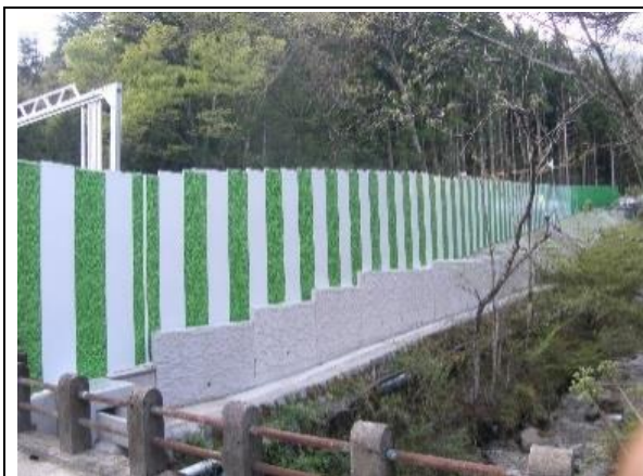
写真4-1-67 仮囲いの設置状況（一例）
