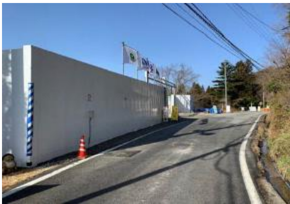
写真4-1-78 仮囲いの設置状況 (一例)
