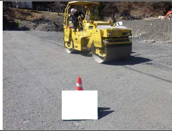
写真4-1-95 盛土材の転圧状況（一例）
