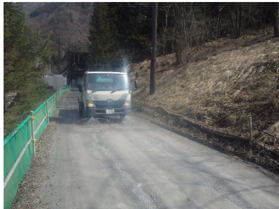
写真4-1-92 工事現場の散水状況 （一例）
