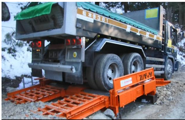
写真4-1-17 タイヤ洗浄機設置の状況 (一例)
