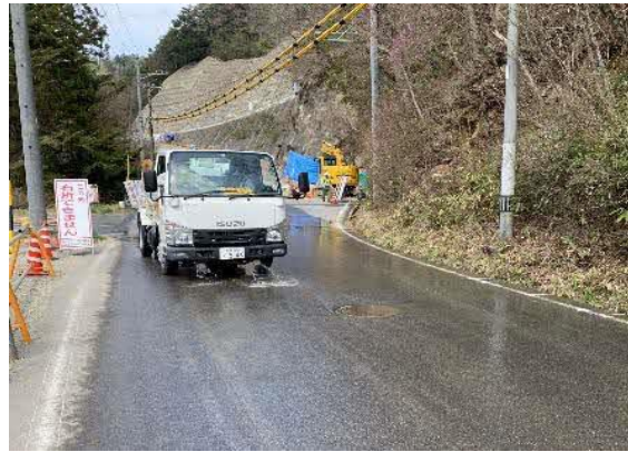
写真4-1-81 工事現場の散水状況 (一例) (車両の運行ルート)
