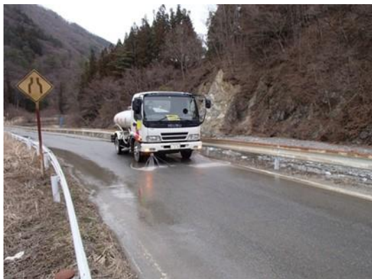
写真4-1-28 工事現場の散水状況 (一例) (車両の運行ルート)
