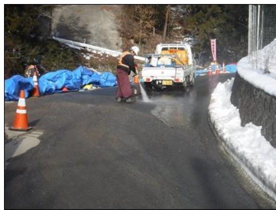
写真4-1-50 工事現場の散水状況 (一例) (車両の運行ルート)
