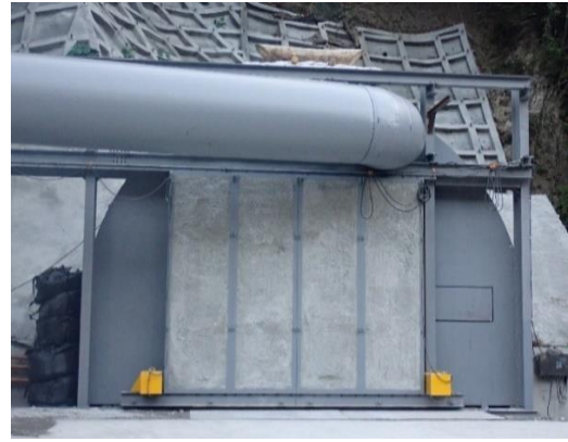
写真4-1-25 防音扉の設置 (一例)
