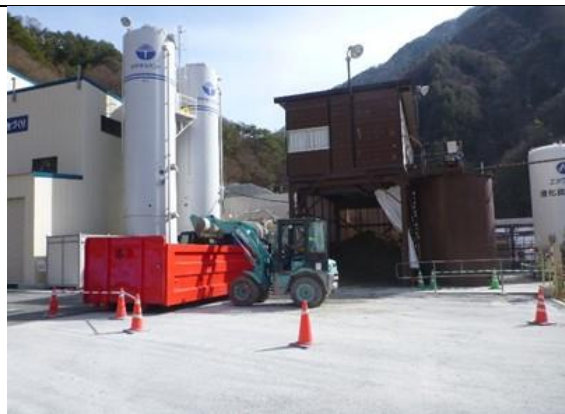
写真4-1-19 脱水ケーキ搬出の状況 (一例)
