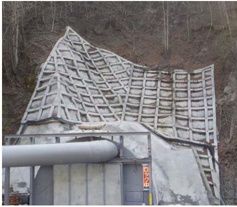
写真4-1-36 法面、斜面の保護状況
