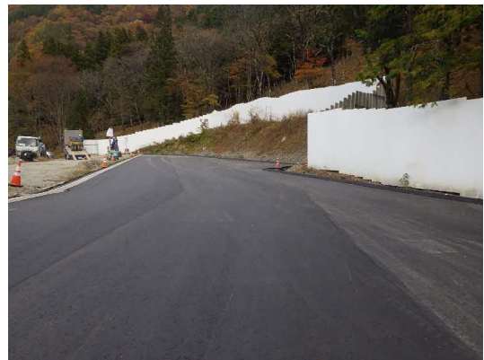
写真4-1-101 仮置き場の適正管理（アスファルト舗装）（一例）
