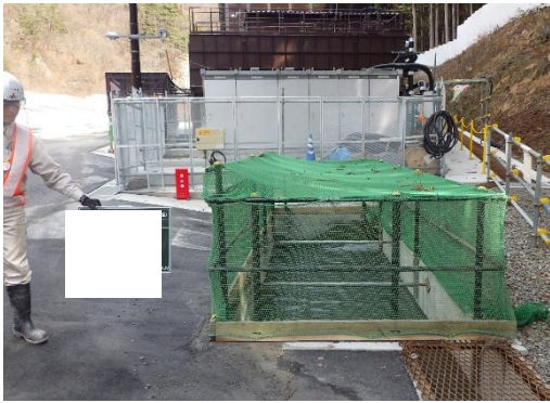
写真4-1-7 濁水処理設備の設置状況 (一例)
