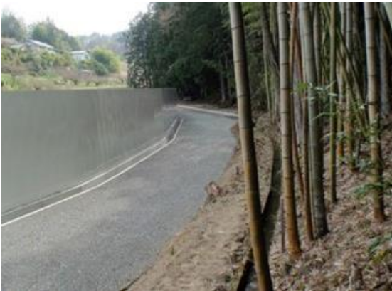
写真4-1-47 仮囲いの設置状況 (一例)
