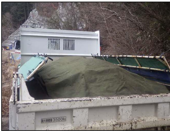
写真4-1-55 荷台への防じんシート敷設（一例）
