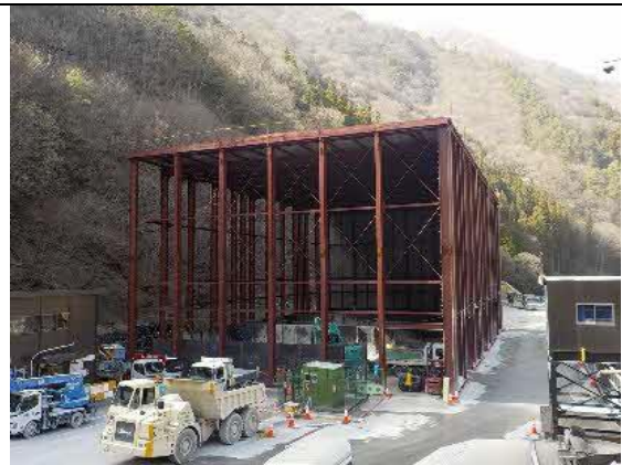
写真4-1-35 重金属等判定用土砂ピットの 設置状況 (一例)
