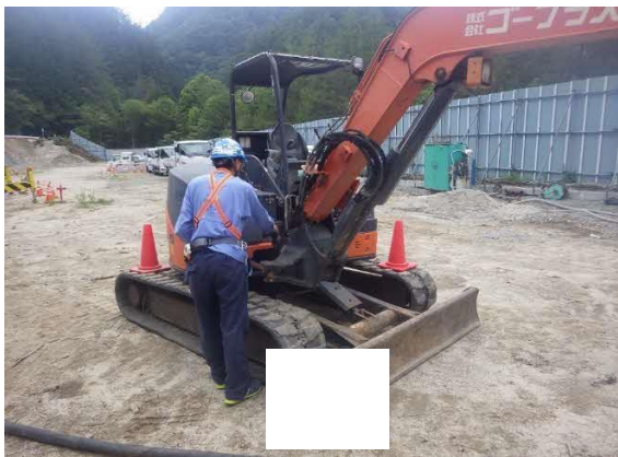
写真4-1-49 建設機械の点検及び整備に よる性能維持 (一例)
