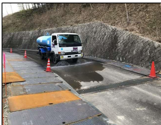
写真4-1-87 工事現場の散水状況 (一例) (車両の運行ルート)
