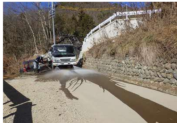
写真4-1-58 工事現場の散水状況 (一例) (車両の運行ルート)
