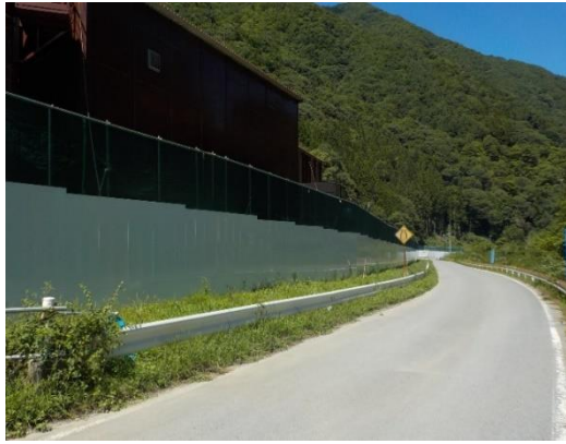
写真4-1-24 仮囲いの設置状況 (一例)
