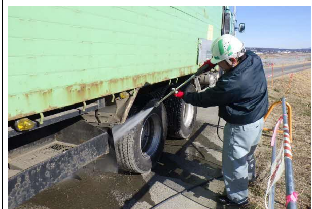
写真4-1-66 タイヤ洗浄の実施状況 （一例）
