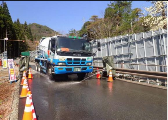
写真4-1-74 タイヤ洗浄の実施状況（一例）
