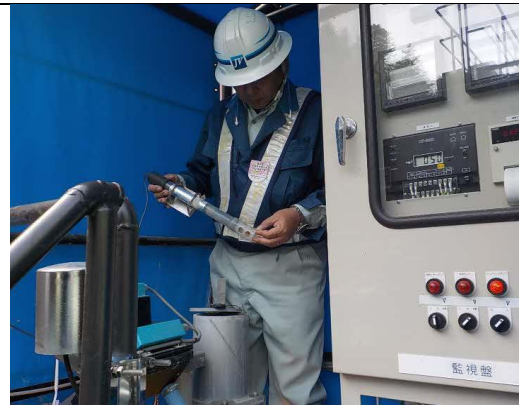
写真4-1-33 濁水処理設備の整備状況 (一例)
