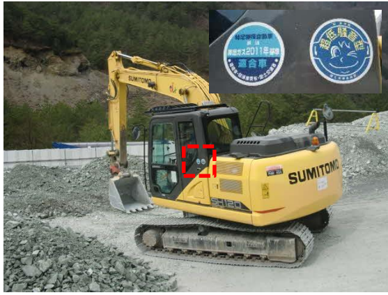
写真4-1-98 排出ガス対策型、低騒音型建設機械の採用（一例）
