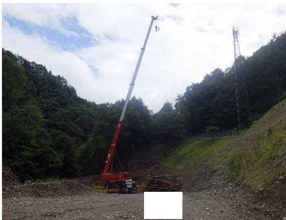
クレーン設置状況
