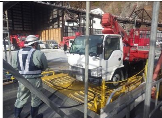
写真4-1-21 タイヤ洗浄の実施状況 (一例)
