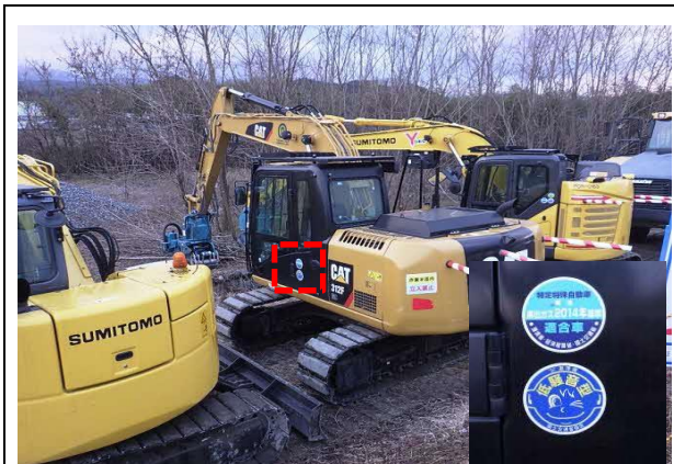
写真4-1-62 排出ガス対策型、低騒音型 建設機械の採用（一例）
