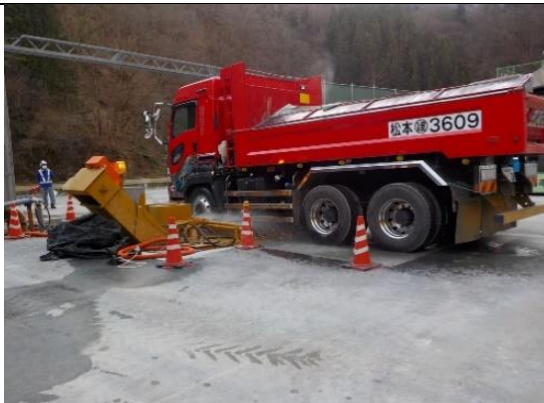
写真4-1-40 タイヤ洗浄機設置の状況（一例）
