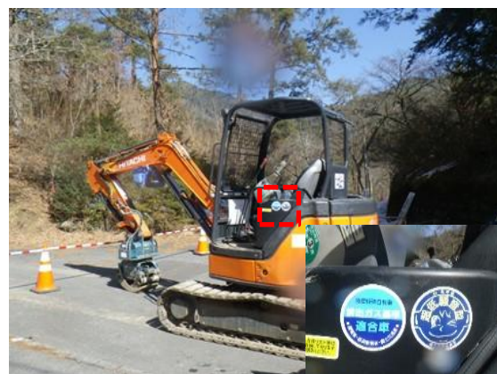
写真4-1-68 排出ガス対策型、低騒音型建設機械の採用（一例）
