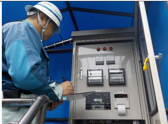
写真4-1-32 工事排水監視状況 (一例)
