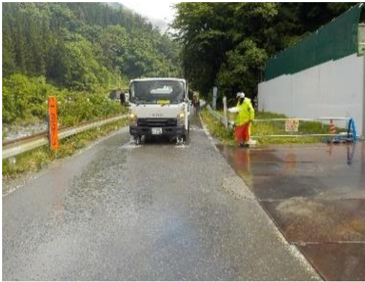
写真4-1-44 周辺道路の散水状況 (一例)
