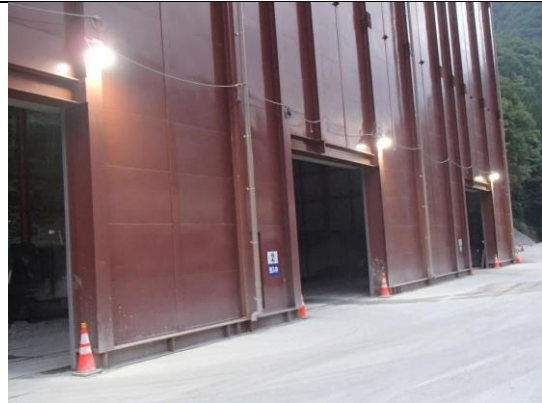
写真4-1-39 LED灯設置の状況（一例）
