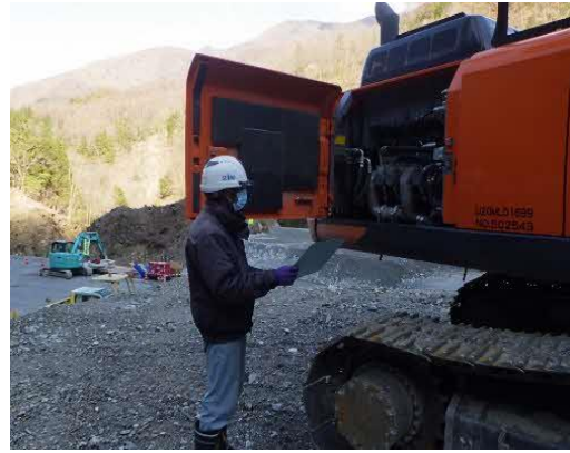
写真4-1-90 建設機械の点検及び整備に よる性能維持（一例）
