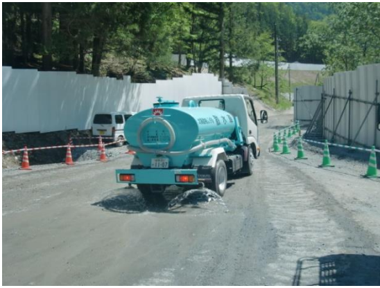
写真4-1-5 工事現場の散水状況 (一例)
