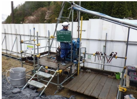
写真4-1-94 現地盤調査実施の状況 （一例）
