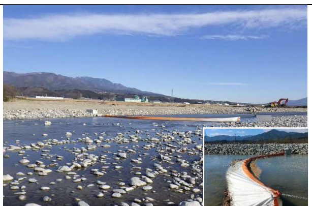
写真4-1-65 汚濁防止膜の設置状況 （一例）
