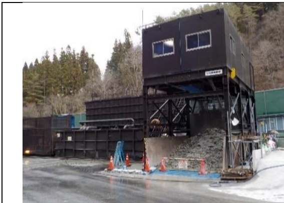
写真4-1-42 濁水処理設備設置の状況 (一例)
