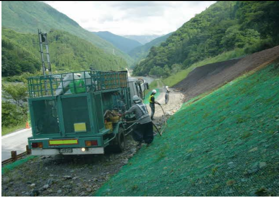
写真4-1-13 法面、斜面の保護の状況 (一例)
