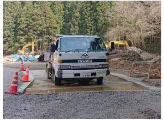
写真4-1-83 タイヤ洗浄の状況（一例）
