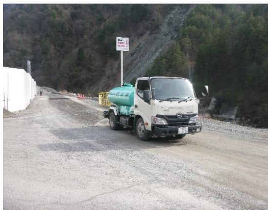
写真4-1-102 周辺道路の散水状況（一例）
