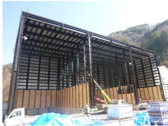
写真4-1-12 重金属等判定用土砂ピットの 設置状況 (一例)
