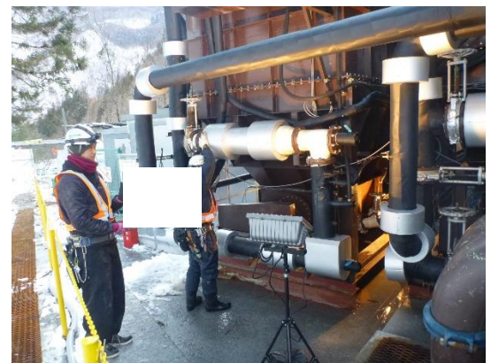
写真4-1-10 濁水処理設備の整備状況 (一例)
