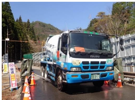
写真4-1-54 タイヤ洗浄状況（一例）
