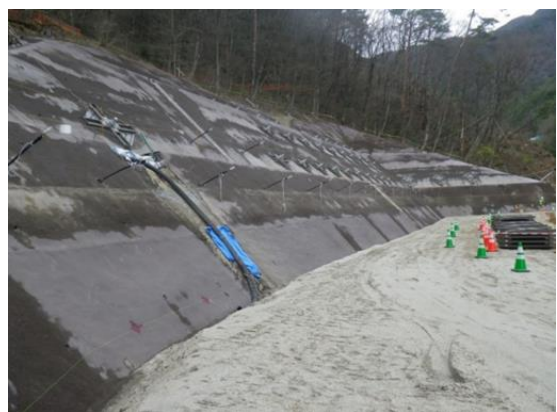
写真4-1-52 シートによる法面保護状況（一例）
