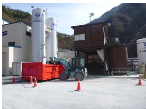
写真4-1-19 脱水ケーキ搬出の状況 (一例)
