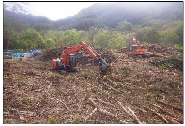
写真4-1-65 支持地盤における草木の伐開・除根（一例）
