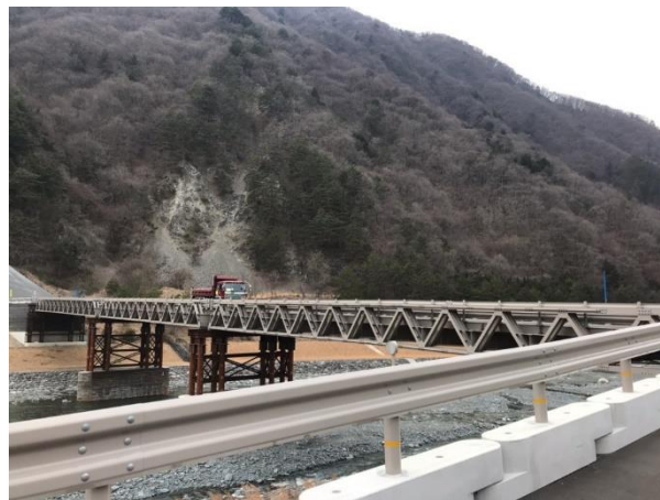
仮栈橋通行状況
