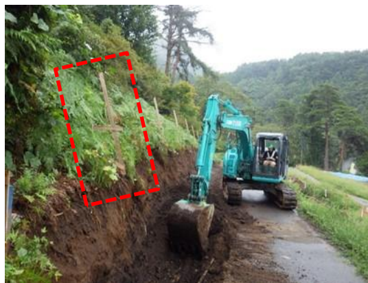
写真4-1-53 丁張設置による勾配管理（一例）
