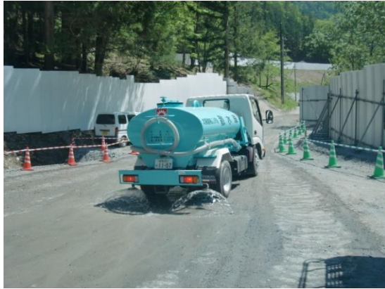
写真4-1-5 工事現場の散水状況 (一例)
