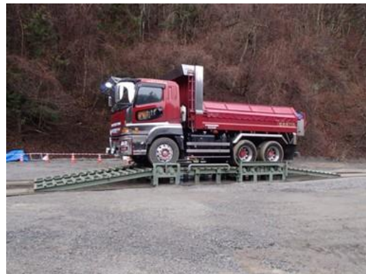
写真4-1-31 タイヤ洗浄機設置の状況（一例）
