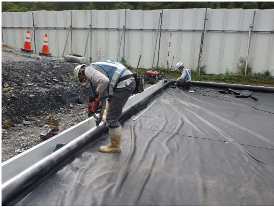
写真4-1-70 排水溝（区分土）設置状況（一例）
