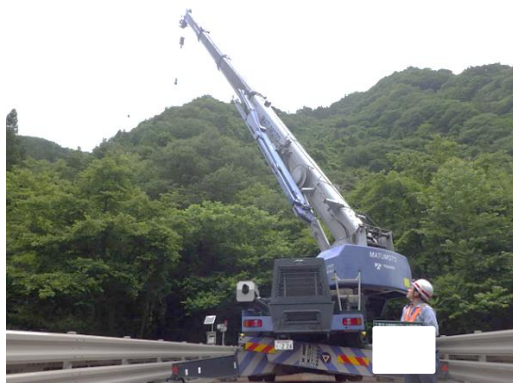
クレーン作業状況
