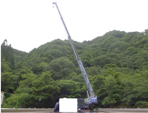
クレーン設置状況
