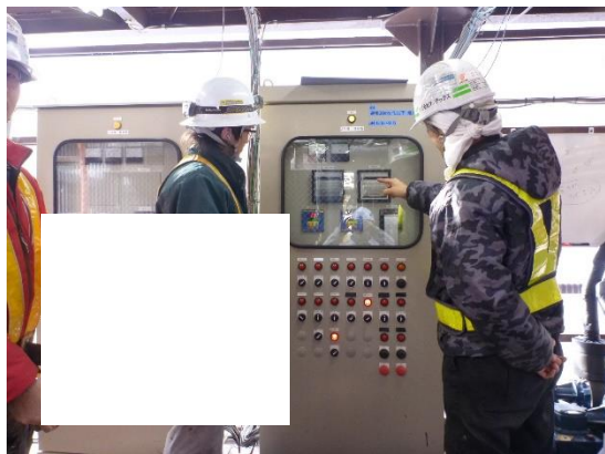
写真4-1-9 工事排水監視状況 (一例)
