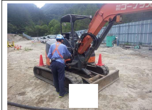
写真4-1-38 建設機械の点検及び整備による性能維持 (一例)
