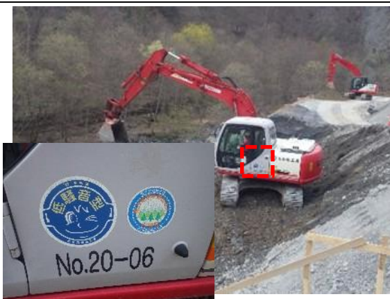
写真4-1-3 排出ガス対策型、低騒音型建設機械の採用 (一例)
