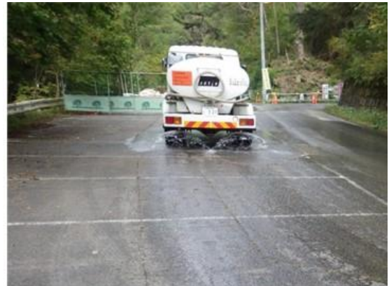
写真4-1-49 工事現場の散水状況 (一例)
