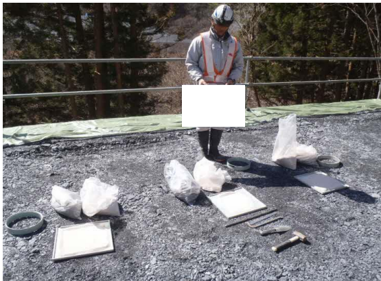
写真4-1-66 盛土材現場密度試験実施状況（一例）
