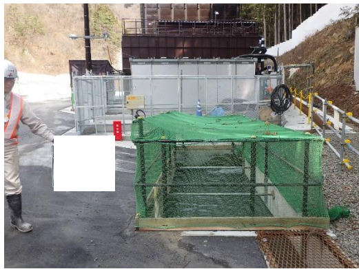
写真4-1-7 濁水処理設備の設置状況 (一例)
