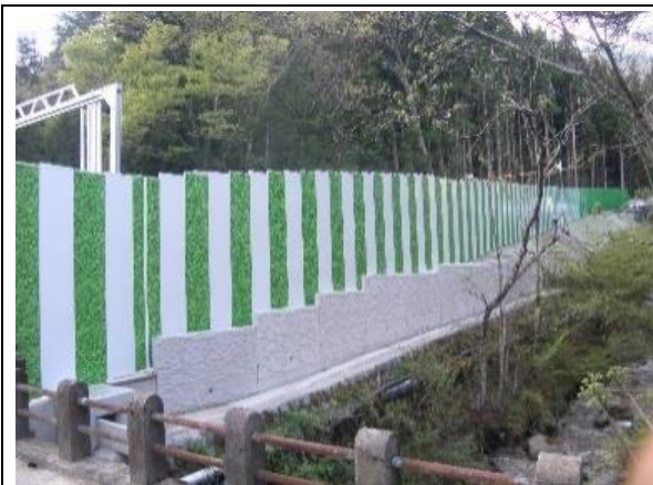
写真4-1-46 仮囲いの設置状況 (一例)
