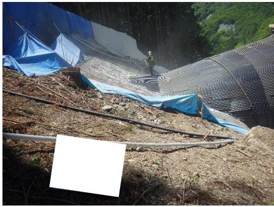
写真4-1-13 コンクリート吹付工の 実施状況（一例）
