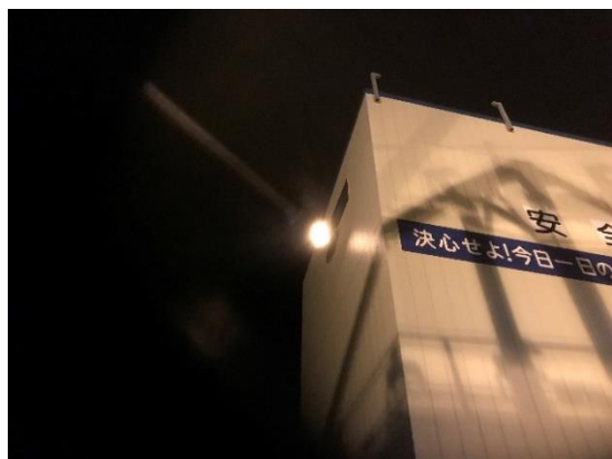
写真4-1-17 ナトリウム灯設置の状況 (一例)
