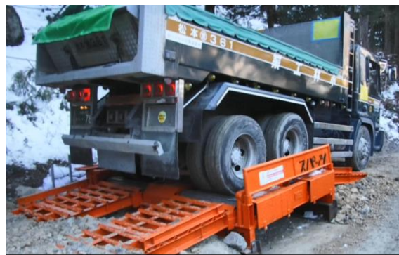
写真4-1-16 タイヤ洗浄機設置の状況 (一例)
