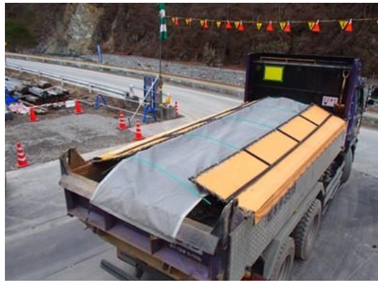
写真4-1-35 荷台への防塵シート敷設 (一例)
