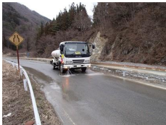
写真4-1-27 工事現場の散水状況 (一例)
