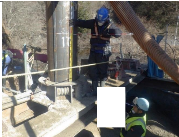
写真4-1-51 適切な構造及び工法の採用（一例）（鋼管杭の打ち込み長確認）
