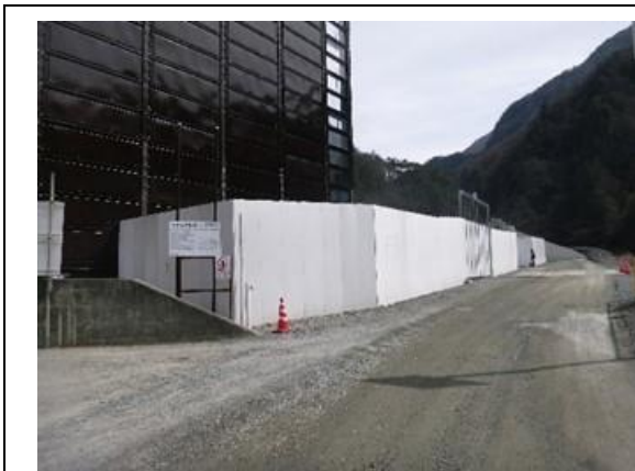
写真4-1-1 仮囲いの設置状況 (一例)
