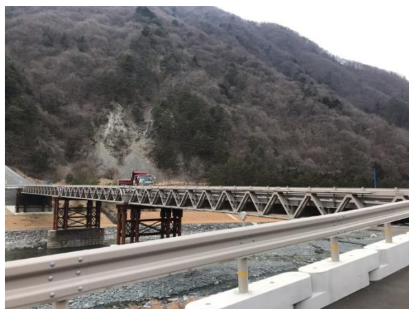
仮栈橋通行状況
