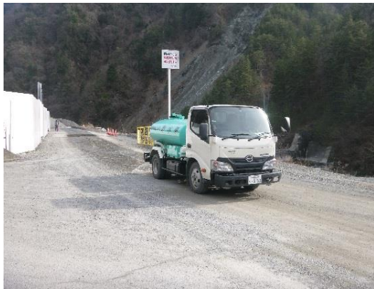
写真4-1-72 周辺道路の散水状況（一例）
