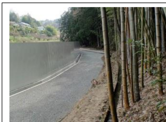
写真4-1-36 仮囲いの設置状況 (一例)
