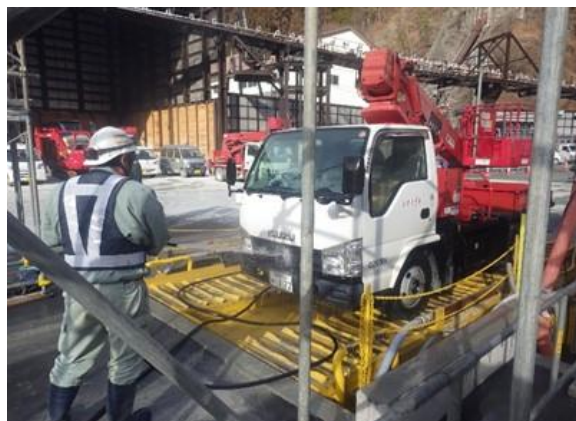
写真4-1-21 タイヤ洗浄の実施状況 (一例)
