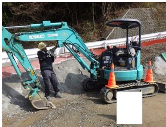
写真4-1-48 建設機械の点検及び整備による性能維持 (一例)
