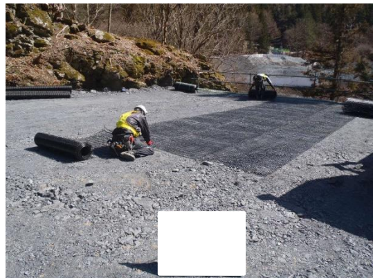
写真4-1-63 ジオテキスタイルの敷設状況 （一例）
