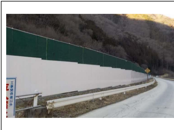
写真4-1-24 仮囲いの設置状況 (一例)
