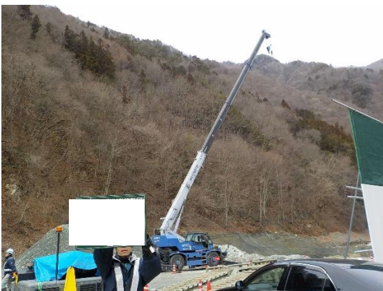
クレーン作業状況
