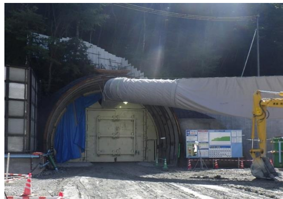
写真4-1-2 防音扉の設置 (一例)
