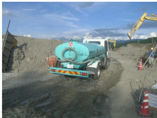
写真4-1-61 工事現場の散水状況 （一例）
