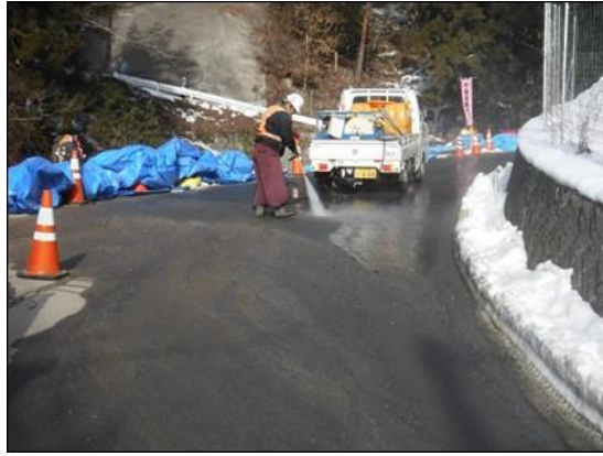
写真4-1-40 工事現場の散水状況 (一例)
