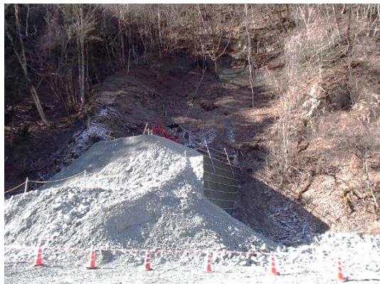
写真4-1-30 法面、斜面の保護状況
