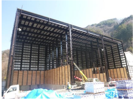
写真4-1-12 ヤード内仮置き場（重金属 対応判定場）の設置状況（一例）
