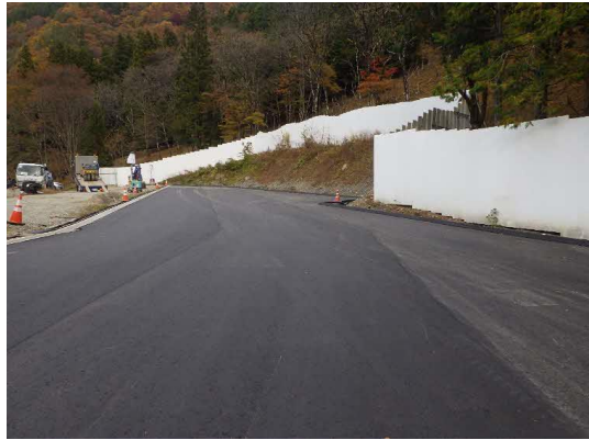
写真4-1-71 仮置き場の適正管理（アスファルト舗装）（一例）
