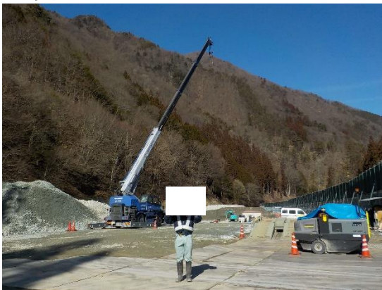
クレーン設置状況
