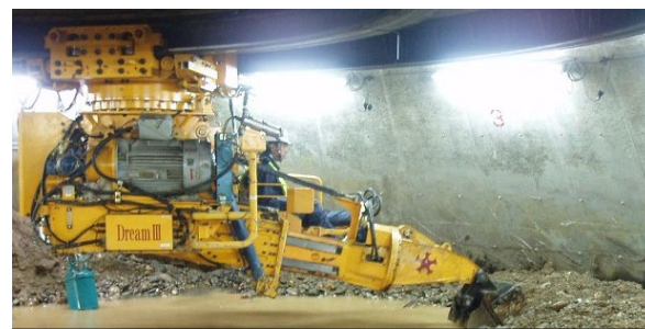
④掘削、沈設
