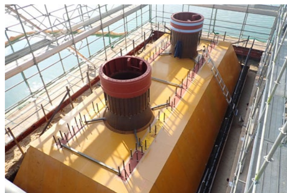
①作業室構築
