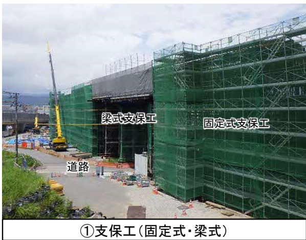
図 2-9 上部工の施工手順
