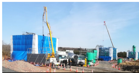
⑥橋脚部コンクリート打設
