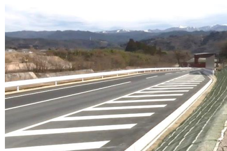
町道洞新線新設・拡幅
