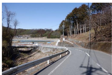
見通し不良区間の立木伐採
