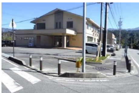
車止めポストの設置
