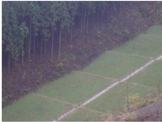
図 5-1 植生による法面保護工のイメージ
