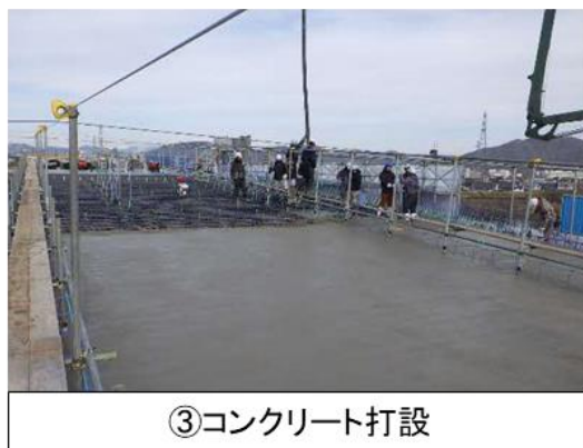
図2-19 上部工（場所打ち部）の施工手順
