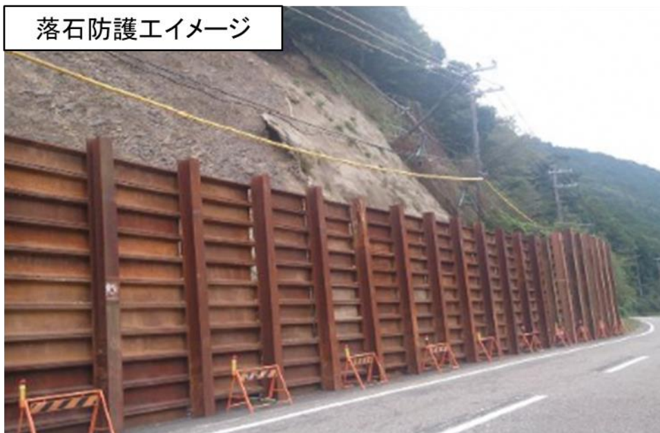
図2-25 落石防護工設置箇所の平面図と設置イメージ
