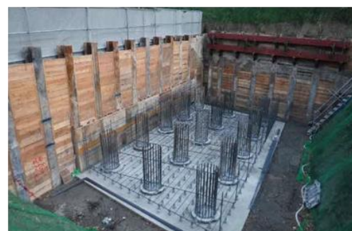
⑥フーチング基礎鉄筋組立
