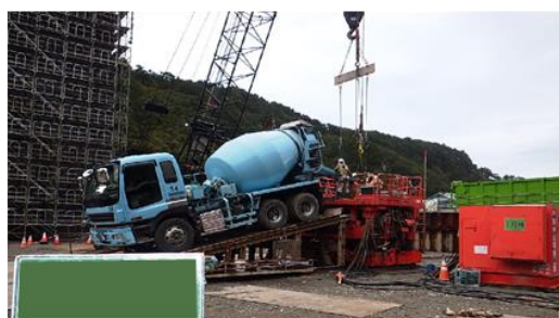
④コンクリート打設
