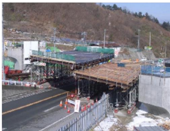
図 2-29 落下物防止工設置箇所の平面図と設置イメージ
