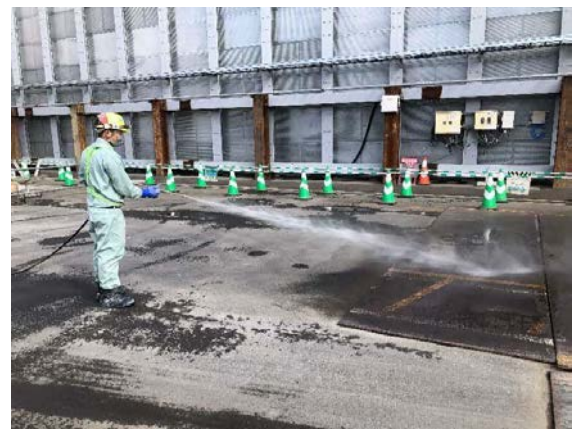
写真4-1-2-4 工事現場の清掃及び散水
