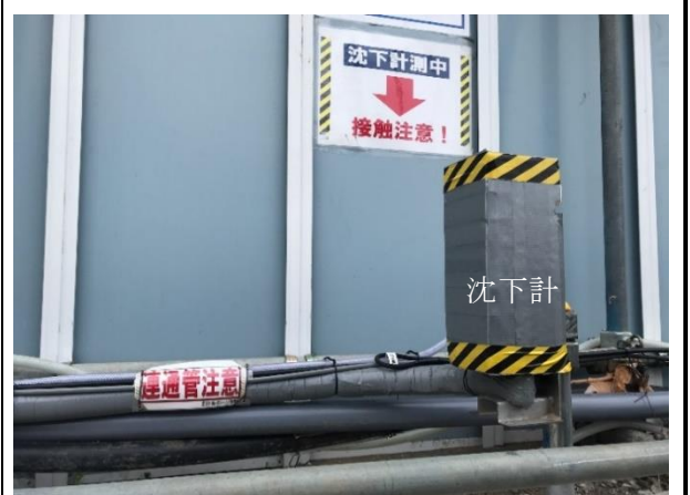
写真4-1-3-9 周辺地盤の計測管理
