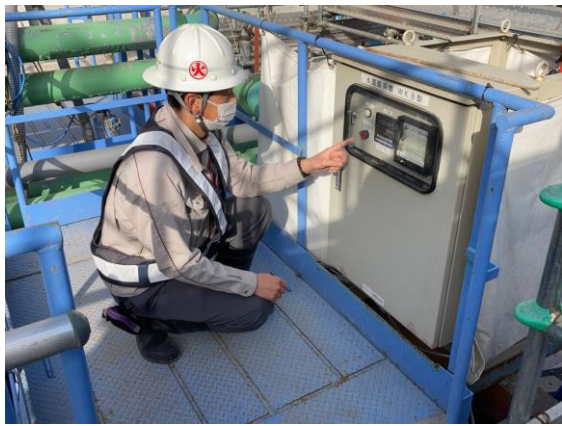
写真4-1-10-9 工事排水の監視の 実施状況
