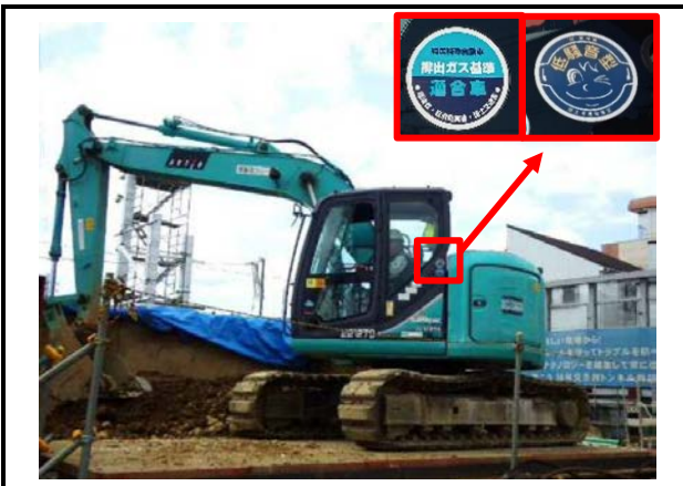
写真 4-1-7-1 排出ガス対策型建設機械の採用 低騒音型建設機械の採用
