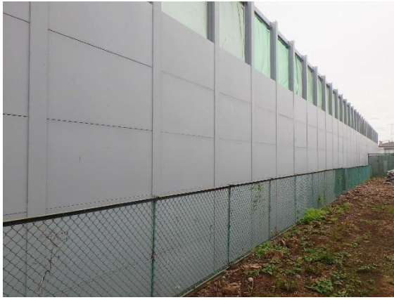
写真4-1-5-1 仮囲い・防音シート等の設置
