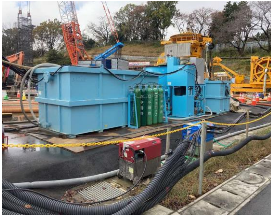
写真4-1-5-7 下水道への排水 工事排水の監視 工事排水の適切な処理
