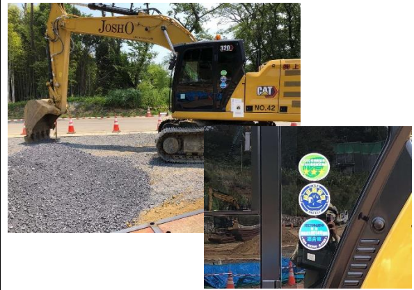
写真4-1-5-2 排出ガス対策型建設機械の採用
