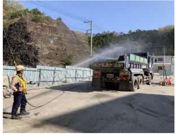
写真4-1-11-14 荷台への防塵シート敷設及び散水
