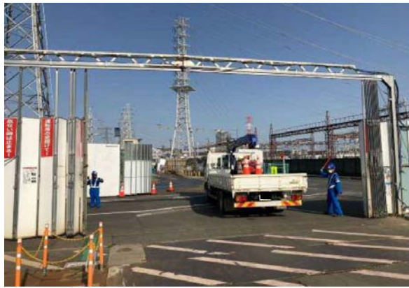
写真 4-1-7-15 交通誘導員による誘導
