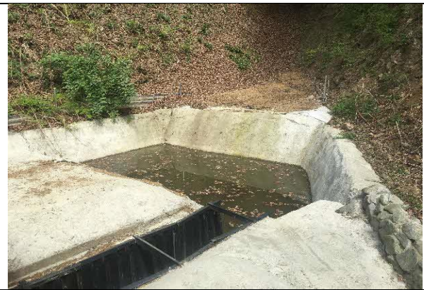
写真4-1-11-10 濁水処理設備及び仮設沈砂池の設置
