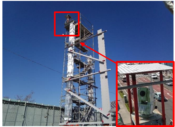
写真 4-1-7-10 山留め材及び周辺地盤の計測管理 (測量機器を用いた地盤面高さの計測)
