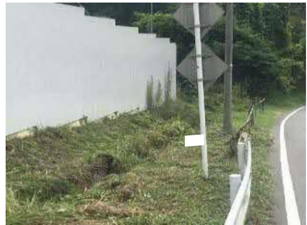
写真4-1-11-12 工事施工ヤード等の緑化、林縁保護植栽による 動物の生息環境の確保
