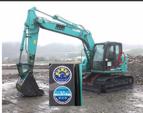
写真 4-1-8-2 排出ガス対策型建設機械の採用 低騒音型建設機械の採用
