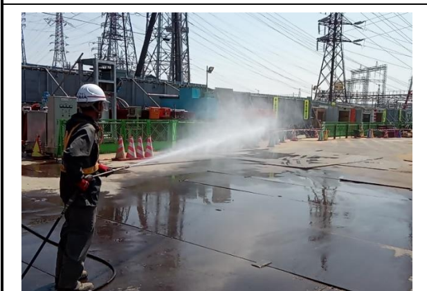
写真 4-1-7-5 工事現場の清掃及び散水
