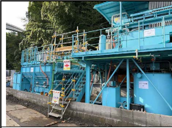
写真 4-1-9-7 工事排水の適切な処理 処理設備の点検・整備による性能維持 (濁水処理設備)
