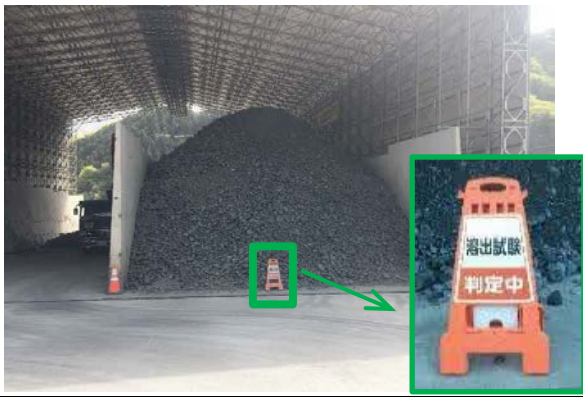
写真4-1-11-9 発生土に含まれる自然由来の重金属等の定期的な調査
