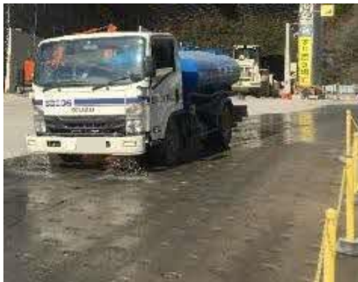
写真4-1-11-5 工事現場の清掃及び散水
