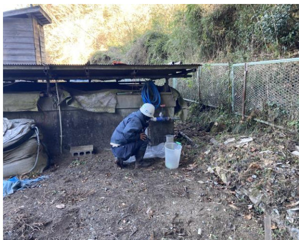
写真4-1-10-11 地下水の継続的な監視 実施状況
