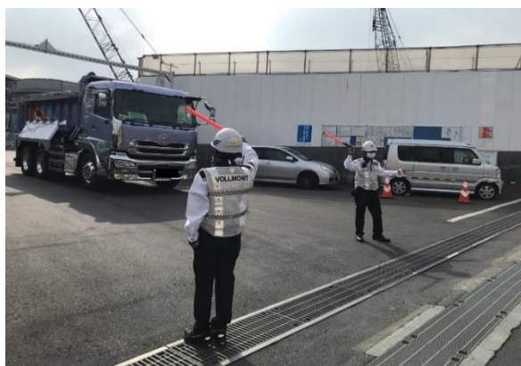
写真4-1-3-16 交通誘導員による誘導
