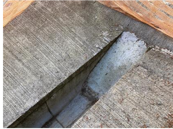
写真4-1-10-14 小動物が脱出可能な側溝の設置 実施状況
