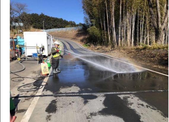
写真4-1-5-6 工事現場の清掃及び散水
