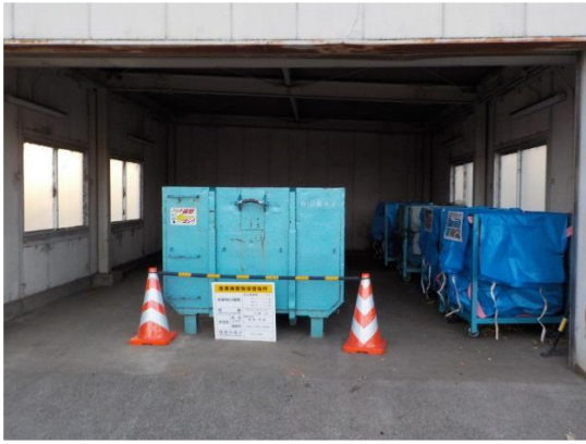
写真4-1-6-7 副産物の分別・再資源化
