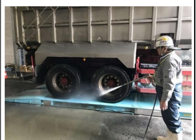
写真4-1-3-11 資材及び機械の運搬に用いる 車両の出入口等の清掃、散水及びタイヤの洗浄
