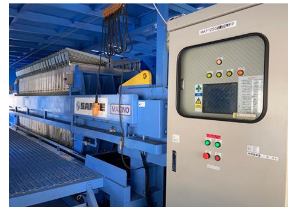
写真4-1-10-16 建設汚泥の脱水処理 実施状況
