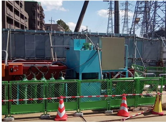
写真 4-1-7-7 工事排水の監視、 工事排水の適切な処理
