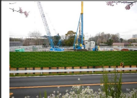
写真4-1-1-15 仮設物の形式、色合いの検討 (多摩川堤防からの視認性に配慮した色合いの仮囲いを採用)
