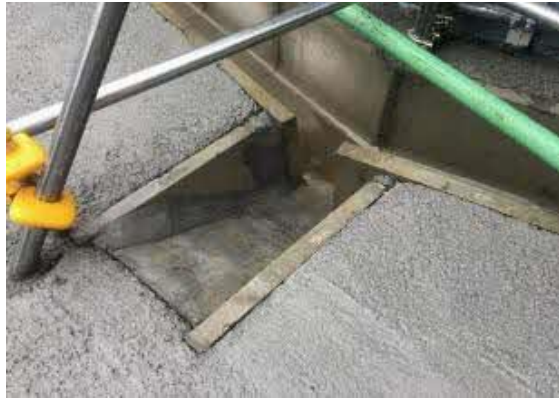
写真4-1-11-7 小動物が脱出可能な側溝の設置
