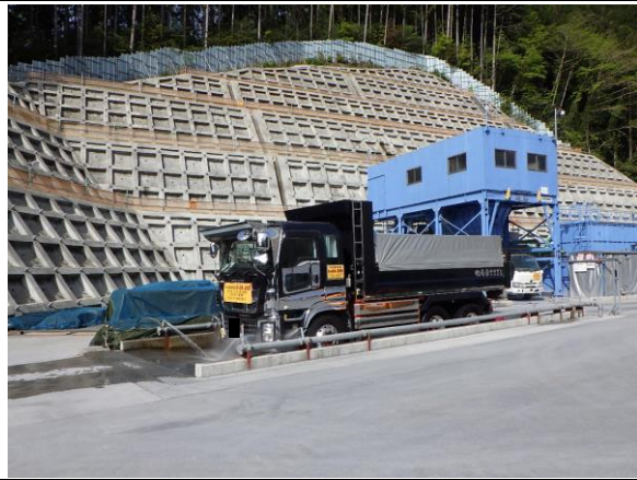
写真4-1-10-7 タイヤの洗浄実施状況
