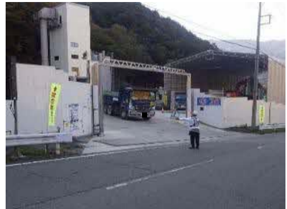
写真4-1-11-16 通誘導員による誘導
