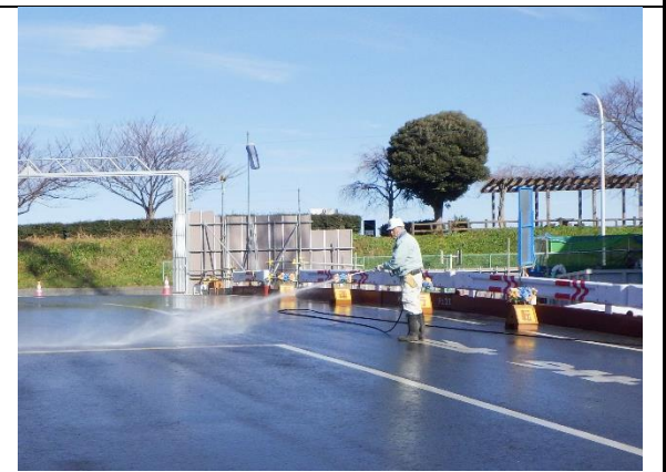
写真4-1-1-4 工事現場の清掃及び散水
