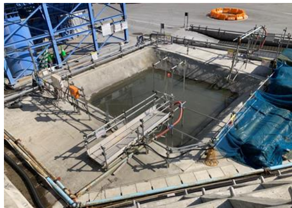
写真4-1-10-15 仮設沈砂池の設置 実施状況
