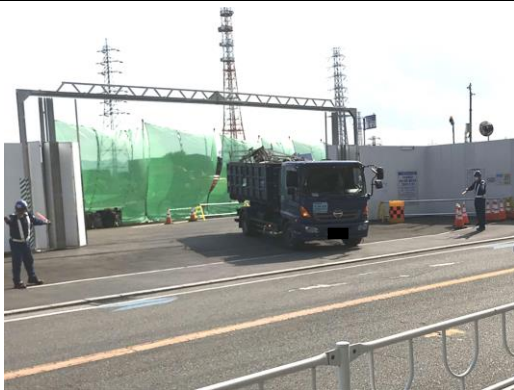
写真4-1-6-11 交通誘導員による誘導
