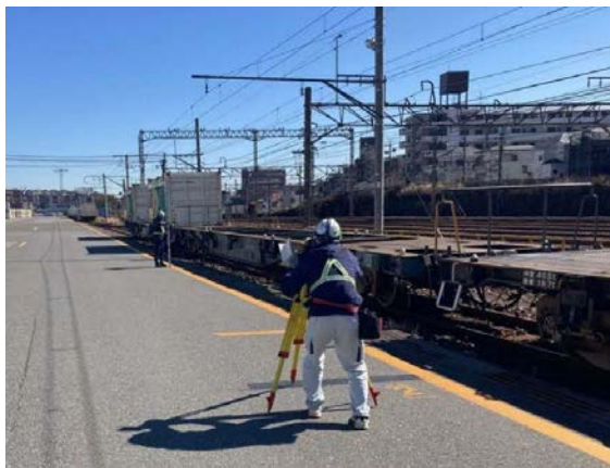
写真4-1-2-9 山留め材及び周辺地盤の計測管理
