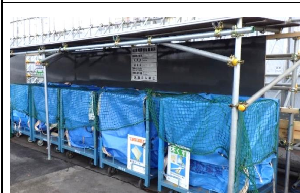
写真4-1-1-9 副産物の分別・再資源化
