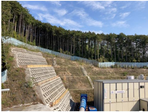
写真4-1-10-3 仮囲い設置の実施状況
