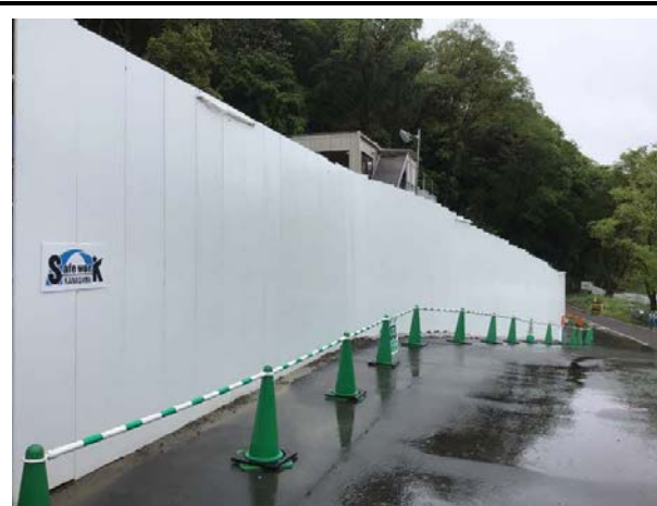
写真 4-1-8-1 仮囲い・防音シート等の設置
