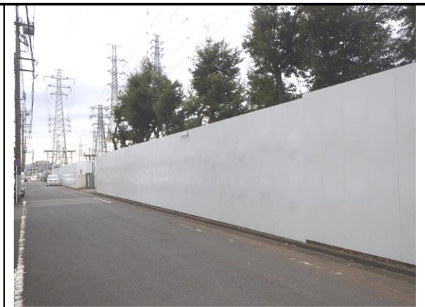
写真4-1-6-2 仮囲い・防音シート等の設置状況 (仮囲い設置状況)
