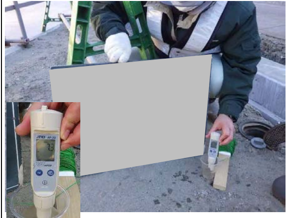
写真4-1-2-8 薬液注入工法における指針の順守 (水質検査のための採水状況)
