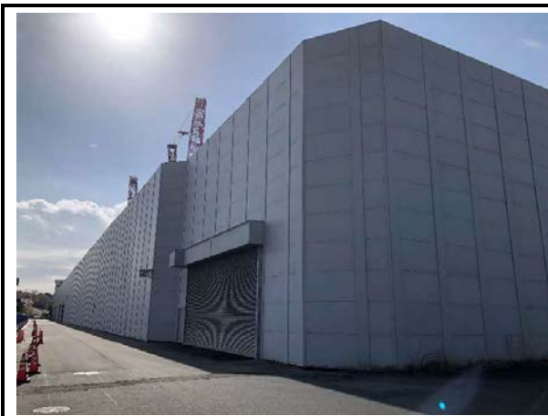
写真4-1-2-1 仮囲い・防音シート等の設置状況 (仮囲い設置状況)
