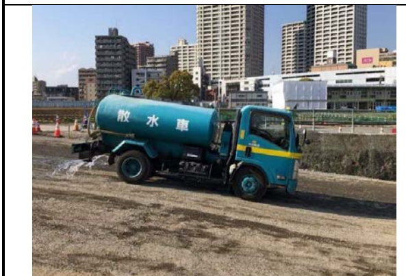
写真4-1-6-5 工事現場の清掃及び散水
