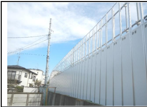
写真4-1-1-1 仮囲い・防音シート等の設置状況 (仮囲い設置状況)
