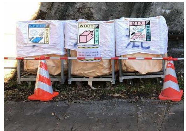
写真 4-1-9-6 副産物の分別・再資源化
