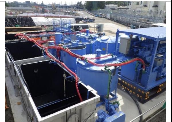
写真4-1-1-6 工事排水の適切な処理 下水道への排水
