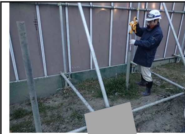
写真4-1-1-7 地下水の継続的な監視
