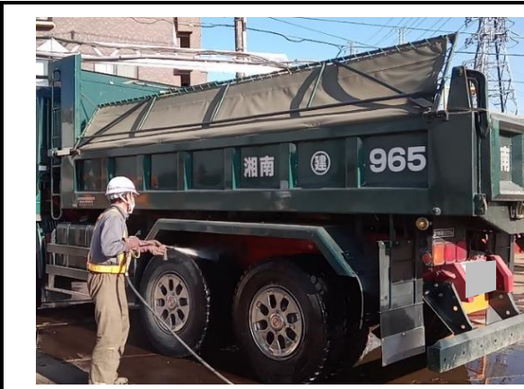
写真 4-1-7-13 資材及び機械の運搬に用いる車両の出入り口等の 清掃、散水及びタイヤの洗浄
