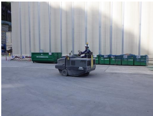
写真4-1-10-5 工事現場の清掃実施状況
