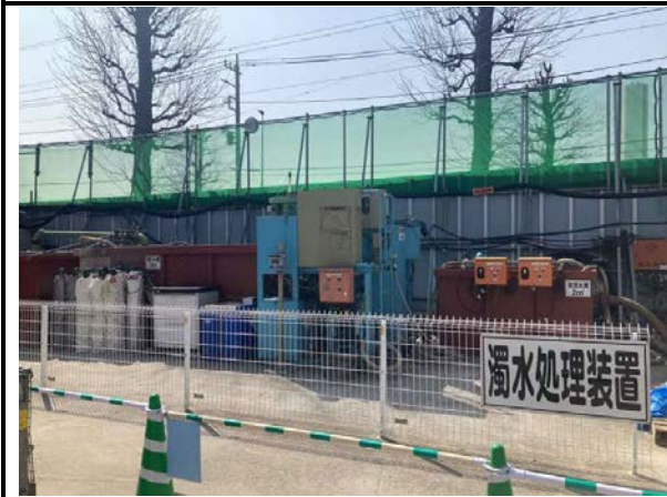
写真 4-1-4-6 工事排水の監視 工事排水の適切な処理 (濁水処理設備の設置状況)
