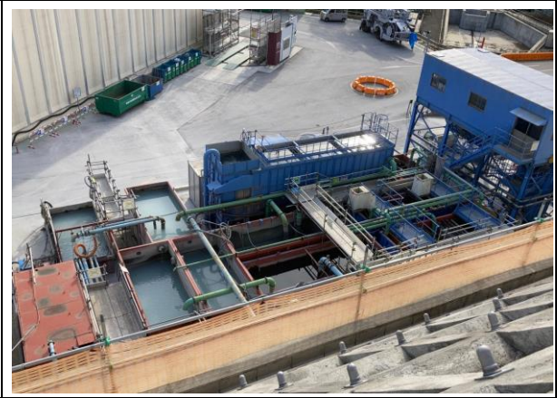
写真4-1-10-8 工事排水の適切な処理 実施状況
