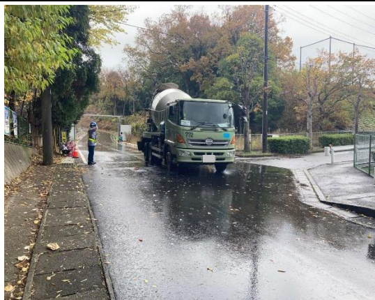
写真4-1-5-17 交通誘導員による誘導
