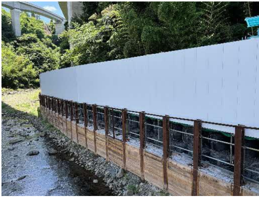
写真 4-1-9-3 仮囲い・防音シート等の設置状況 (仮囲い設置状況)
