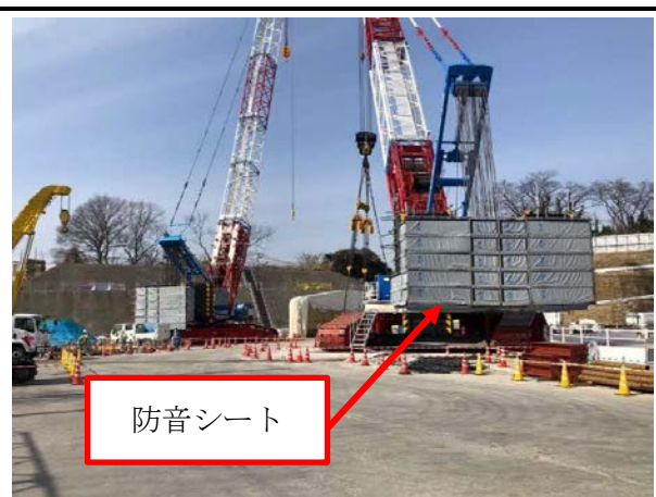
写真 4-1-4-1(2) 仮囲い・防音シート等の設置状況
