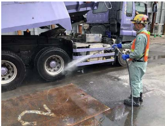
写真4-1-2-11 資材及び機械の運搬に用いる車両の 出入り口等の清掃、散水及びタイヤの洗浄
