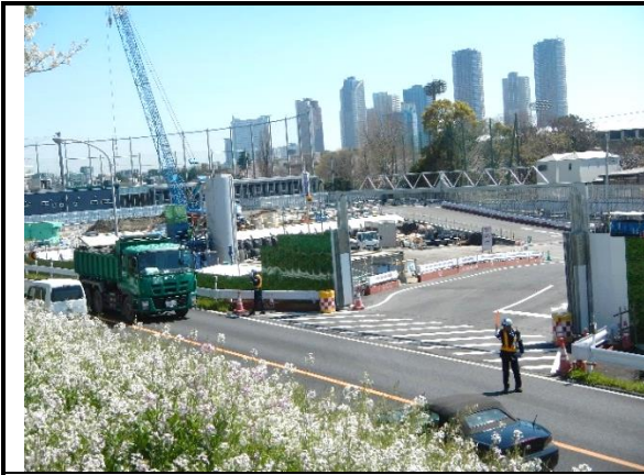
写真4-1-1-13 交通誘導員による誘導
