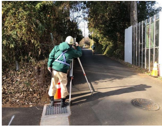
写真4-1-5-11 山留材及び周辺地盤の計測管理
