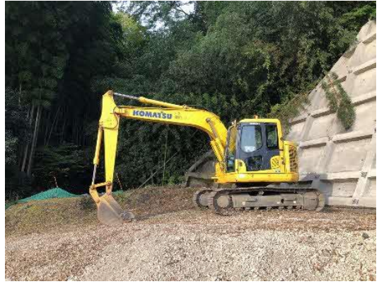
写真 4-1-9-2 工事規模に合わせた建設機械の選定
