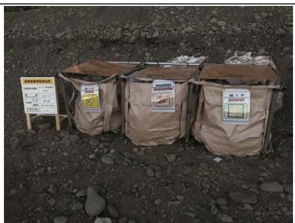
写真 4-1-8-6 副産物の分別・再資源化
