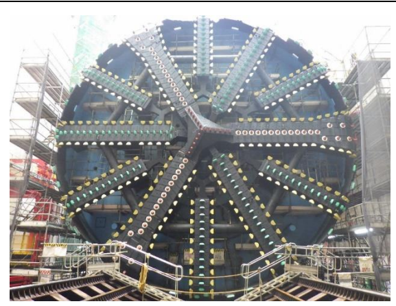
写真4-1-2-6 適切な構造及び工法の採用 (密閉性の高いシールド工法の採用)
