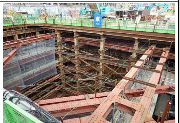
写真 4-1-7-6 止水性の高い山留め工法等の採用、 地質の状況等に応じた山留め工法等の採用
