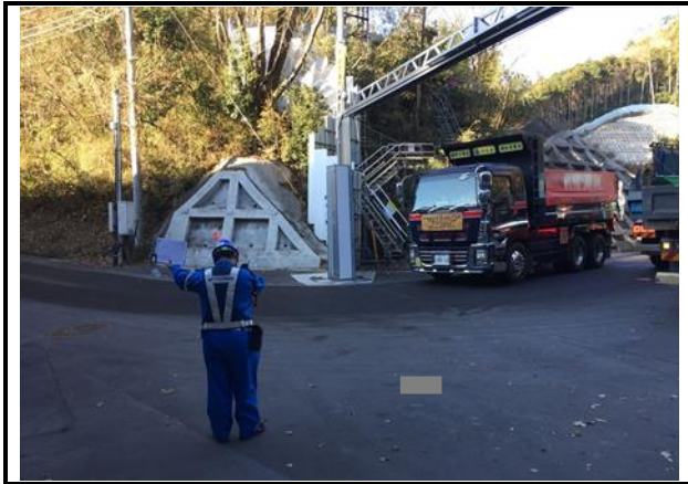
写真4-1-10-19 交通誘導員による誘導の 実施状況
