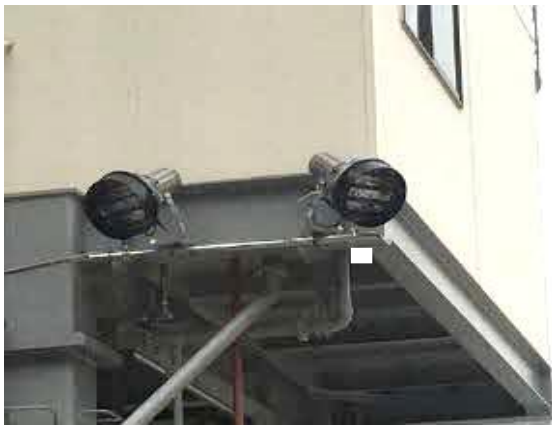
写真4-1-11-11 照明の漏れ出しの抑制 (遮光設備 (ルーバー) の設置)
