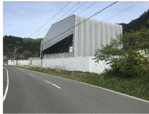
写真4-1-11-2 仮囲い・防音シート等の設置状況 (仮囲い設置状況)
