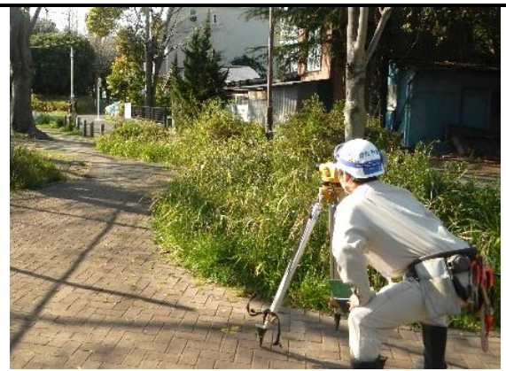
写真4-1-1-8 山留め材及び周辺地盤の計測管理
