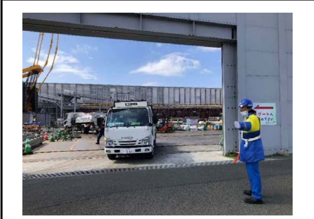
写真4-1-2-15 交通誘導員による誘導
