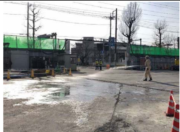
写真 4-1-4-5 工事現場の清掃及び散水
