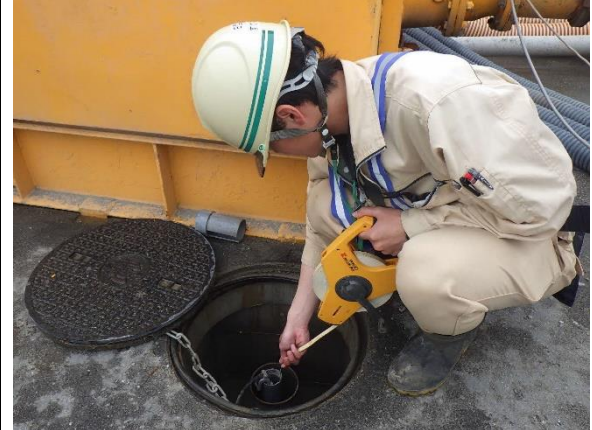
写真4-1-5-10 地下水の継続的な監視
