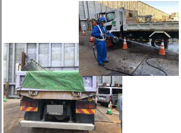
写真4-1-2-10 荷台への防塵シート敷設及び散水
