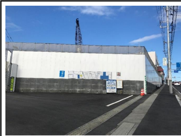
写真4-1-3-1 (1) 仮囲い・防音シート等の設置状況 (仮囲い設置状況)
