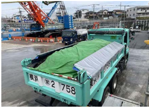
写真4-1-3-12 ダンプ荷台への防じんシート敷設及び散水
