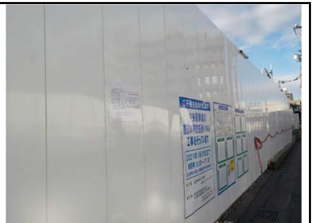
写真 4-1-7-2 仮囲い・防音シート等の設置状況 (仮囲い設置状況)
