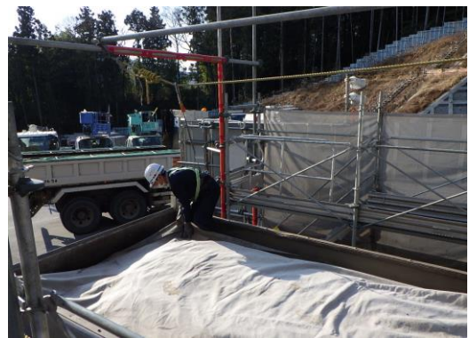
写真4-1-10-6 荷台への防塵シート敷設 実施状況
