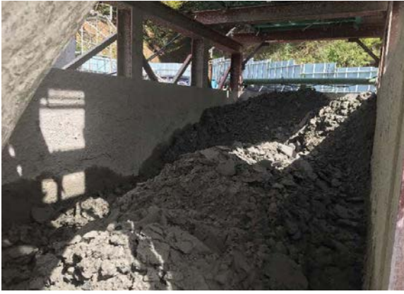
写真4-1-11-13 建設汚泥の脱水処理
