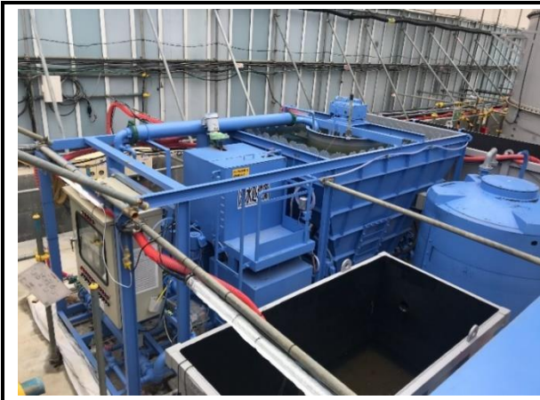
写真4-1-3-6 下水道への排水、工事排水の監視
