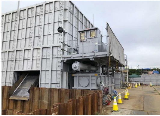
写真4-1-5-13 建設汚泥の脱水処理
