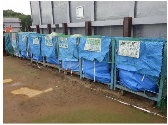
写真4-1-5-14 副産物の分別・再資源化
