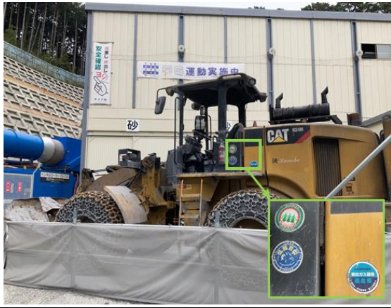
写真4-1-10-1 排出ガス対策・低騒音・低炭素型 建設機械採用の実施状況
