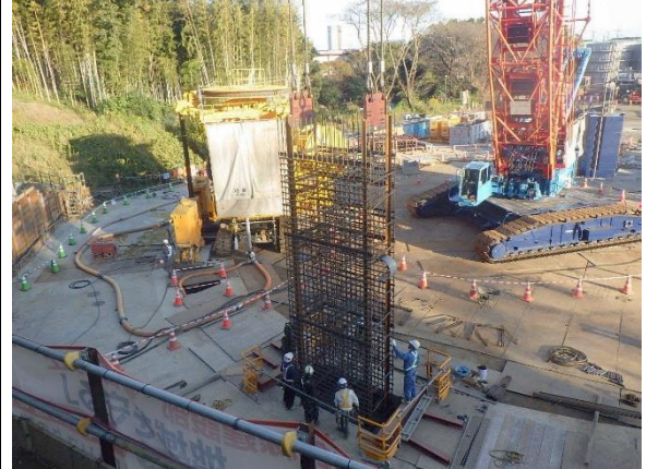
写真4-1-5-8 止水性の高い山留め工法等の採用 地質の状況等に応じた山留め工法等の採用
