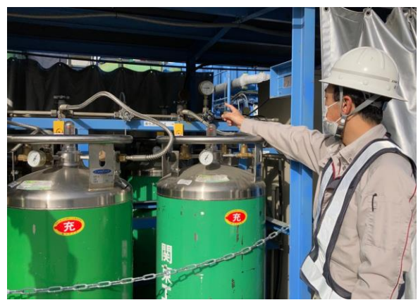
写真4-1-10-10 処理設備の点検・整備の 実施状況
