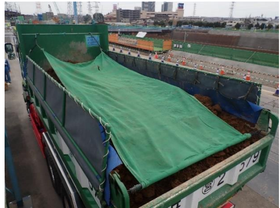
写真4-1-6-8 荷台への防じんシート敷設及び散水
