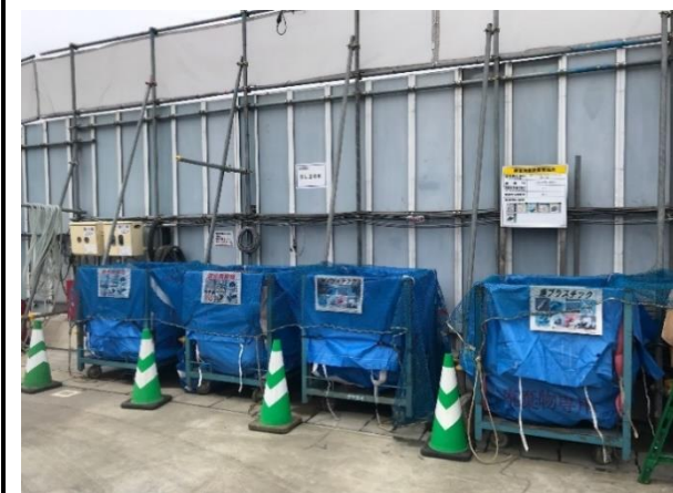
写真4-1-3-10 副産物の分別・再資源化
