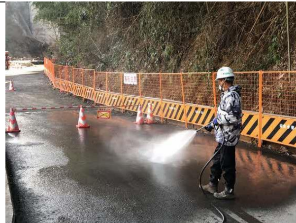
写真 4-1-9-5 工事現場の清掃及び散水
