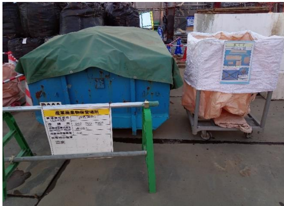
写真 4-1-7-11 副産物の分別・再資源化
