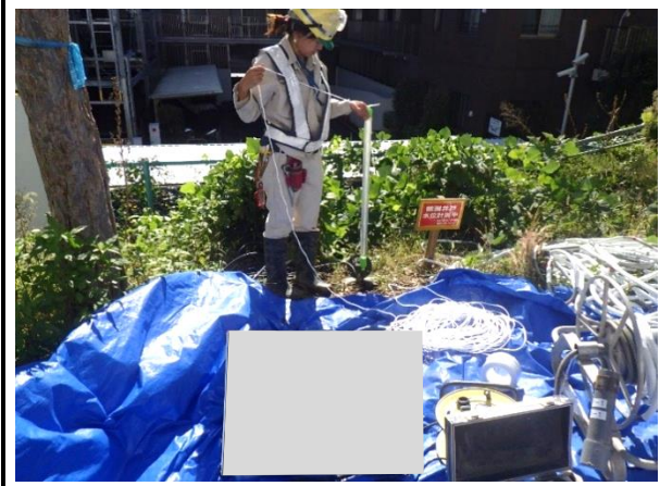
写真4-1-3-8 地下水の継続的な監視
