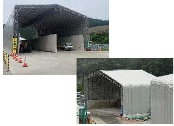
写真4-1-11-8 仮置場における発生土の適切な管理
