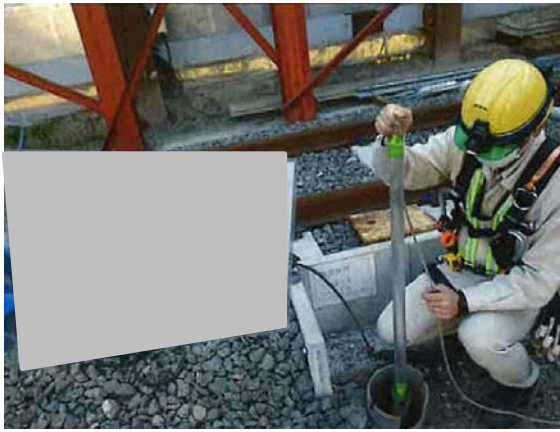
写真4-1-2-7 地下水の継続的な監視
