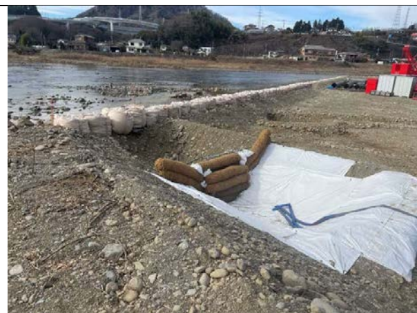
写真 4-1-8-5 工事排水の適切な処理 (仮沈砂地の設置)
