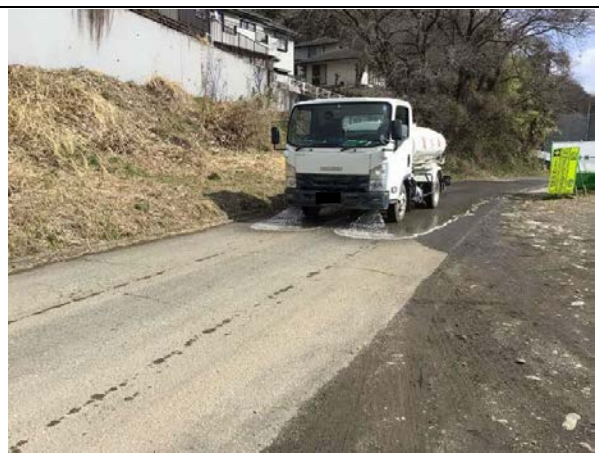
写真 4-1-8-4 工事現場の清掃及び散水
