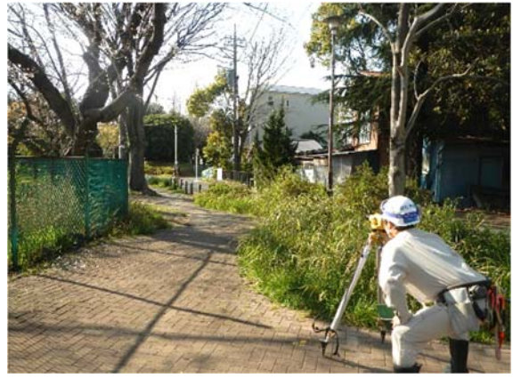
写真 4-1-1-8 山留め材及び周辺地盤の計測管理
