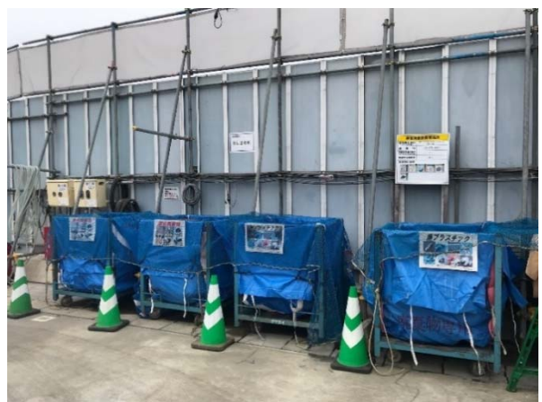
写真 4-1-4-11 副産物の分別・再資源化
