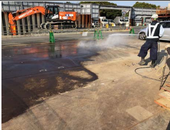
写真 4-1-3-3 工事現場の清掃及び散水
