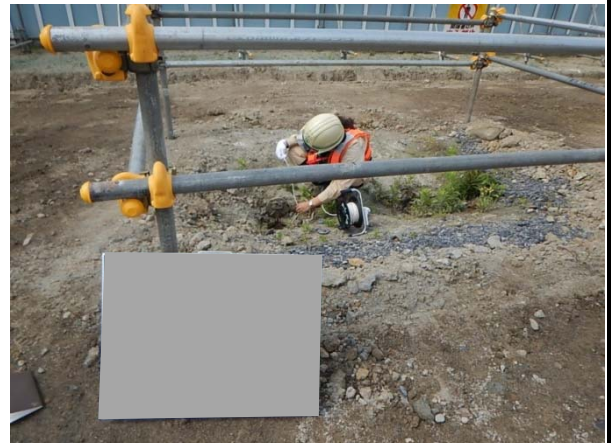
写真 4-1-2-6 地下水の継続的な監視
