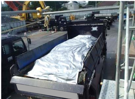
写真 4-1-1-11 ダンプ荷台への防じんシート敷設及び散水
