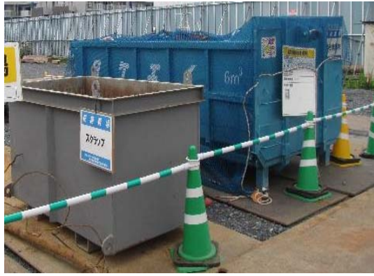
写真 4-1-5-13 副産物の分別・再資源化
