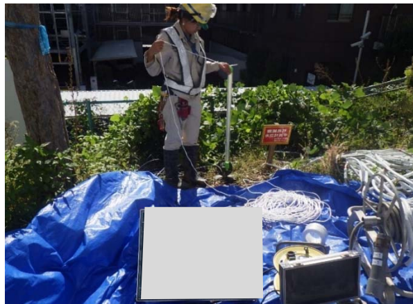
写真 4-1-4-8 地下水の継続的な監視
