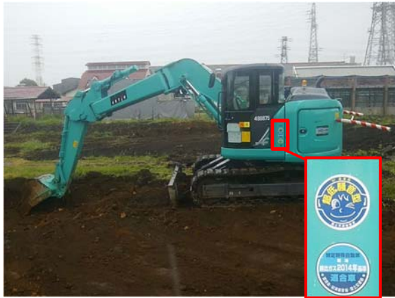
写真 4-1-8-1 排出ガス対策型建設機械の採用 低騒音型建設機械の採用
