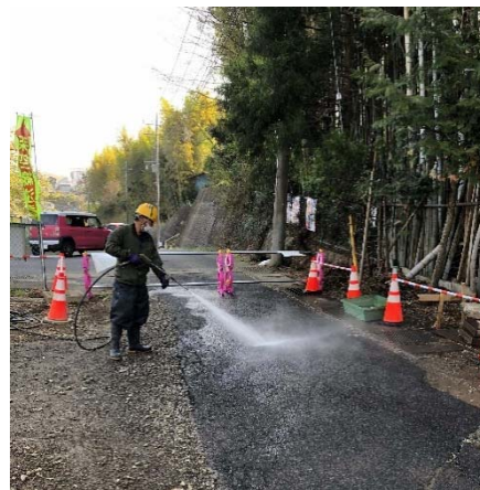
写真 4-1-7-4 工事現場の清掃及び散水
