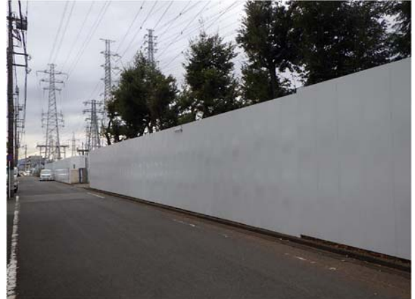
写真 4-1-8-2 仮囲い・防音シート等の設置
