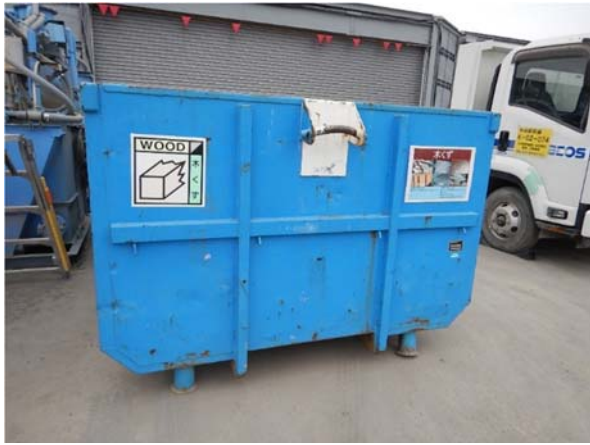
写真 4-1-2-7 副産物の分別・再資源化
