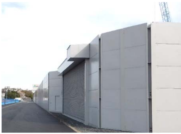
写真 4-1-2-1 仮囲い・防音シート等の設置
