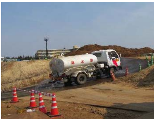
写真 4-1-5-5 工事現場の清掃及び散水
