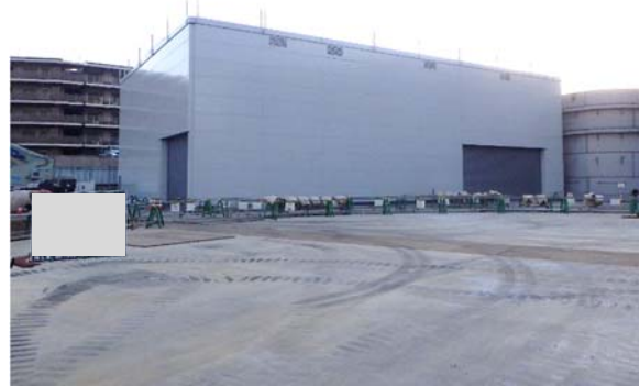
写真 4-1-4-1 (2) 仮囲い・防音シート等の設置 (防音ハウスの設置、舗装状況(粉じん対策))
