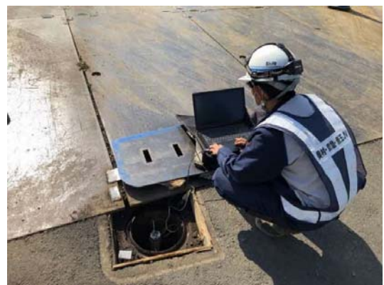
写真 4-1-8-6 地下水等の継続的な監視 (常時計測のデータ監視の様子)
