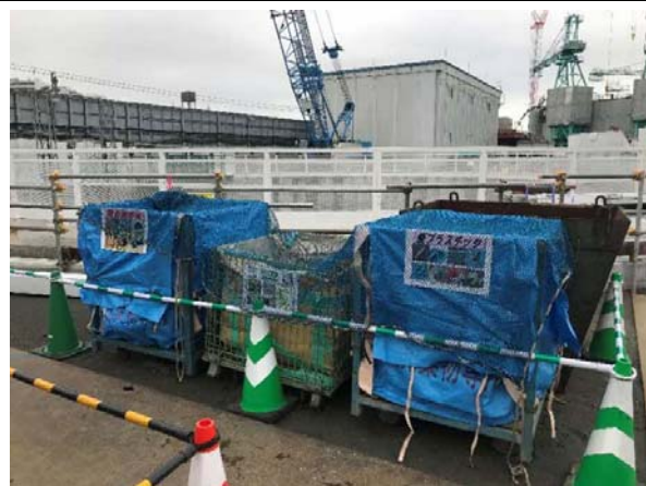
写真 4-1-3-5 副産物の分別・再資源化
