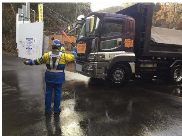
写真 4-1-10-9 交通誘導員による誘導
