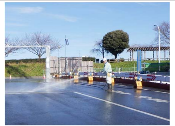
写真 4-1-1-4 工事現場の清掃及び散水
