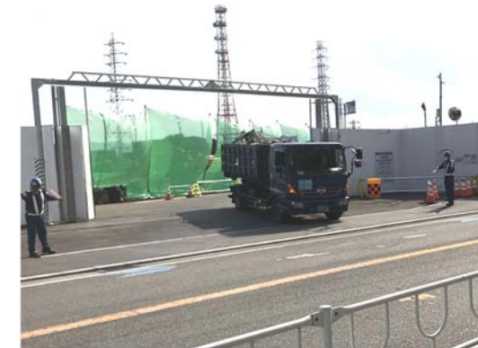
写真 4-1-8-11 交通誘導員による誘導
