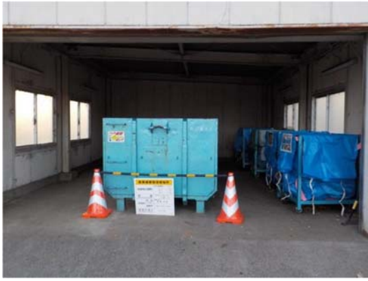
写真 4-1-8-7 副産物の分別・再資源化
