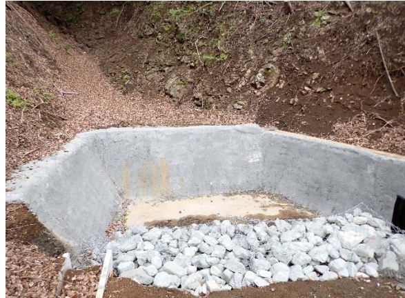
写真 4-1-11-8 濁水処理設備及び仮設沈砂池の設置
