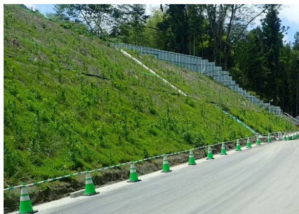
写真 4-1-10-10 外来種の拡大抑制 (のり面の植生)
