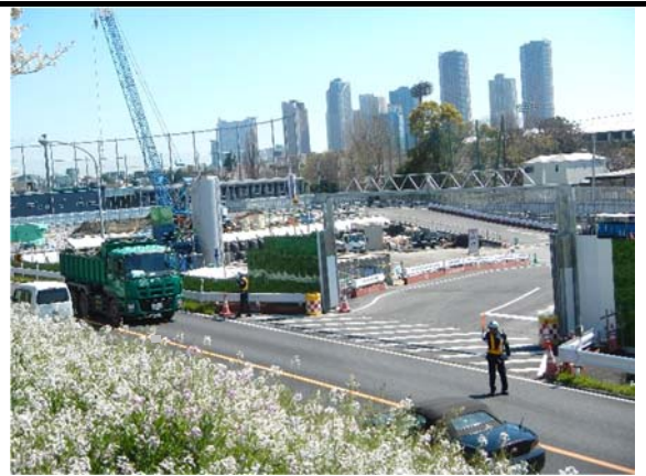
写真 4-1-1-14 交通誘導員による誘導
