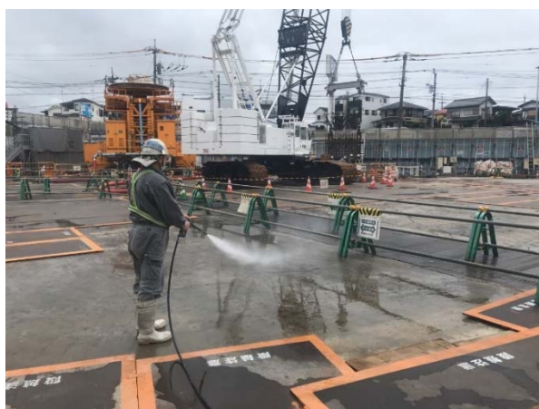
写真 4-1-4-4 工事現場の清掃及び散水
