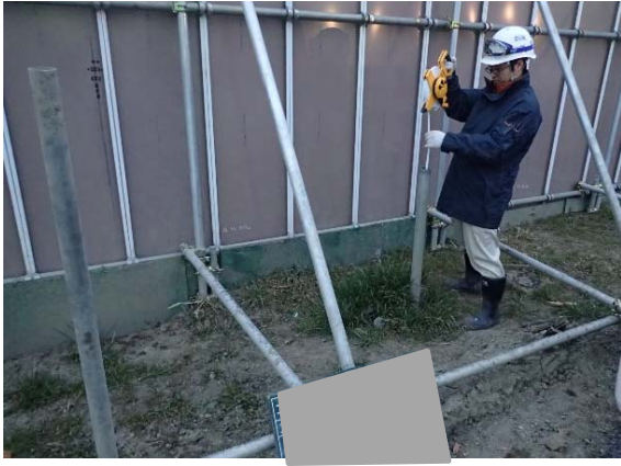
写真 4-1-1-7 地下水の継続的な監視
