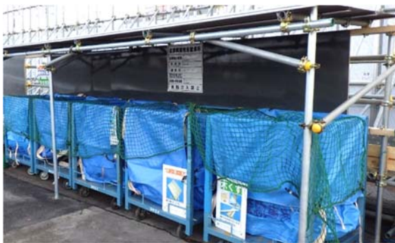
写真 4-1-1-9 副産物の分別・再資源化
