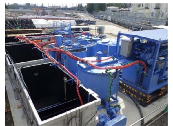
写真 4-1-1-6 工事排水の適切な処理 下水道への排水
