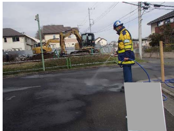
写真 4-1-6-4 工事現場の清掃及び散水
