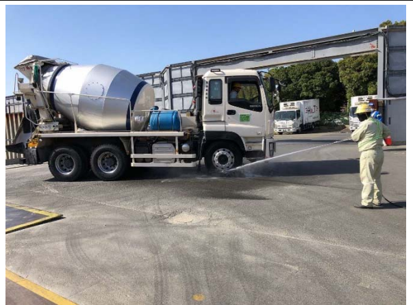
写真 4-1-3-6 資材及び機械の運搬に用いる車両の 出入口等の清掃、散水及びタイヤの洗浄
