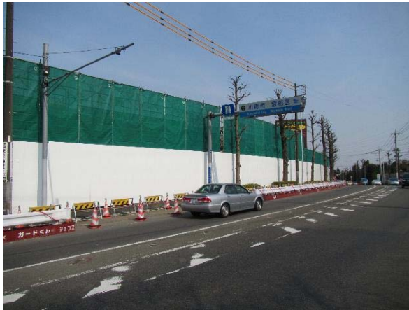
写真 4-1-5-1 仮囲い・防音シート等の設置
