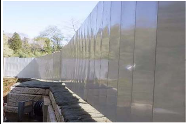
写真 4-1-10-2 仮囲い等の設置
