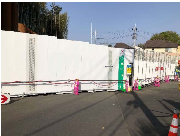
写真 4-1-7-1 仮囲い・防音シート等の設置
