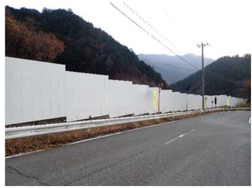
写真 4-1-11-2 仮囲い等の設置
