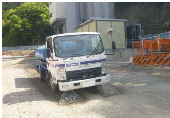
写真 4-1-11-5 工事現場の清掃及び散水
