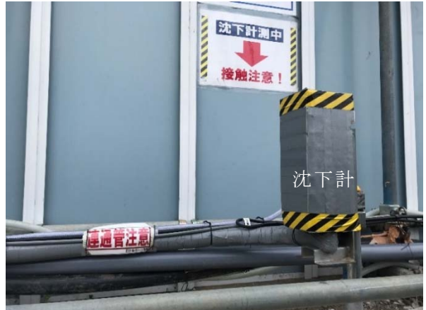
写真 4-1-4-9 周辺地盤の計測管理
