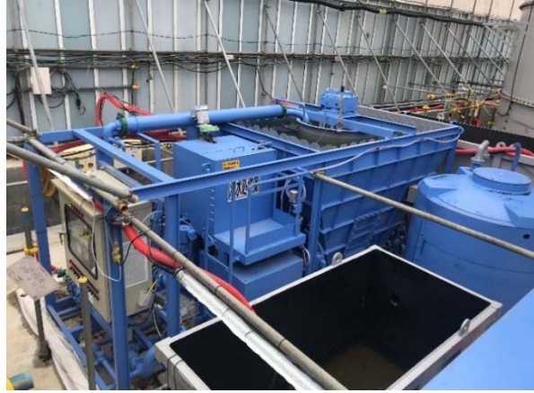
写真 4-1-4-6 下水道への排水 工事排水の監視
