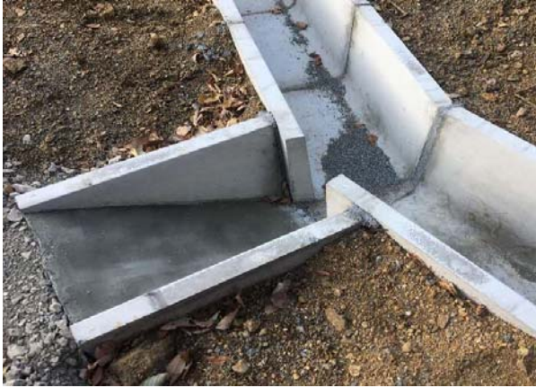
写真 4-1-11-7 小動物が脱出可能な側溝の設置
