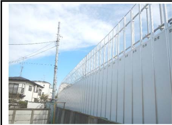
写真 4-1-1-1 仮囲いの設置
