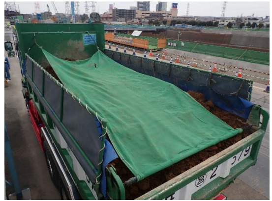
写真 4-1-8-8 荷台への防じんシート敷設及び散水
