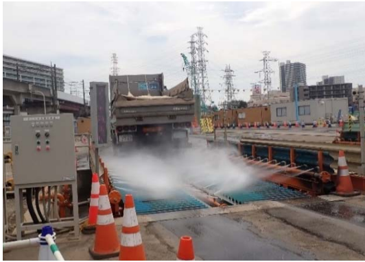
写真 4-1-8-9 資材及び機械の運搬に用いる車両の出入り口等の 清掃、散水及びタイヤの洗浄
