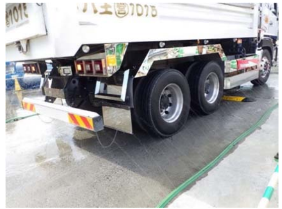
写真 4-1-5-14 資材及び機械の運搬に用いる車両の出入口等の清掃、散水及びタイヤの洗浄
