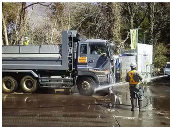
写真 4-1-10-7 資材及び機械の運搬に用いる車両の出入り口等の 清掃、散水及びタイヤの洗浄
