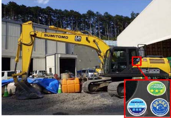
写真 4-1-10-1 排出ガス対策型建設機械の採用 低騒音型建設機械の採用
