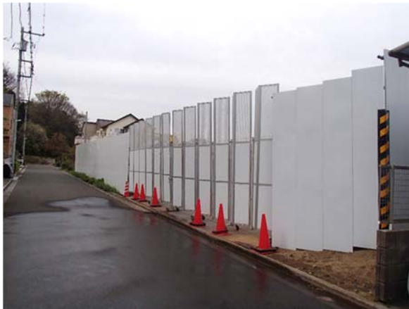
写真 4-1-6-1 仮囲い・防音シート等の設置
