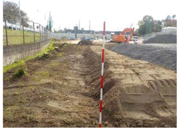
写真 4-1-1-8 建設発生土の再利用 (ヤード内発生土を出入口盛土に転用)
