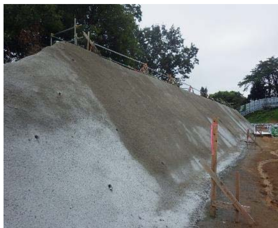
写真 4-1-4-11 法面等の保護 (モルタル吹付)
