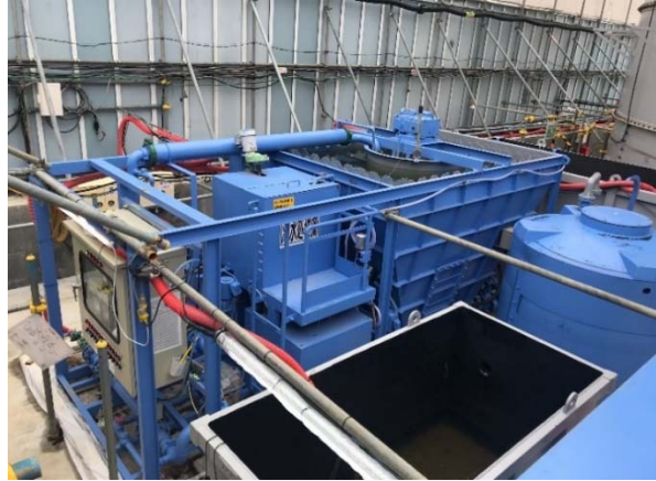
写真 4-1-3-6 下水道への排水 工事排水の監視 工事排水の適切な処理
