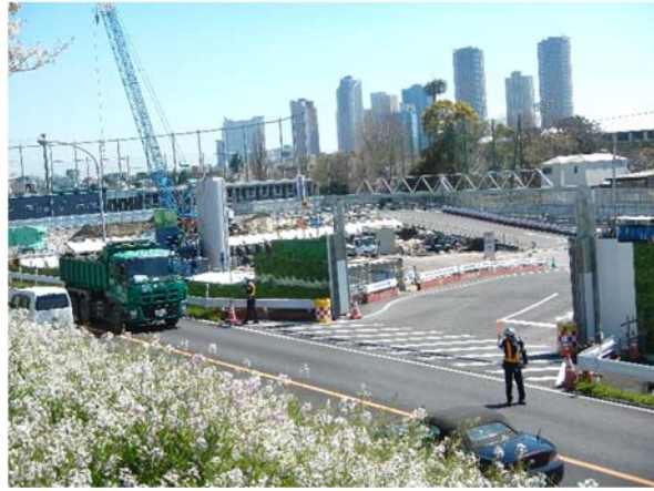
写真 4-1-1-13 交通誘導員による誘導
