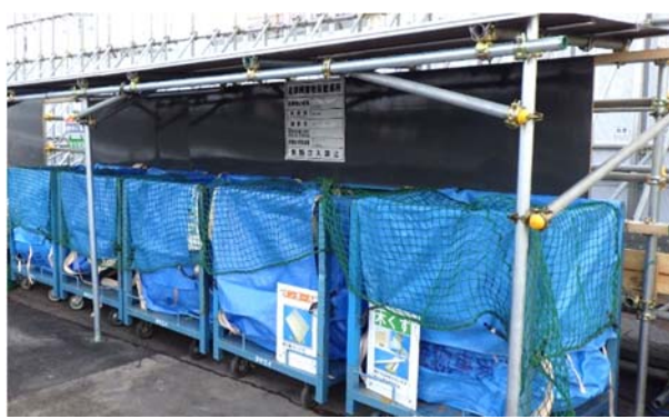
写真 4-1-1-9 副産物の分別・再資源化
