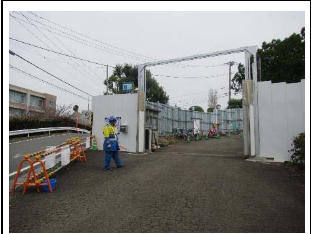
写真 4-1-4-19 交通誘導員による誘導
