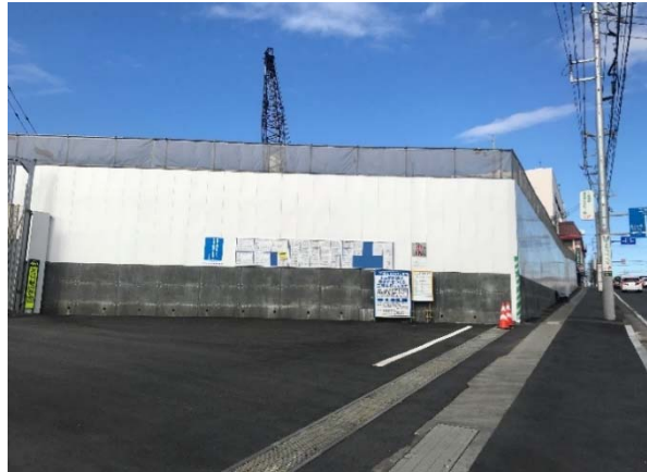
写真 4-1-3-1 (1) 仮囲い・防音シート等の設置
