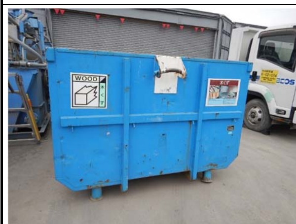
写真 4-1-2-8 副産物の分別・再資源化
