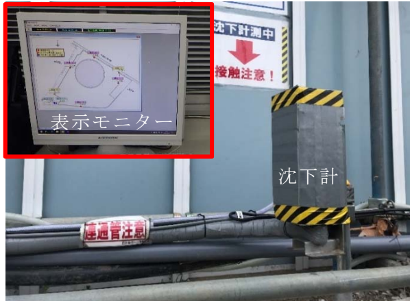
写真 4-1-3-9 周辺地盤の計測管理
