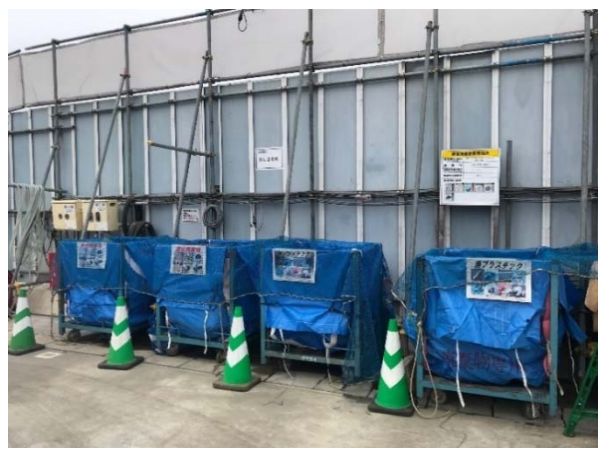
写真 4-1-3-11 副産物の分別・再資源化
