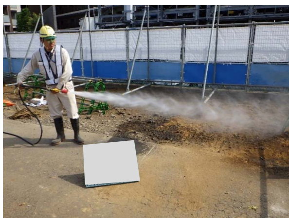
写真 4-1-3-4 工事現場の清掃及び散水
