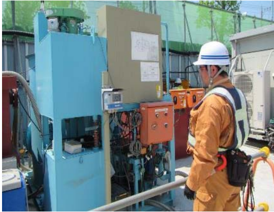
写真 4-1-4-7 工事排水の適切な処理
