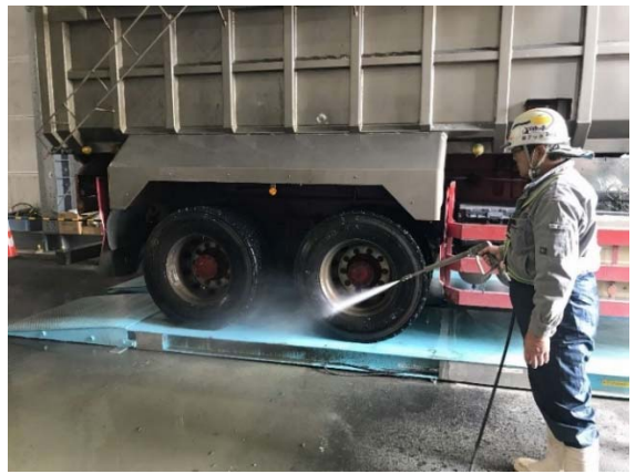
写真 4-1-3-13 資材及び機械の運搬に用いる車両の出入口等の清掃、散水及びタイヤの洗浄
