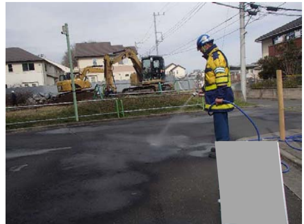
写真 4-1-5-4 工事現場の清掃及び散水
