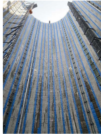
写真 4-1-4-8 止水性の高い山留め工法等の採用
