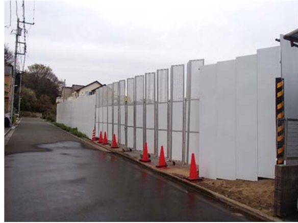
写真 4-1-5-1 仮囲い・防音シート等の設置
