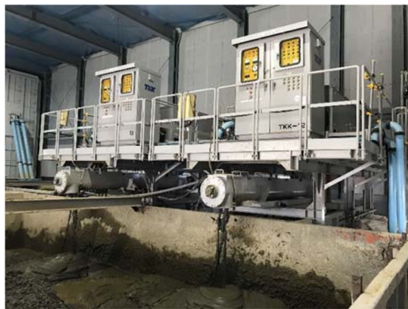
写真 4-1-3-10 建設汚泥の脱水処理 (遠心分離機による汚水と汚泥の分離状況)
