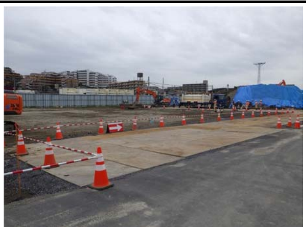
写真 4-1-2-1(2) 仮囲い・防音シート等の設置 (敷鉄板・舗装による飛散防止)
