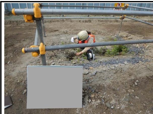
写真 4-1-2-6 地下水の継続的な監視
