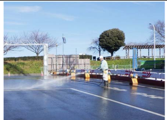
写真 4-1-1-4 工事現場の清掃及び散水
