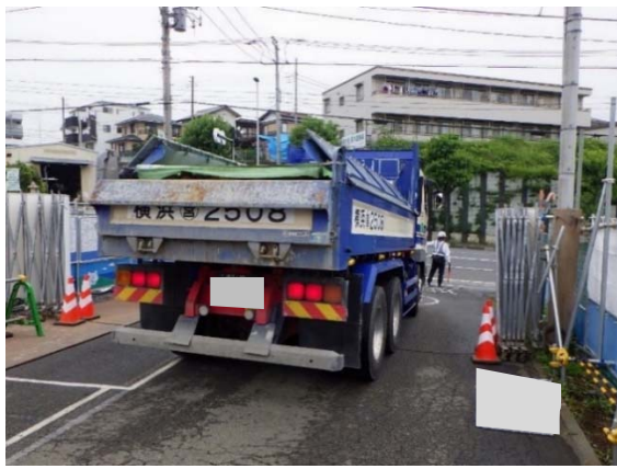
写真 4-1-3-12 荷台への防塵シート敷設
