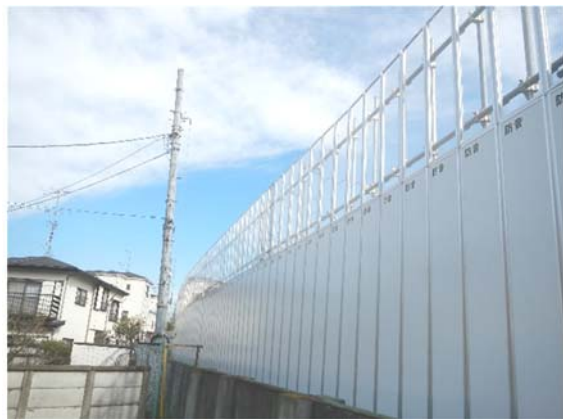
写真 4-1-1-1 仮囲い・防音シート等の設置
