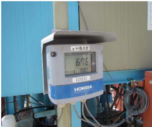
写真 4-1-4-9 工事排水の監視
