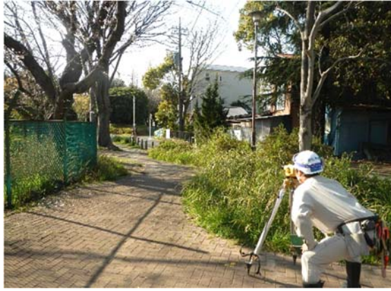
写真 4-1-1-7 山留め材及び周辺地盤の計測管理
