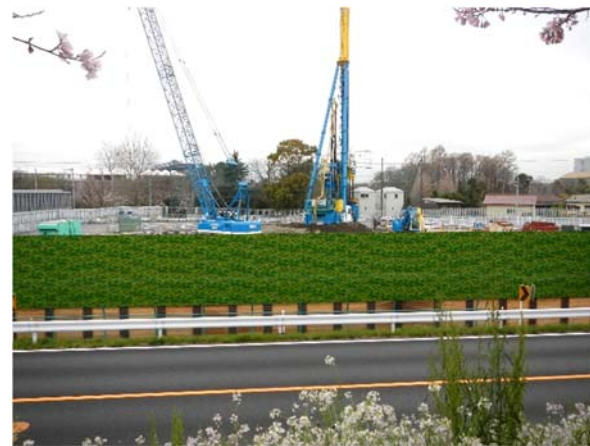
写真 4-1-1-15 仮設物の形式、色合いの検討 (多摩川堤防からの視認性に配慮した 色合いの仮囲いを採用)
