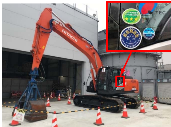
写真 4-1-3-2 排出ガス対策型建設機械の採用 低騒音・低振動型建設機械の採用
