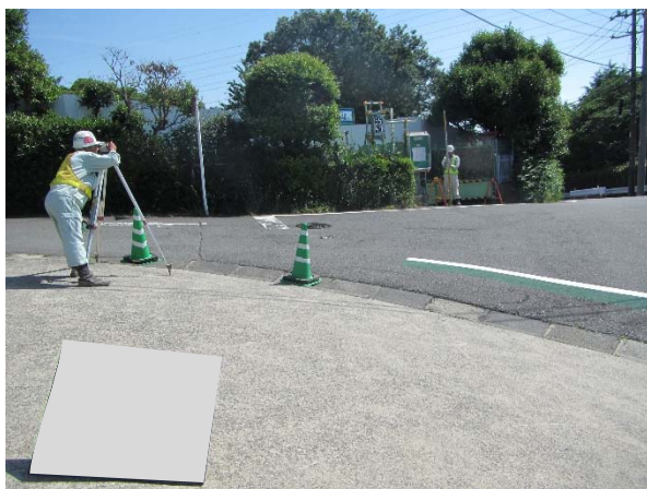
写真 4-1-2-11 周辺地盤の計測管理
