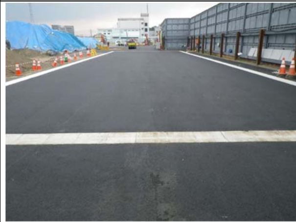
写真 4-1-1-7(1) 土砂ピットにおける発生土の適切な管理 (舗装による重金属等流出防止)
