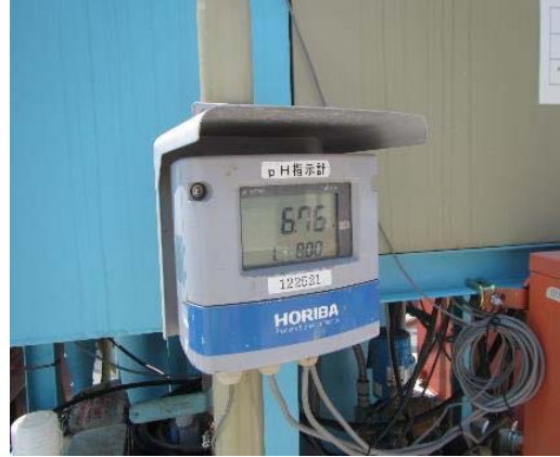
写真 4-1-2-8 工事排水の監視
