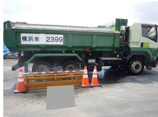
写真 4-1-1-13 資材及び機械の運搬に用いる車両の 出入口等の清掃、散水及びタイヤの洗浄
