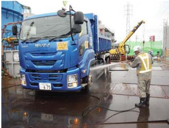
写真 4-1-3-8 資材及び機械の運搬に用いる車両の 出入口等の清掃、散水及びタイヤの洗浄
