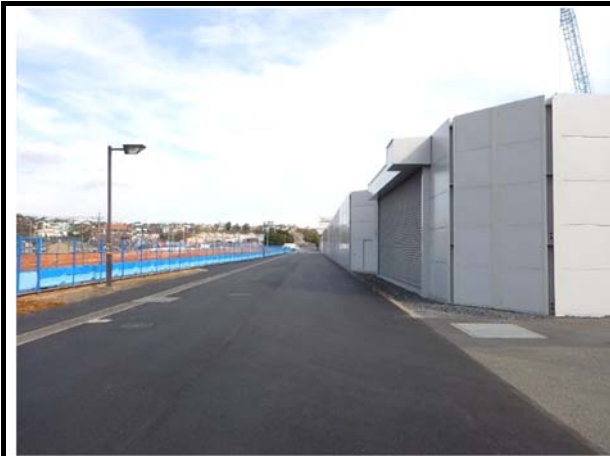
写真 4-1-1-1(1) 仮囲い・防音シート等の設置
