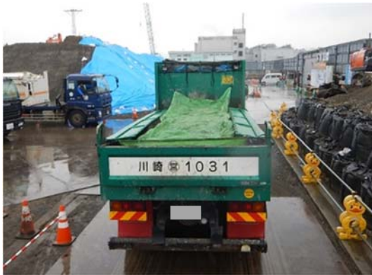
写真 4-1-1-12 荷台への防塵シート敷設及び散水
