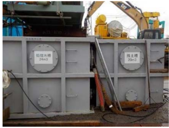
写真 4-1-3-7 建設汚泥の脱水処理
