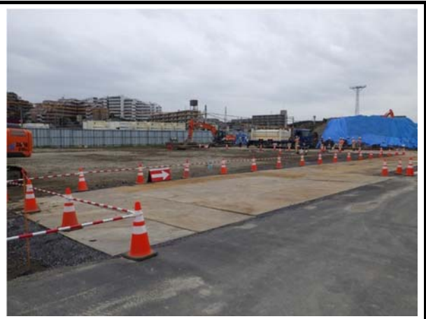
写真 4-1-1-1(2) 仮囲い・防音シート等の設置 (敷鉄板・舗装による飛散防止)
