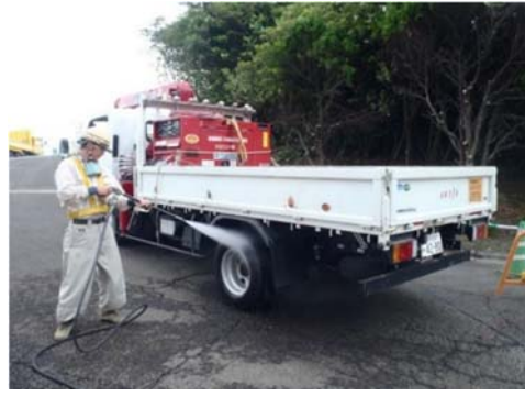
写真 4-1-2-14 資材及び機械の運搬に用いる車両の出入口等の清掃、散水及びタイヤの洗浄
