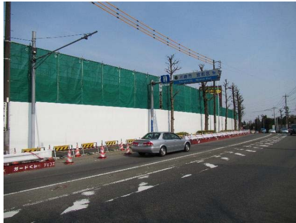
写真 4-1-2-1 仮囲い・防音シート等の設置
