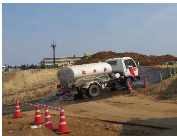
写真 4-1-2-5 工事現場の清掃及び散水
