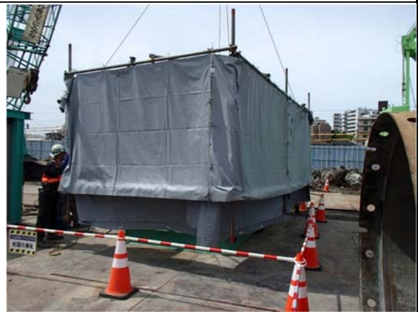
写真 4-1-1-2(2) 低騒音型建設機械の採用 (防音シート設置による音の低減)
