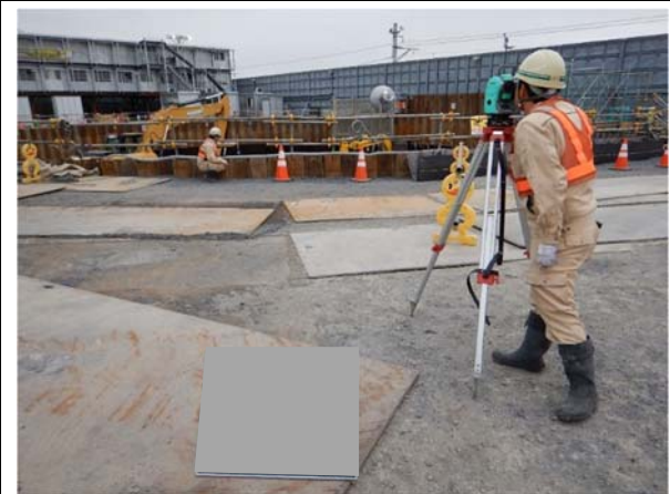
写真 4-1-1-8 山留材及び周辺地盤の計測管理
