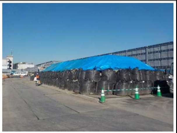
写真 4-1-1-7(2) 土砂ピットにおける発生土の適切な管理 (シート覆いによる飛散防止)
