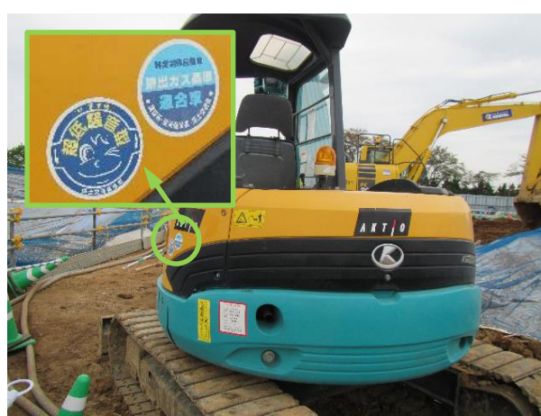
写真 3-1-2-3 低騒音型建設機械の採用
