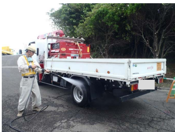
写真 3-1-2-11 資材及び機械の運搬に用いる車両の 出入口等の清掃、散水及びタイヤの洗浄
