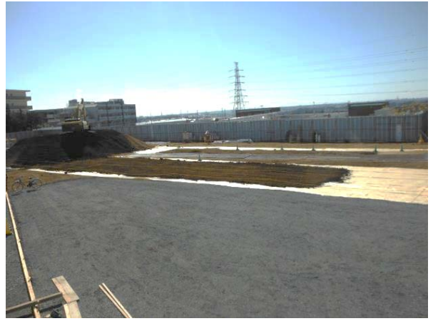
写真 3-1-2-8 土砂ピットにおける発生土の適切な管理
