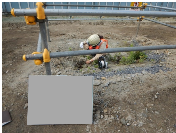
写真 3-1-1-5 地下水の継続的な監視
