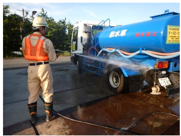
写真 3-1-1-6 資材及び機械の運搬に用いる車両の 出入口等の清掃、散水及びタイヤの洗浄
