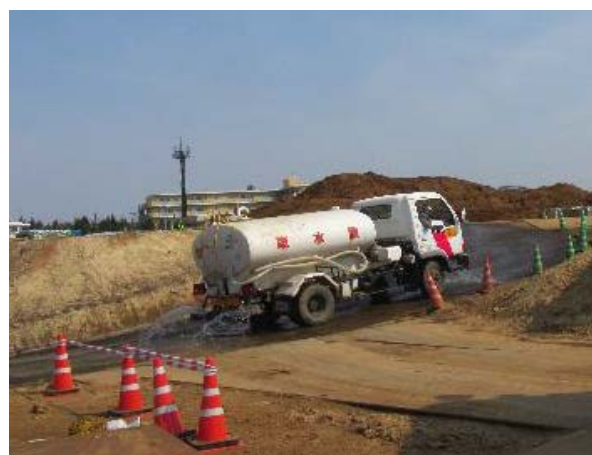
写真 3-1-2-5 工事現場の清掃及び散水
