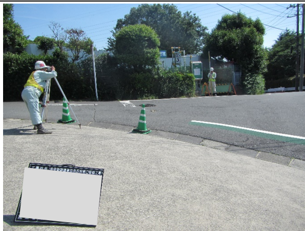
写真 3-1-2-9 山留め材及び周辺地盤の計測管理
