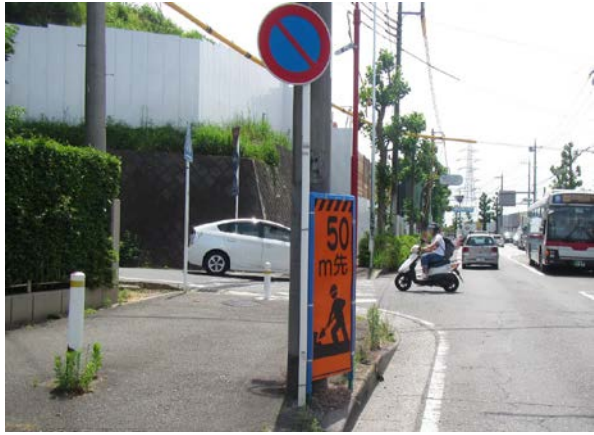
写真 3-1-2-13 資材及び機械の運搬に用いる 車両の運行ルートへの配慮
