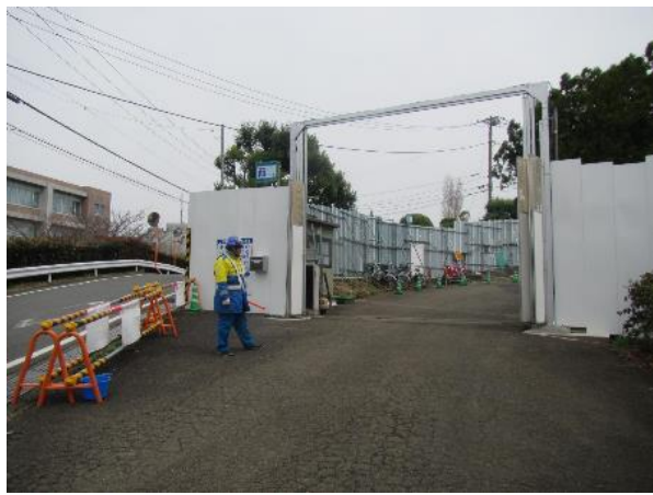
写真 3-1-2-15 交通誘導員による誘導
