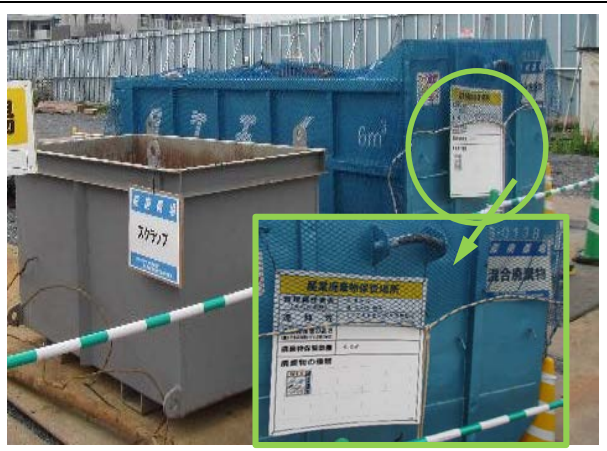
写真 3-1-2-10 副産物の分別・再資源化
