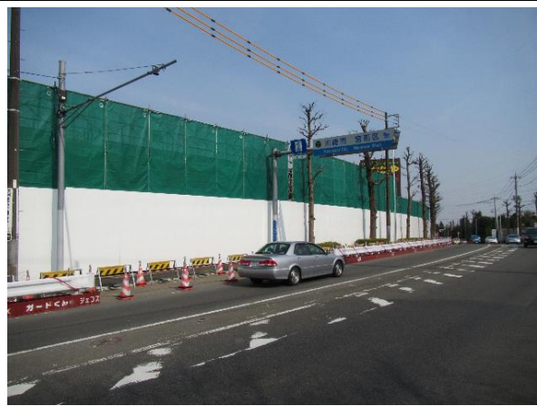
写真 3-1-2-1 仮囲い・防音シート等の設置
