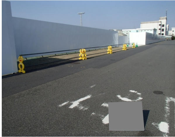
写真 3-1-1-1 仮囲い・防音シート等の設置
