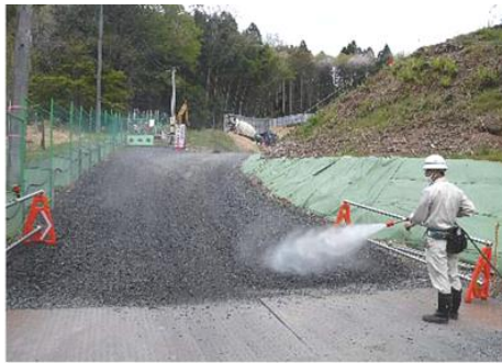
写真① 工事施工ヤード等の清掃、散水
