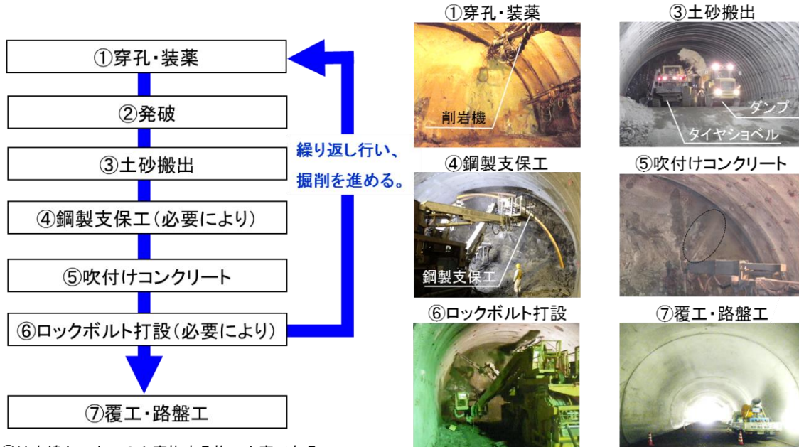
図 2-6 トンネルの施工手順
