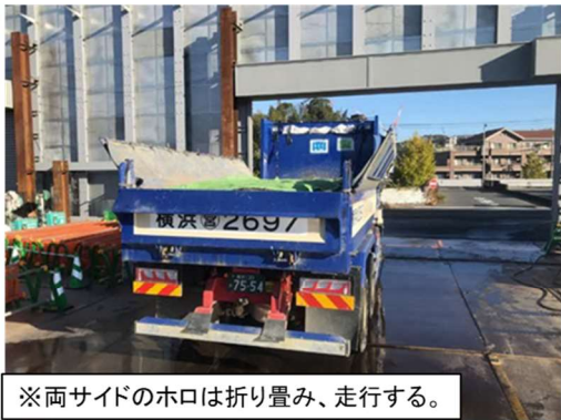
写真⑥ 荷台への防じんシートの設置
