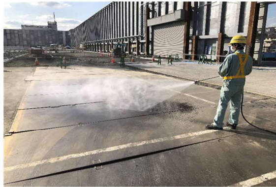
写真⑦ 工事施工ヤード等の清掃散水
