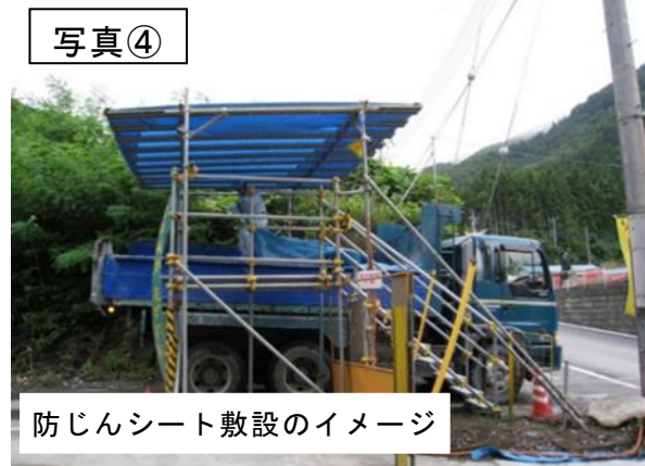
※写真は、他工事での例
