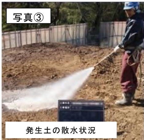
※写真は、山梨リニア実験線工事での例
