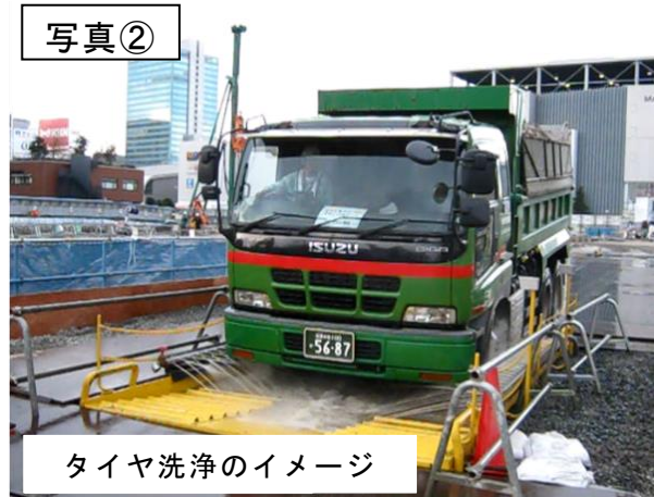
※写真は、他工事での例
