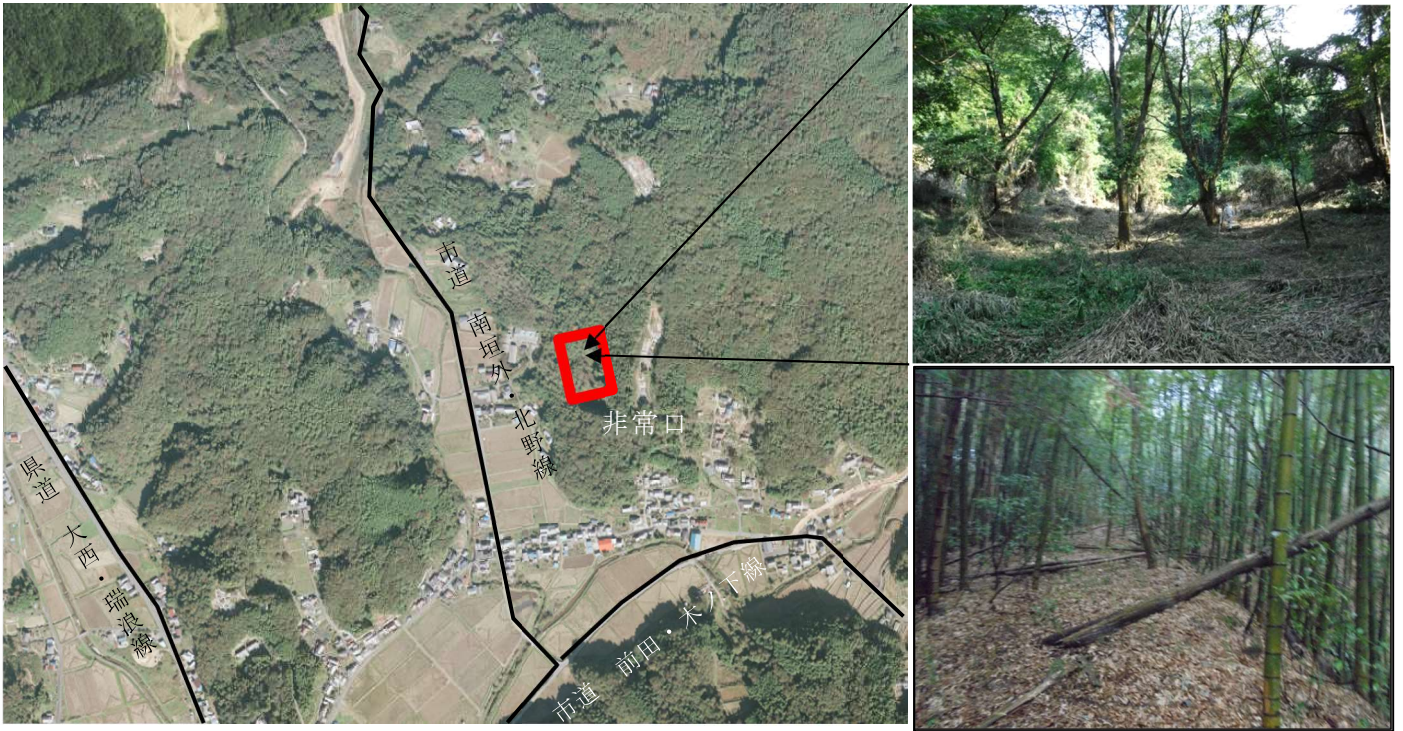
図 2-2-2(1) 南垣外非常口の現況
