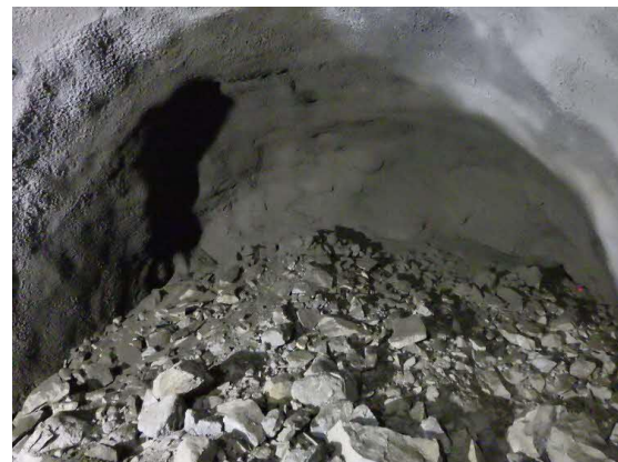
吹付けコンクリート施工完了状況
