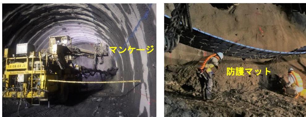
図 6-1 設備的防護対策の例
