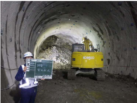
路盤整正状況
