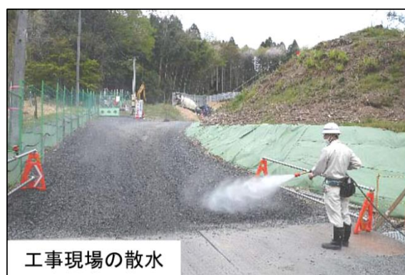
図3-4-1-2 工事用進入路新設における大気環境に関する工事実施時の環境保全措置 (写真は類似工事の例)
