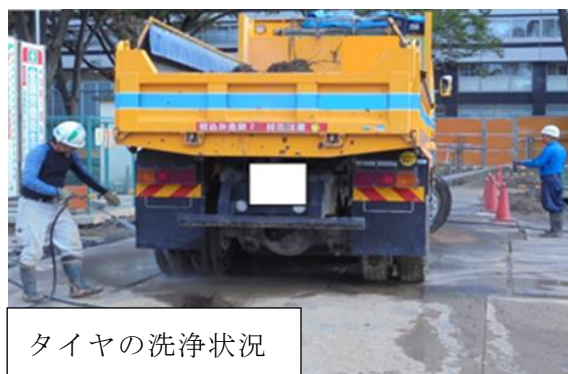
図3-5-1 資材及び機械の運搬に用いる車両の運行による影響を低減させるための環境保全措置 (写真は類似工事の例)
