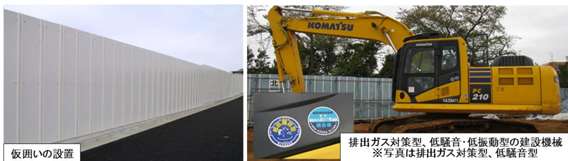
図 3-4-1-1 工事施工ヤード等における大気環境に関する計画の環境保全措置 (写真は類似工事の例)
