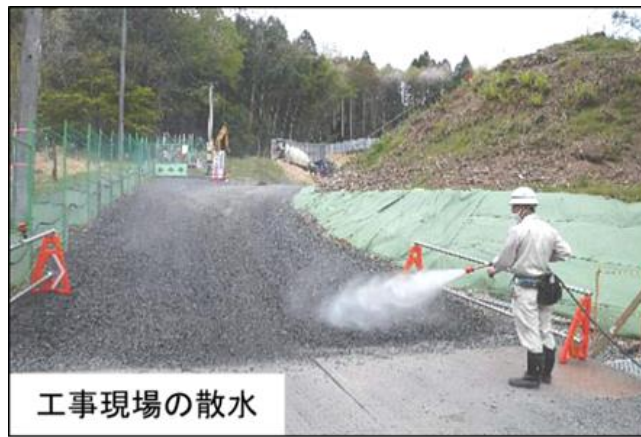
図 3-4-1-2 工事施工ヤード等における大気環境に関する工事实施時の環境保全措置 (写真は類似工事の例)
