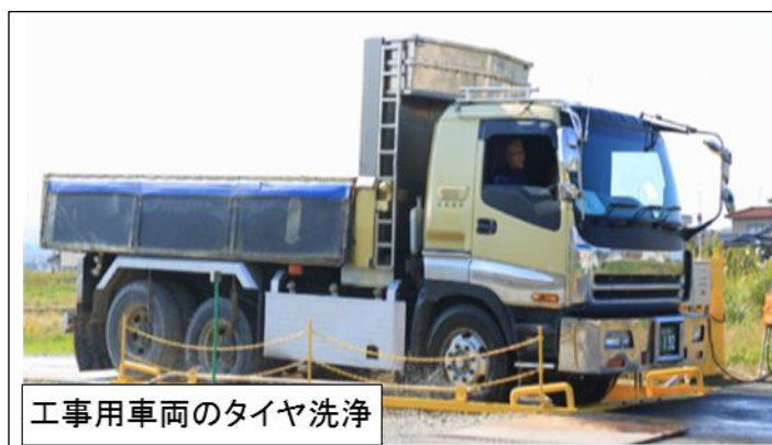
図 3-4-4-1 動物・植物・生態系に係る環境に関する工事实施時の環境保全措置 (写真は類似工事の例)
