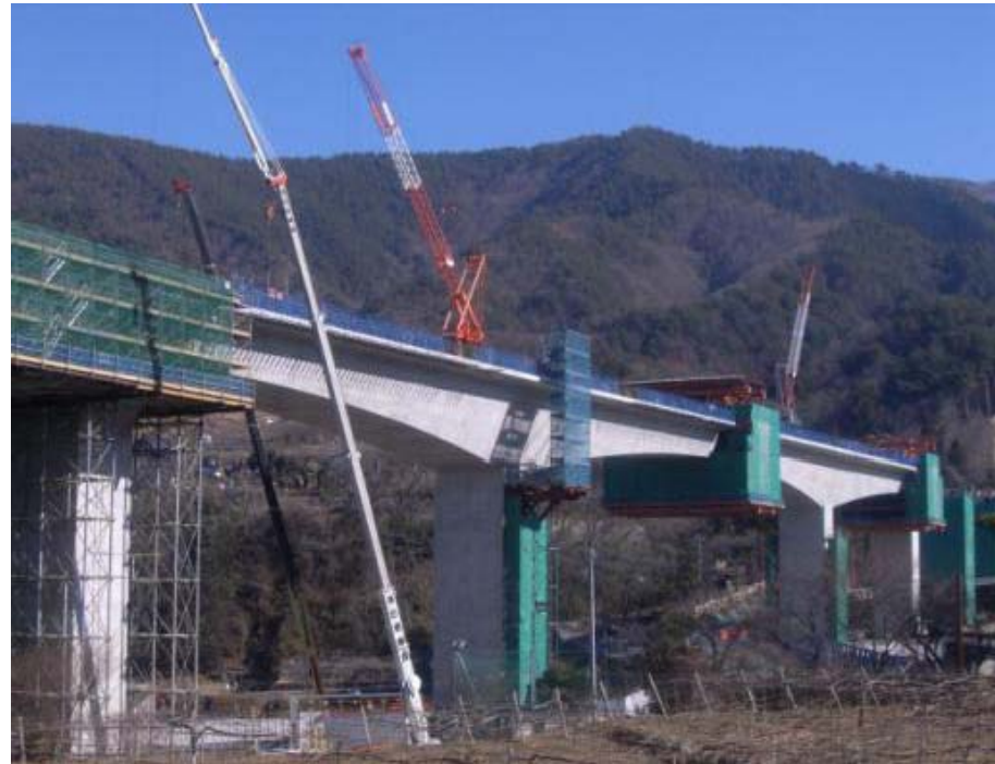
山梨リニア実験線の土木構造物
