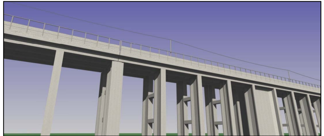
新形式高架橋
