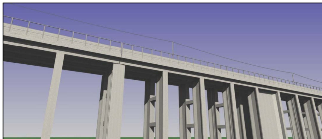
新形式高架橋
