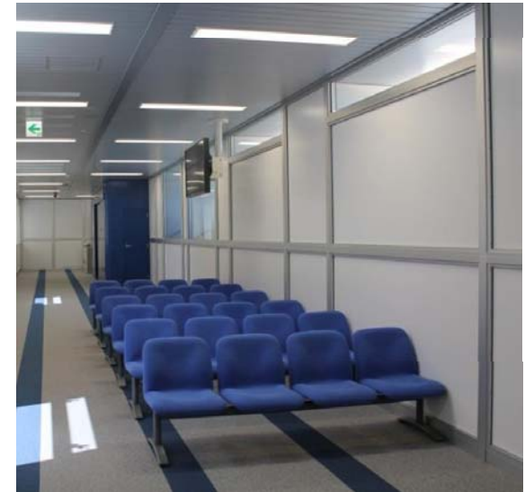
実験線でのホールホーム設置例
