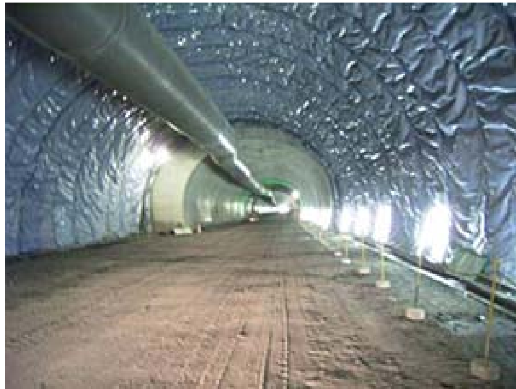
防水シートの施工例(一般国道191号線 萩・三隅道路)
