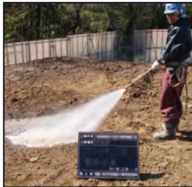
・工事現場の清掃及び散水
