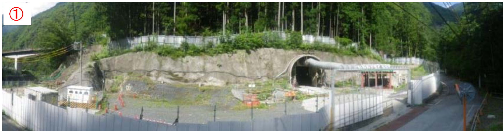
早川非常口の全景
