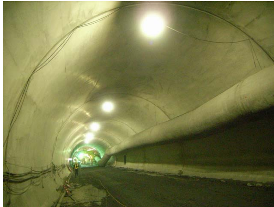
覆エコンクリートの施工例 (一般県道 常神三方線 神子トンネル)
