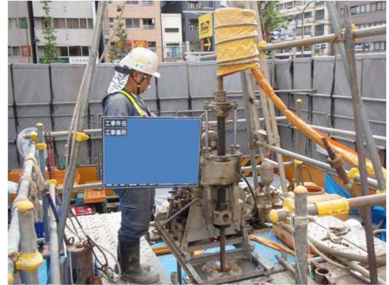
ボーリング調査の様子
