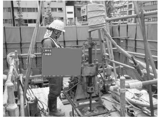
ボーリング調査の様子
