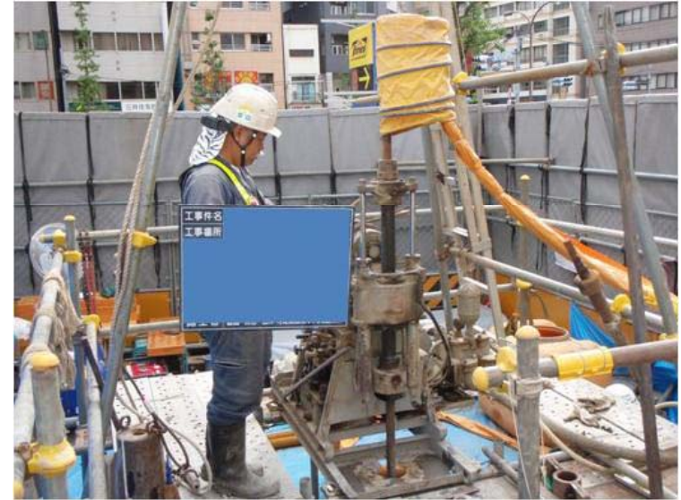
ボーリング調査の様子
