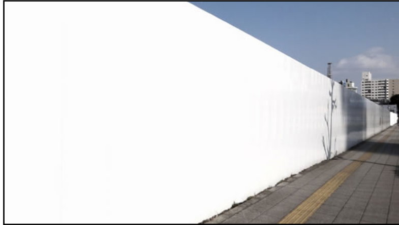
・工事用仮囲い
