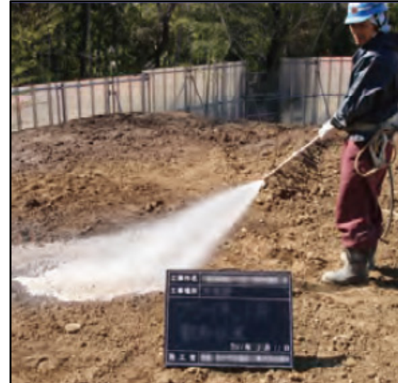
・工事現場の散水
