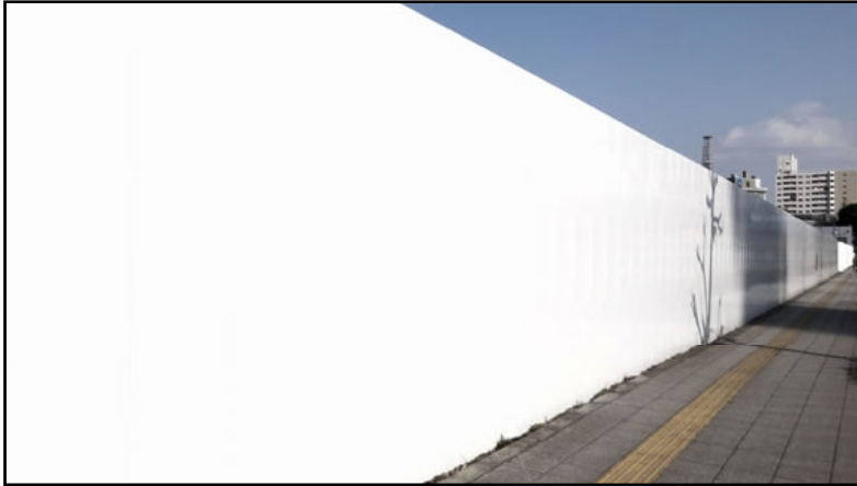
・工事用仮囲い
