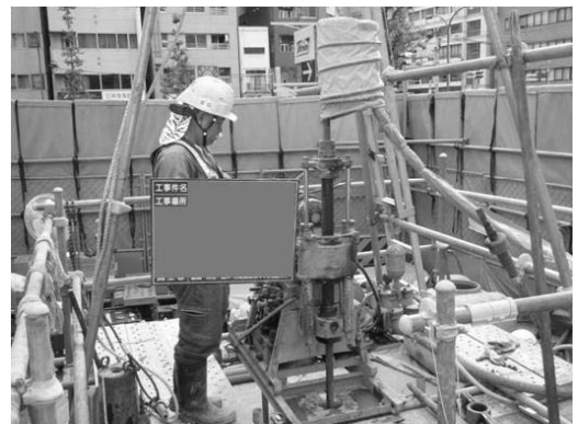
ボーリング調査の様子
