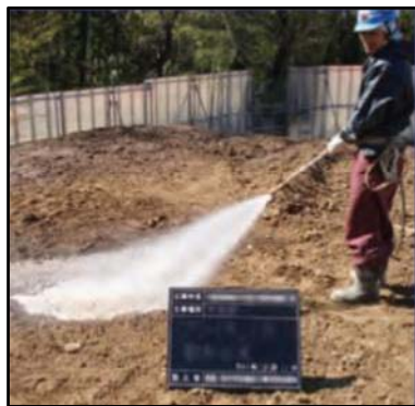
・工事現場の清掃及び散水
