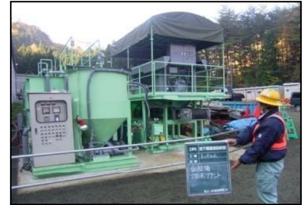
・工事排水の適切な処理 ・工事排水の監視 ・放流時の放流箇所及び水温の調整
