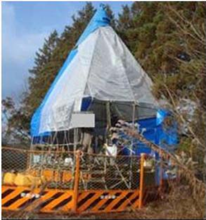
ボーリング調査
