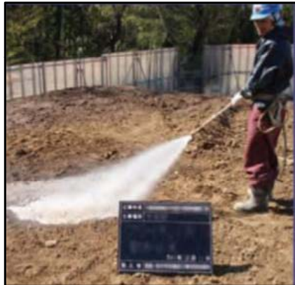
・工事現場の清掃及び散水
