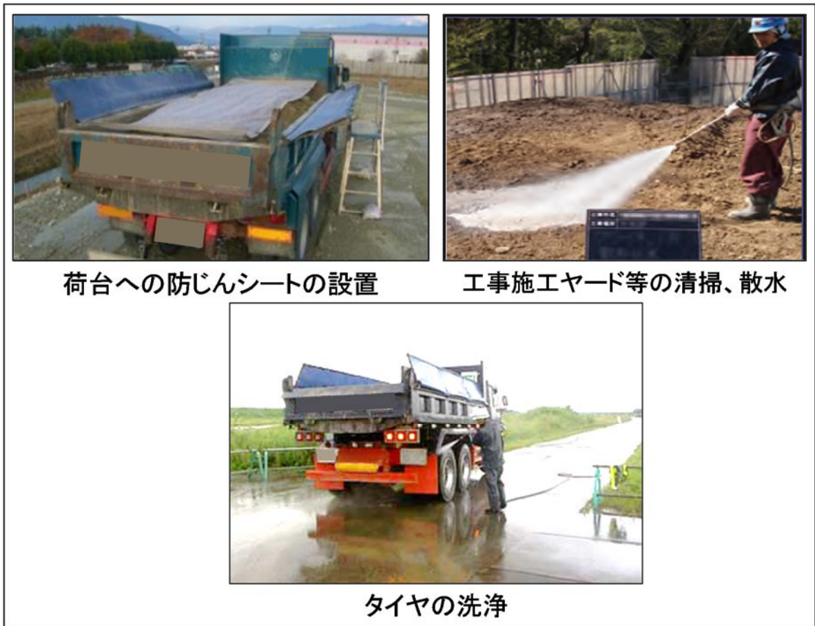
図 3-4 資材及び機械の運搬に用いる車両の運行による影響を低減するための環境保全措置 (写真は類似工事の例)
