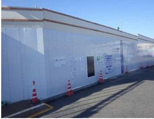
写真 4-1-4-1 仮囲い・防音シート等の設置状況
