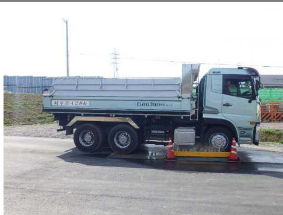
写真 4-1-1-5 資材及び機械の運搬に用いる車両 の出入口、周辺道路の清掃及び 散水、タイヤの洗浄
