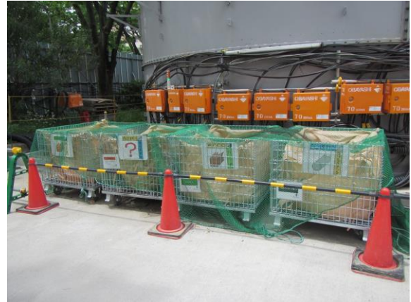
写真 4-1-6-10 副産物の分別、再資源化
