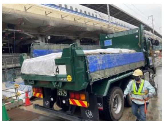
写真 4-1-8-6 荷台への防じんシート敷設及び散水
