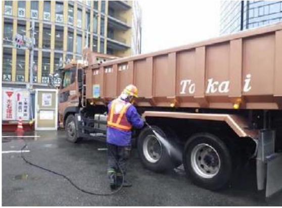
写真 4-1-8-7 資材及び機械の運搬に用いる車両の出入口、周辺道路の清掃及び散水、タイヤの洗浄
