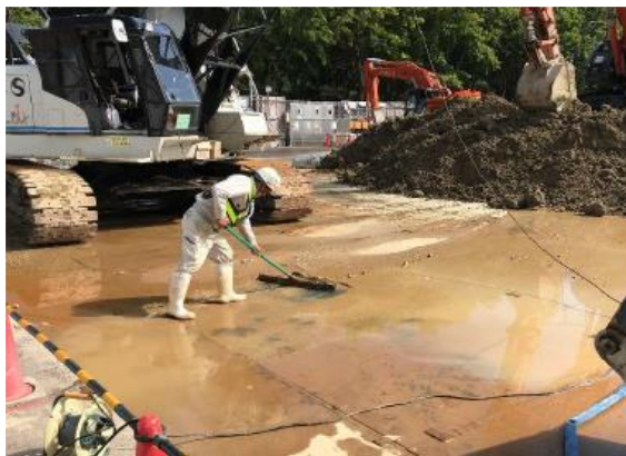
写真 4-1-7-5 工事現場の清掃及び散水
