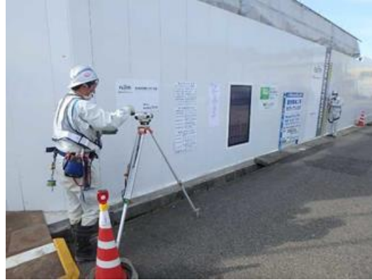
写真 4-1-4-8 周辺地盤の計測管理
