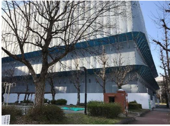
写真 4-1-7-1 仮囲い等の設置状況
