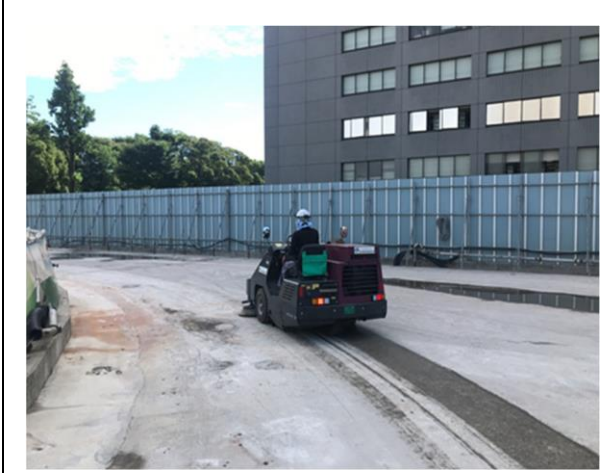
写真 4-1-6-5 工事現場の清掃及び散水
