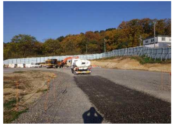
写真 4-1-1-4 工事現場の清掃及び散水
