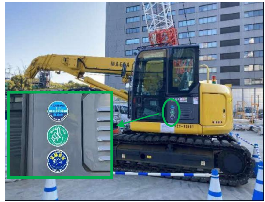
写真 4-1-5-2 排出ガス対策型建設機械の採用 低騒音型建設機械の採用
