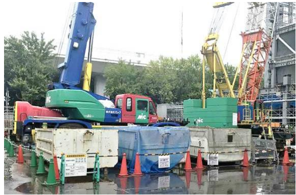
写真 4-1-7-10 副産物の分別、再資源化
