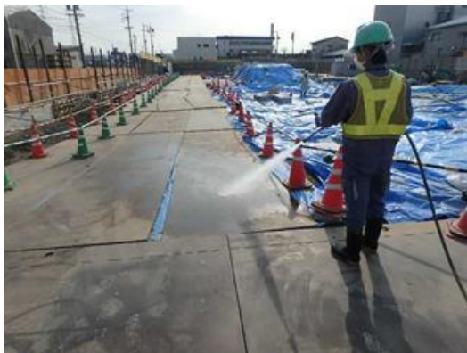
写真 4-1-4-5 工事現場の清掃及び散水
