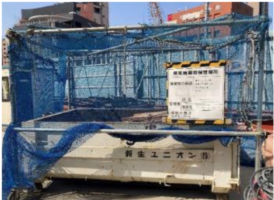
写真 4-1-8-11 副産物の分別、再資源化
