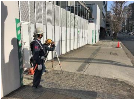
写真 4-1-7-9 周辺地盤の計測管理
