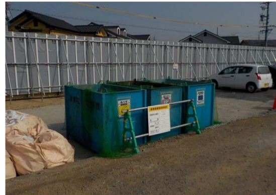
写真 4-1-3-12 副産物の分別、再資源化
