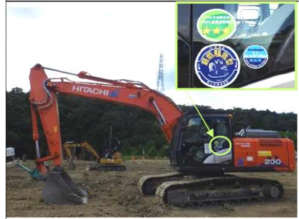
写真 4-1-1-2 排出ガス対策型建設機械の採用 低騒音型建設機械の採用
