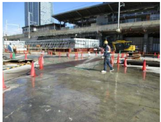
写真 4-1-8-5 工事現場の清掃及び散水
