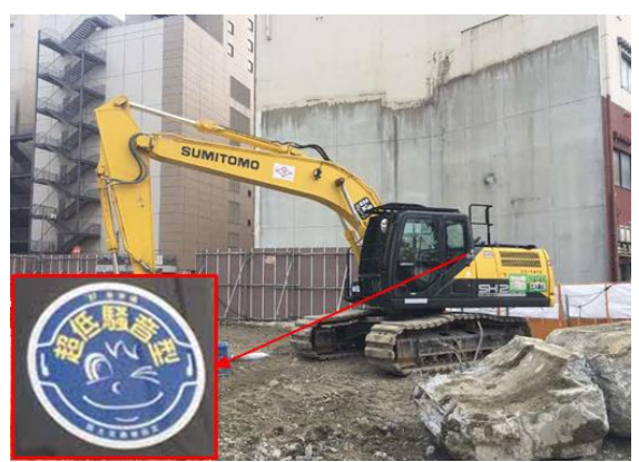
写真 4-1-8-4 低騒音型建設機械の採用
