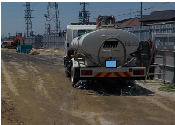
写真 4-1-3-5 工事現場の清掃及び散水
