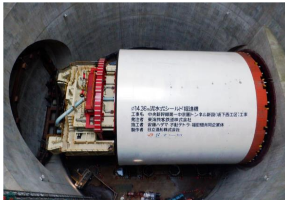
写真 4-1-2-8 適切な構造及び工法の採用 (密閉性の高いシールド工法の採用)
