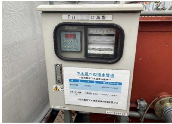
写真 4-1-8-8 工事排水の適切な処理
