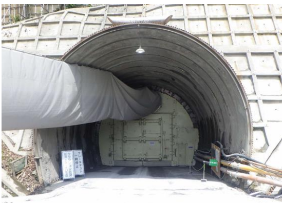
写真 4-1-1-11 トンネル坑口への防音扉の 設置状況
