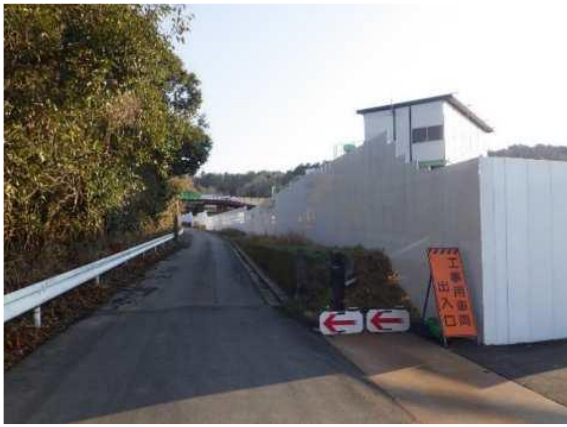
写真 4-1-1-1 仮囲い等の設置状況
