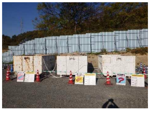
写真 4-1-1-10 副産物の分別、再資源化
