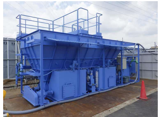
写真 4-1-3-8 工事排水の適切な処理
