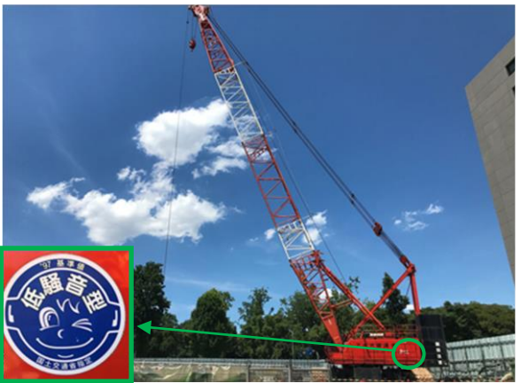
写真 4-1-6-4 低騒音型建設機械の採用
