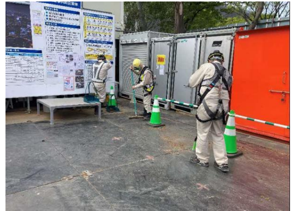
写真 4-1-5-4 工事現場の清掃及び散水
