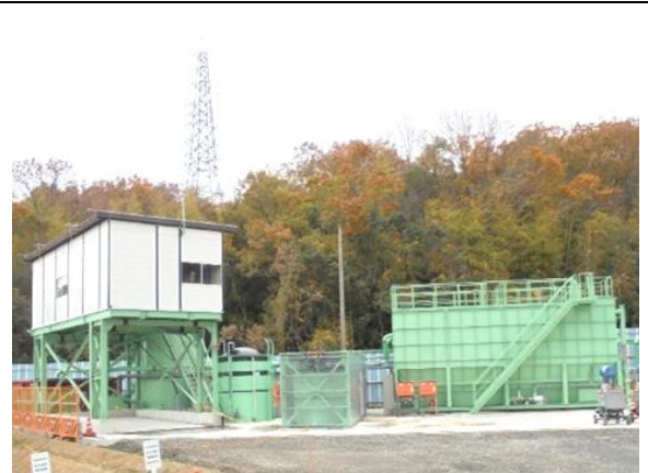
写真 4-1-1-6 工事排水の適切な処理
