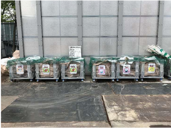
写真 4-1-5-7 副産物の分別、再資源化
