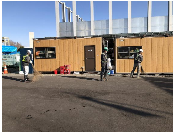
写真 4-1-2-5 工事現場の清掃及び散水
