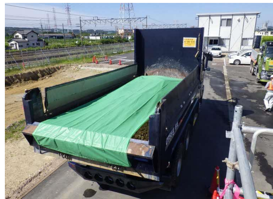
写真 4-1-3-6 荷台への防じんシート敷設及び 散水
