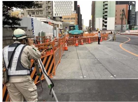
写真 4-1-8-10 周辺地盤の計測管理
