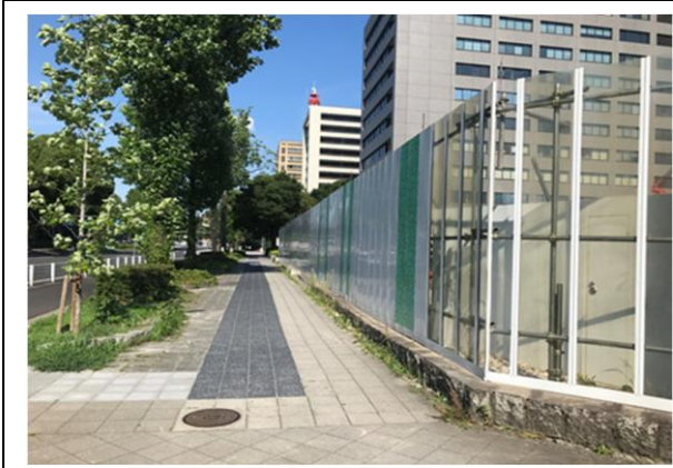
写真 4-1-6-1 仮囲い等の設置状況
