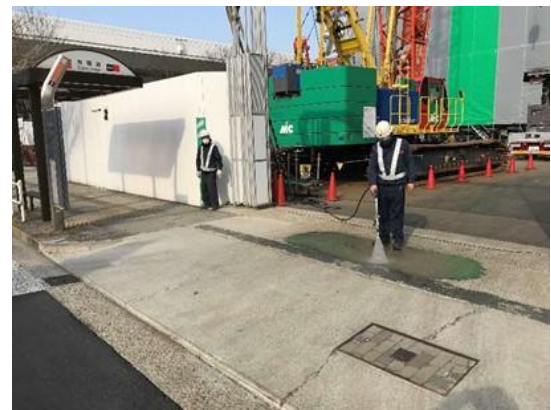
写真 4-1-7-6 資材及び機械の運搬に用いる車両 の出入口、周辺道路の清掃及び 散水、タイヤの洗浄
