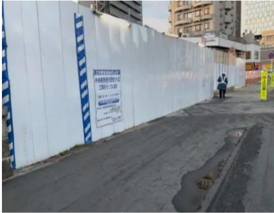
写真 4-1-8-1 仮囲い等の設置状況
