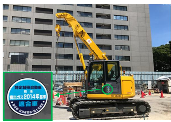
写真 4-1-6-2 排出ガス対策型建設機械の採用
