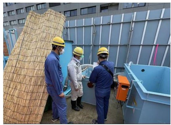
写真 4-1-5-6 工事排水の適切な処理
