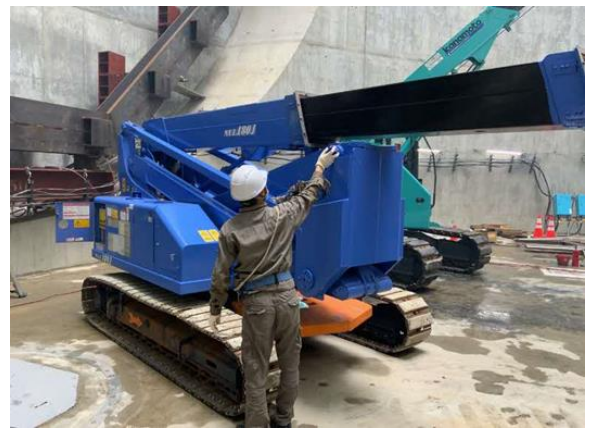
写真 4-1-2-4 建設機械の点検及び整備による 性能維持
