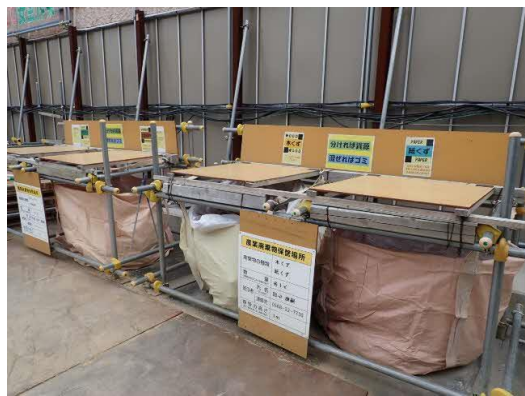
写真 4-1-4-9 副産物の分別、再資源化
