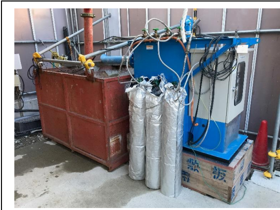
写真 4-1-7-7 工事排水の適切な処理
