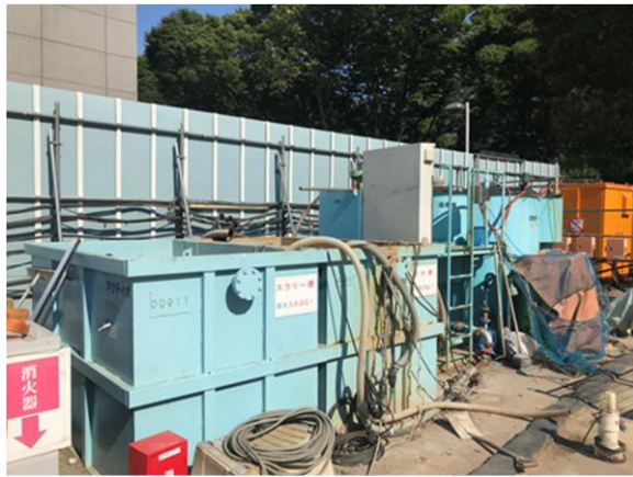
写真 4-1-6-7 工事排水の適切な処理
