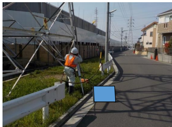
写真 4-1-3-10 周辺地盤の計測管理
