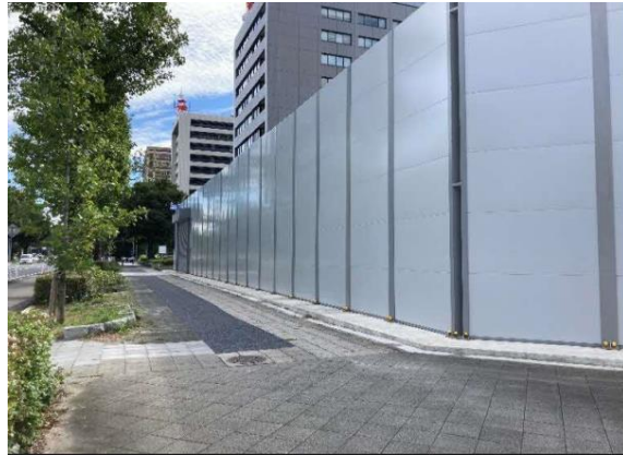
写真 4-1-5-1 仮囲い等の設置状況
