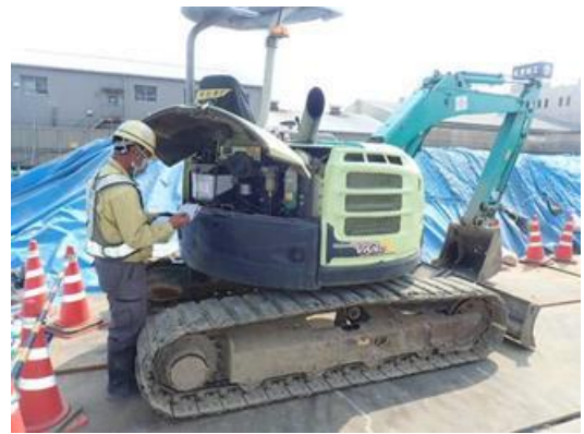
写真 4-1-4-4 建設機械の点検及び整備による 性能維持
