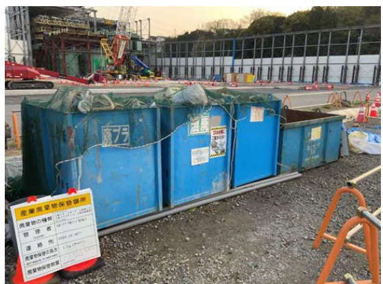
写真 4-1-2-9 副産物の分別、再資源化
