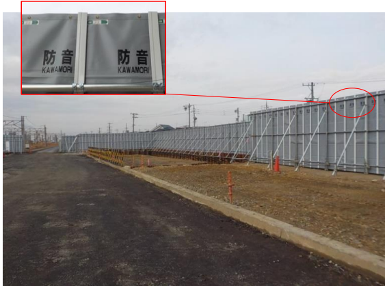
写真 4-1-3-1 仮囲い・防音シート等の設置状況
