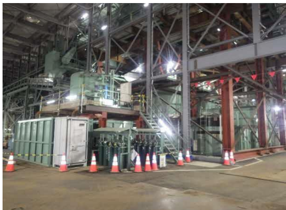
写真 4-1-2-7 工事排水の適切な処理
