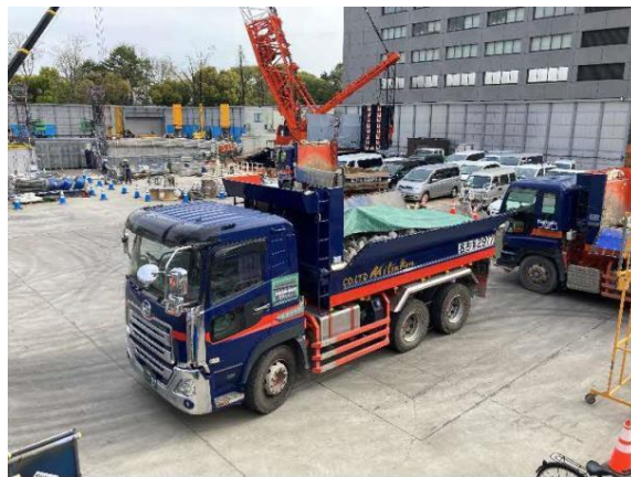
写真 4-1-5-5 荷台への防じんシート敷設及び 散水
