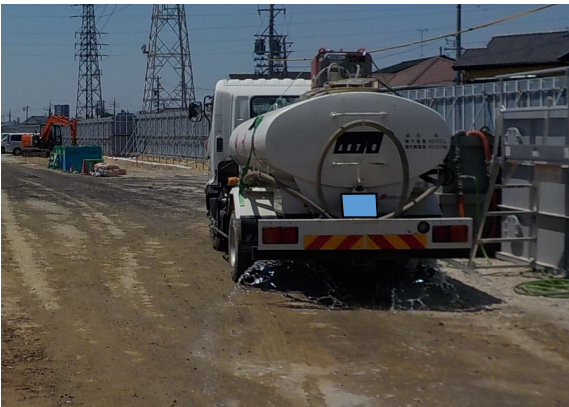
写真4-1-3-5 工事現場の清掃及び散水
