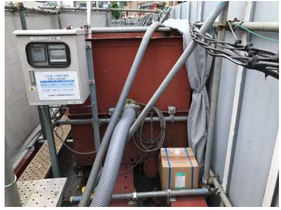
写真4-1-7-8 工事排水の適切な処理
