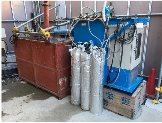
写真4-1-6-7 工事排水の適切な処理
