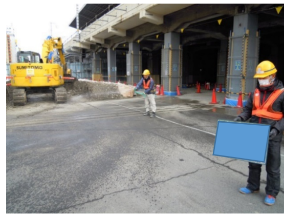
写真 4-1-7-5 工事現場の清掃及び散水
