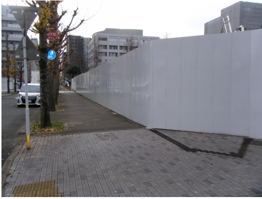
写真4-1-6-1 仮囲い等の設置状況
