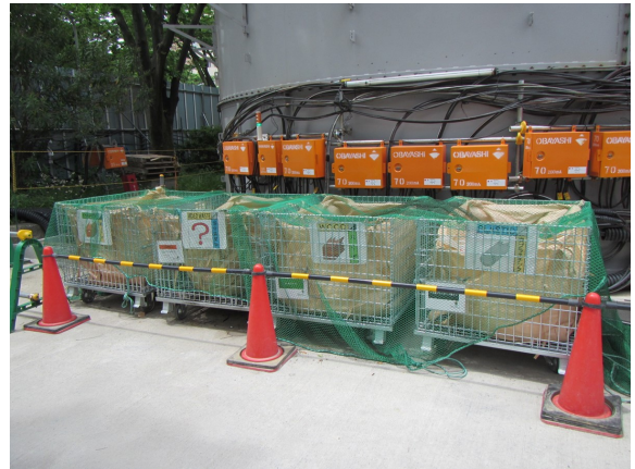
写真4-1-5-10 副産物の分別、再資源化
