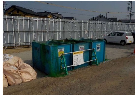
写真4-1-3-12 副産物の分別、再資源化
