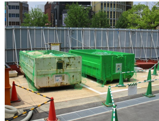
写真4-1-7-11 副産物の分別、再資源化
