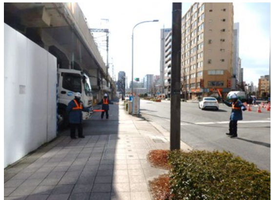
写真4-1-7-12 交通誘導員による誘導
