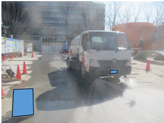
写真4-1-5-5 工事現場の清掃及び散水
