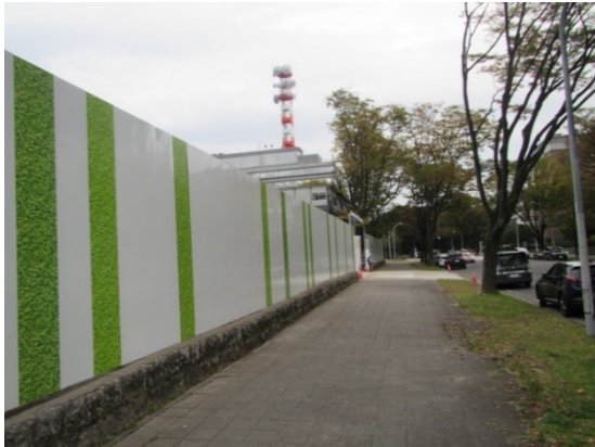
写真4-1-5-1 仮囲い等の設置状況
