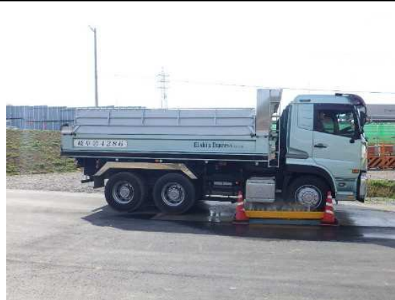
写真4-1-1-5 資材及び機械の運搬に用いる車両 の出入口、周辺道路の清掃及び散水、 タイヤの洗浄
