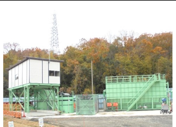
写真4-1-1-6 工事排水の適切な処理
