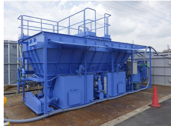
写真4-1-3-8 工事排水の適切な処理
