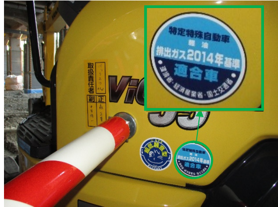
写真4-1-7-2 排出ガス対策型建設機械の採用
