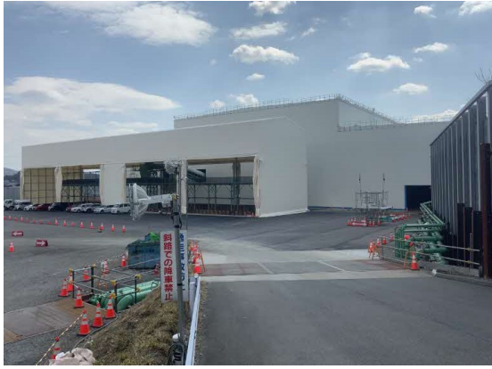
写真4-1-2-1 仮囲い・防音シート等の設置状況 (防音ハウスの設置状況)
