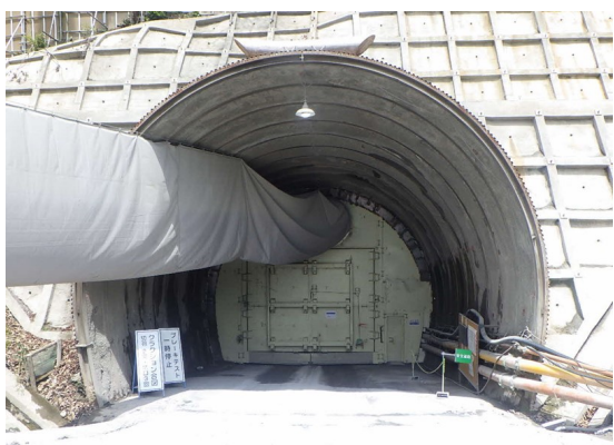
写真4-1-1-11 トンネル坑口への防音扉の設置状 況
