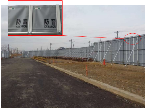
写真4-1-3-1 仮囲い・防音シート等の設置状況
