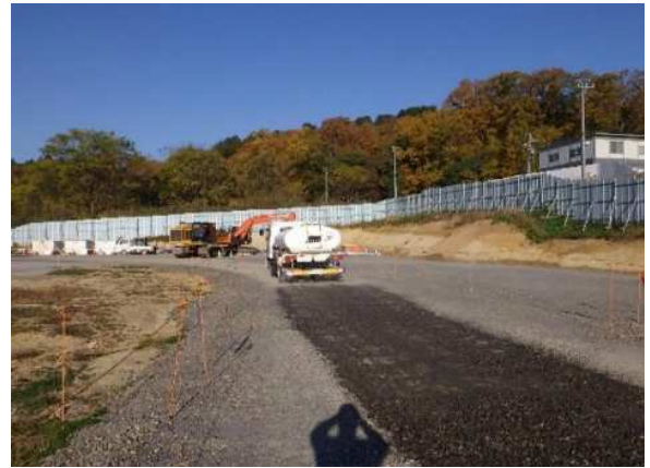
写真4-1-1-4 工事現場の清掃及び散水
