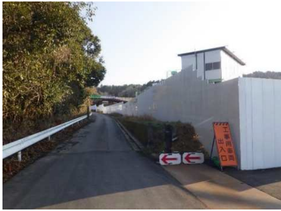
写真4-1-1-1 仮囲い等の設置状況
