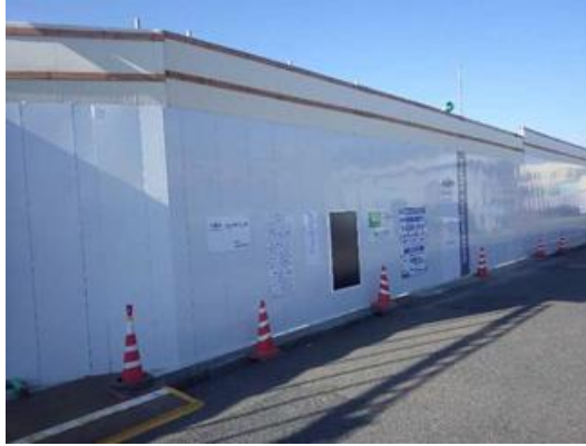
写真4-1-4-1 仮囲い・防音シート等の設置状況
