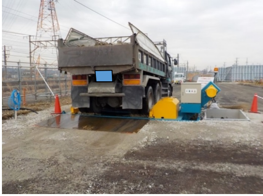
写真4-1-3-7 資材及び機械の運搬に用いる車両の出入口の清掃及び散水、タイヤの洗浄
