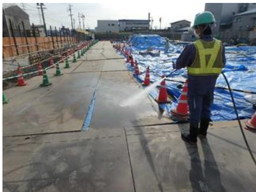
写真4-1-4-5 工事現場の清掃及び散水
