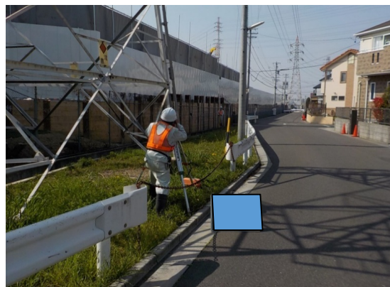
写真4-1-3-10 周辺地盤の計測管理
