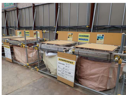
写真4-1-4-9 副産物の分別、再資源化
