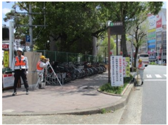
写真4-1-7-10 山留め材及び周辺地盤の計測管理
