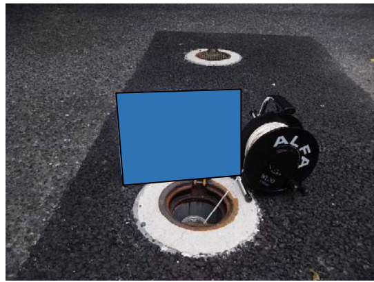
写真4-1-7-9 地下水の継続的な監視
