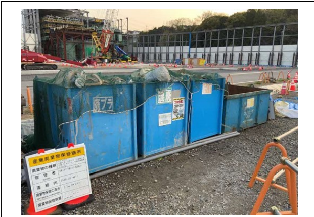
写真4-1-2-7 副産物の分別、再資源化
