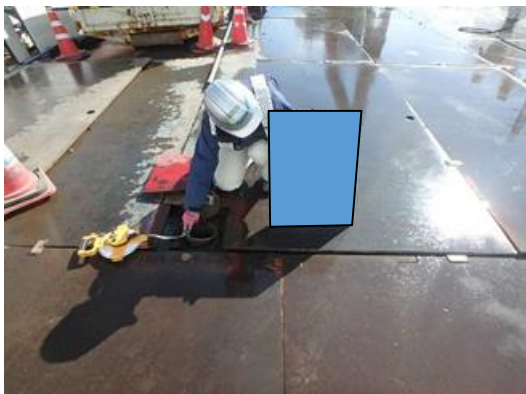
写真4-1-4-7 地下水の継続的な監視
