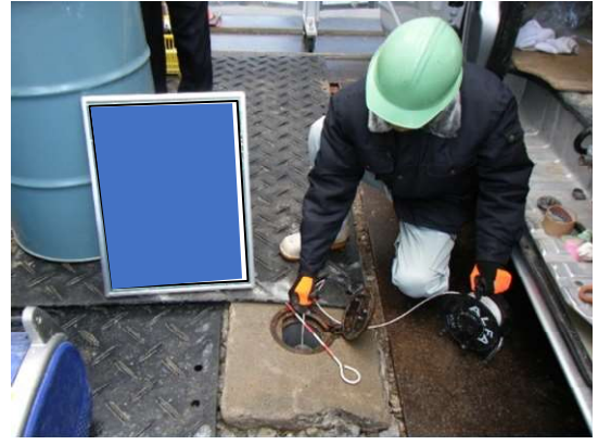
写真4-1-6-8 地下水の継続的な監視
