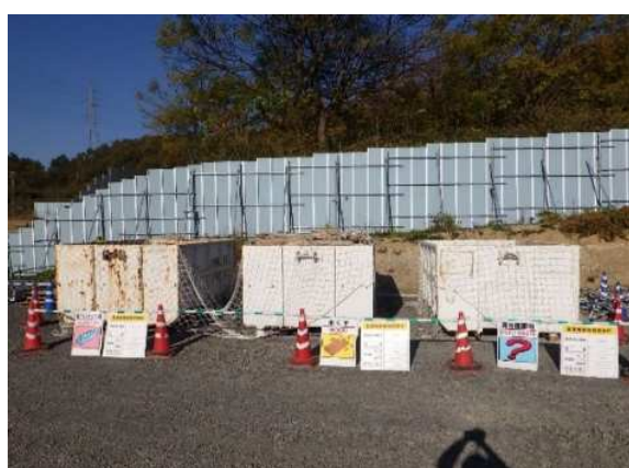
写真4-1-1-10 副産物の分別、再資源化
