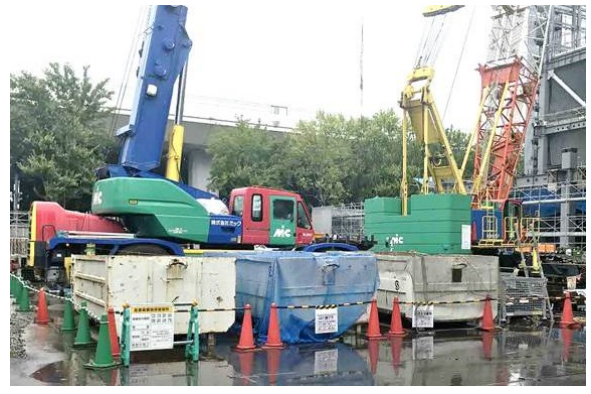
写真4-1-6-10 副産物の分別、再資源化
