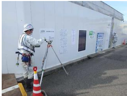
写真4-1-4-8 周辺地盤の計測管理
