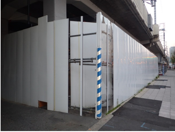
写真4-1-7-1 仮囲い等の設置状況
