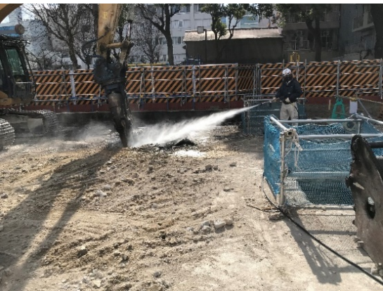
写真4-1-6-5 工事現場の清掃及び散水
