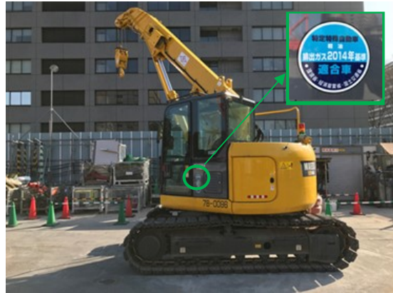
写真4-1-5-2 排出ガス対策型建設機械の採用
