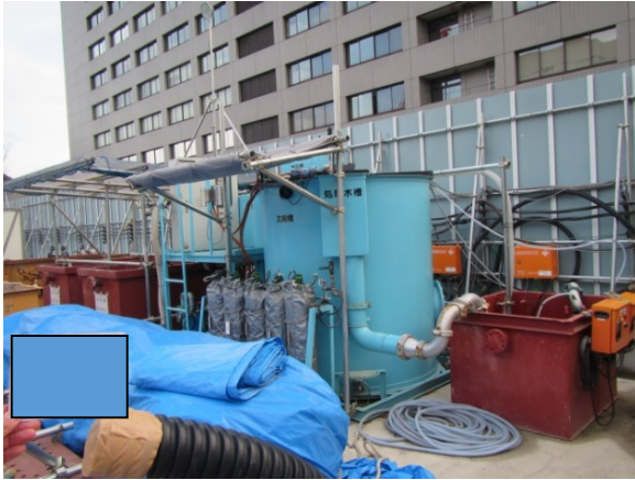
写真4-1-5-7 工事排水の適切な処理
