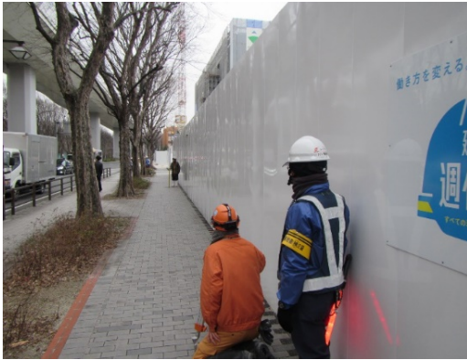
写真4-1-6-9 山留め材及び周辺地盤の計測管理
