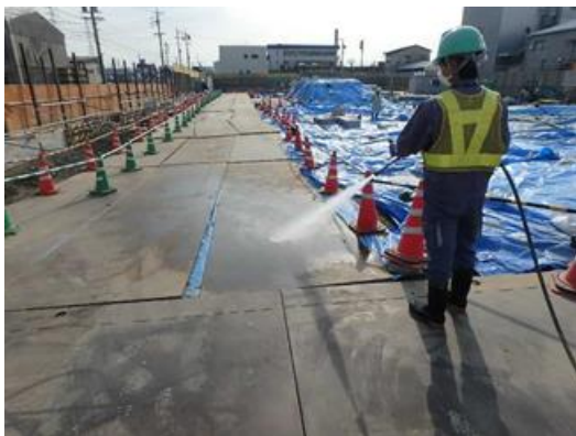
写真4-1-5-5 工事現場の清掃及び散水
