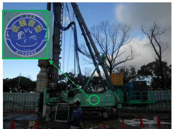
写真4-1-6-4 低騒音型建設機械の採用
