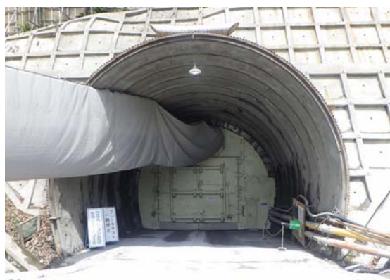
写真4-1-1-11 トンネル坑口への防音扉の設置
