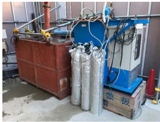
写真4-1-7-10 工事排水の適切な処理
