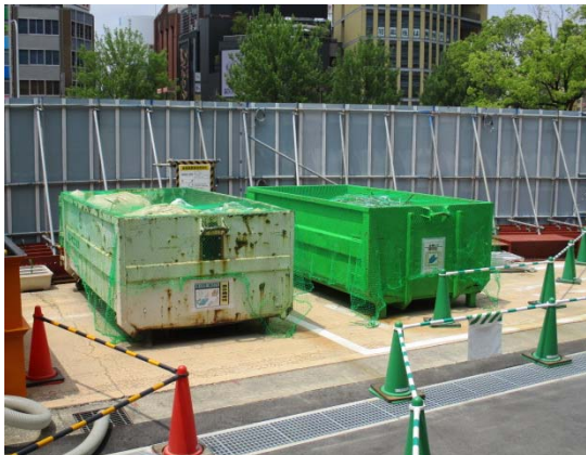
写真4-1-8-11 副産物の分別、再資源化
