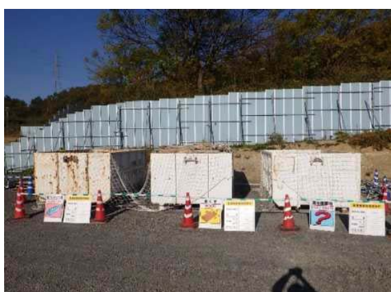
写真4-1-1-10 副産物の分別、再資源化
