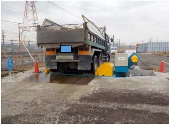
写真4-1-4-7 資材及び機械の運搬に用いる車両の出入口の清掃及び散水、タイヤの洗浄
