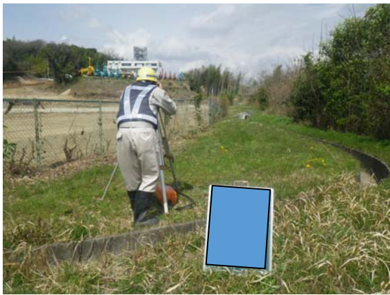
写真4-1-3-9 山留め材及び周辺地盤の計測管理
