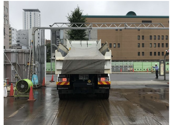
写真4-1-7-6 荷台への防じんシート敷設及び散水
