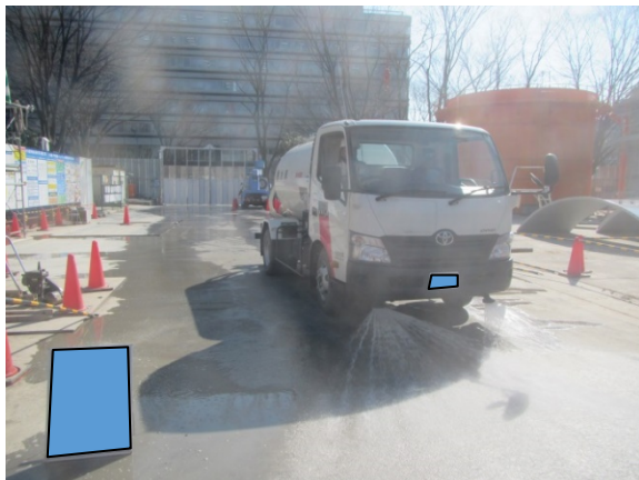
写真4-1-6-5 工事現場の清掃及び散水
