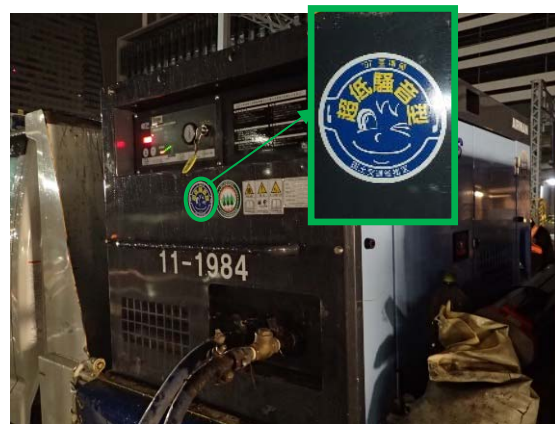
写真4-1-8-4 低騒音型建設機械の採用
