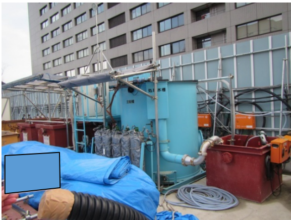
写真4-1-6-9 工事排水の適切な処理
