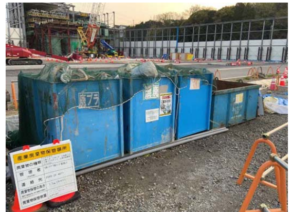
写真4-1-2-6 副産物の分別、再資源化
