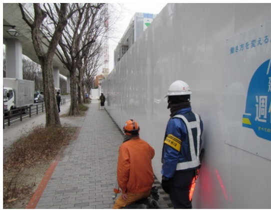
写真4-1-7-9 山留め材及び周辺地盤の計測管理
