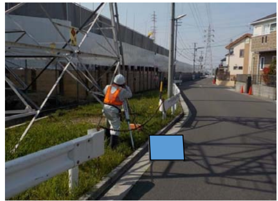
写真4-1-4-10 山留め材及び周辺地盤の計測管理
