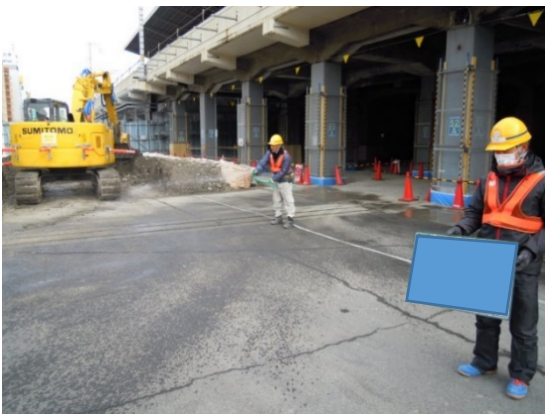
写真 4-1-8-5 工事現場の清掃及び散水
