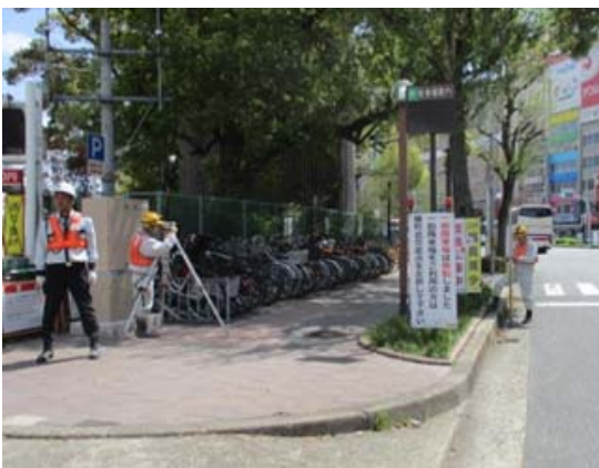
写真4-1-8-9 山留め材及び周辺地盤の計測管理
