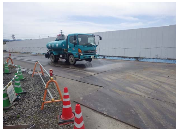
写真4-1-3-4 工事現場の清掃及び散水
