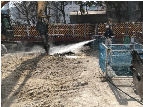
写真4-1-7-5 工事現場の清掃及び散水
