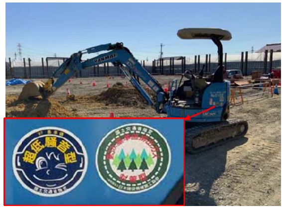
写真4-1-2-2 排出ガス対策型建設機械の採用 低騒音型建設機械の採用
