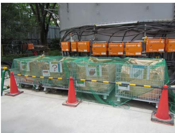
写真4-1-6-11 副産物の分別、再資源化
