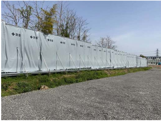
写真4-1-2-1 仮囲い・防音シート等の設置
