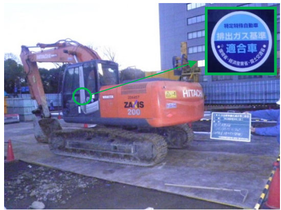
写真4-1-6-2 排出ガス対策型建設機械の採用
