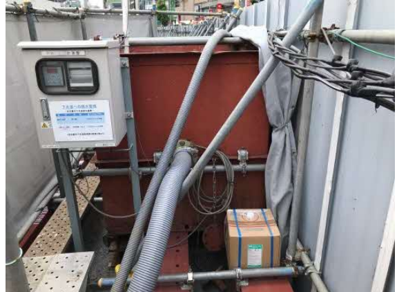
写真4-1-8-10 工事排水の適切な処理
