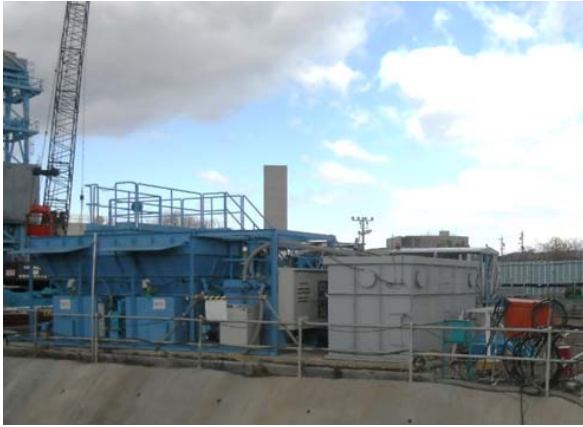
写真4-1-3-7 工事排水の適切な処理
