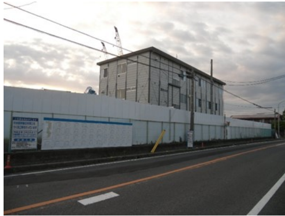
写真4-1-3-1 仮囲い等の設置
