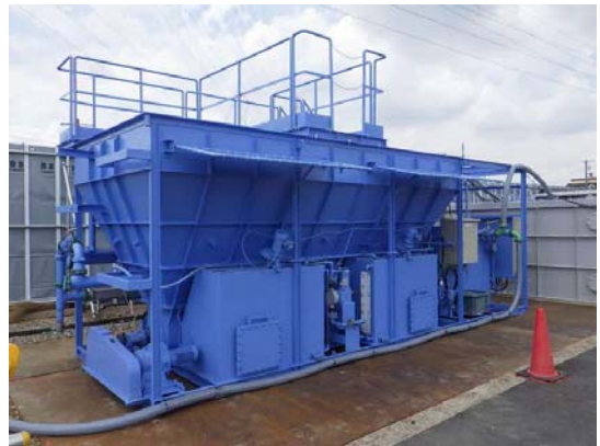
写真4-1-4-8 工事排水の適切な処理
