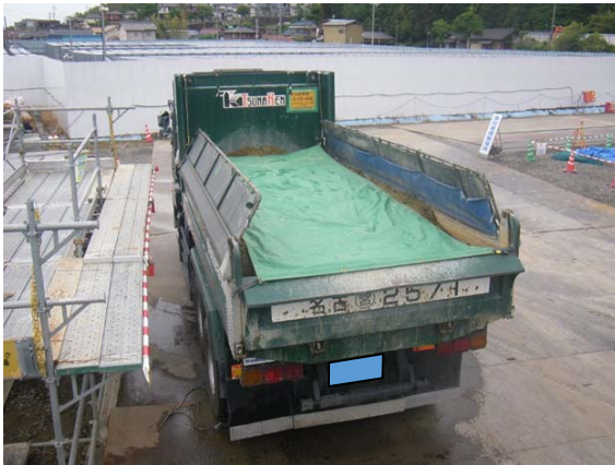
写真4-1-3-5 荷台への防じんシート敷設及び散水
