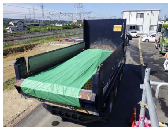
写真4-1-4-6 荷台への防じんシート敷設及び 散水
