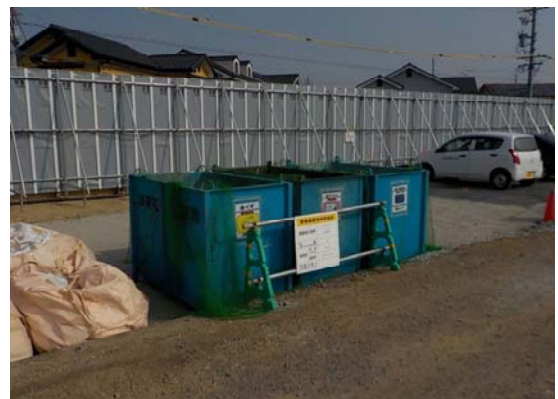
写真4-1-4-12 副産物の分別、再資源化
