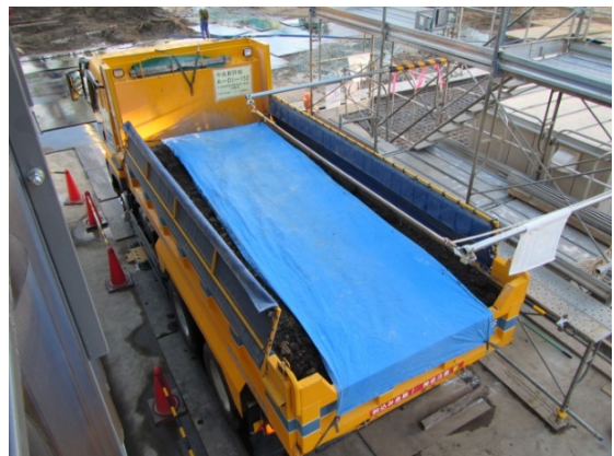
写真4-1-6-6 荷台への防じんシート敷設及び散水
