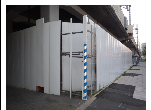
写真4-1-8-1 仮囲い等の設置
