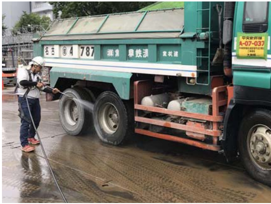
写真4-1-7-7 資材及び機械の運搬に用いる車両の出入口、周辺道路の清掃及び散水、タイヤの洗浄
