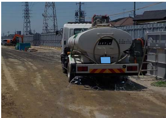
写真4-1-4-5 工事現場の清掃及び散水
