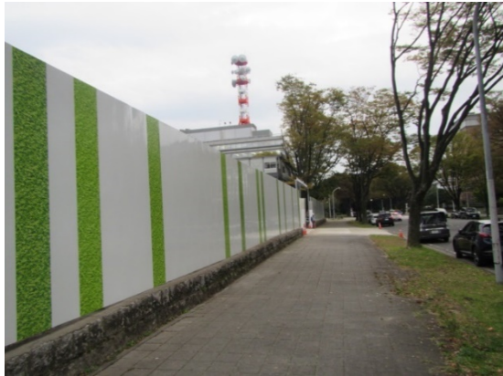
写真4-1-6-1 仮囲い等の設置
