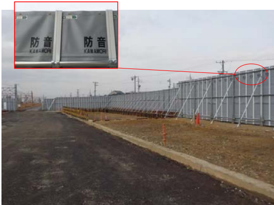
写真4-1-4-1 仮囲い・防音シート等の設置
