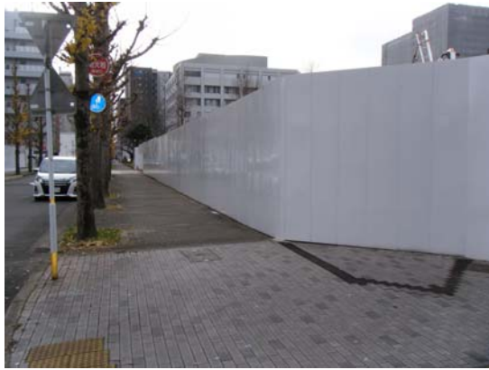
写真4-1-7-1 仮囲い等の設置
