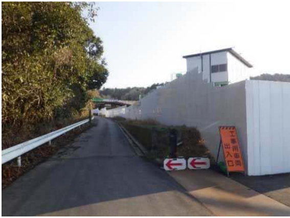
写真4-1-1-1 仮囲い等の設置
