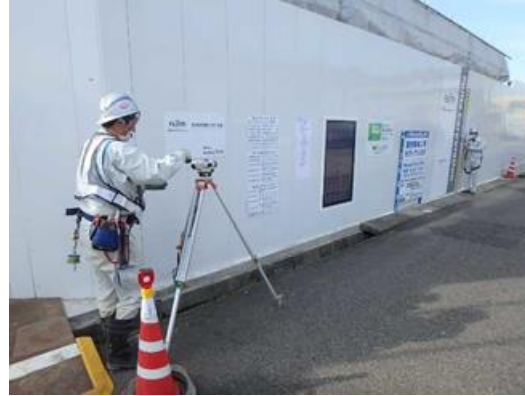
写真4-1-5-8 周辺地盤の計測管理
