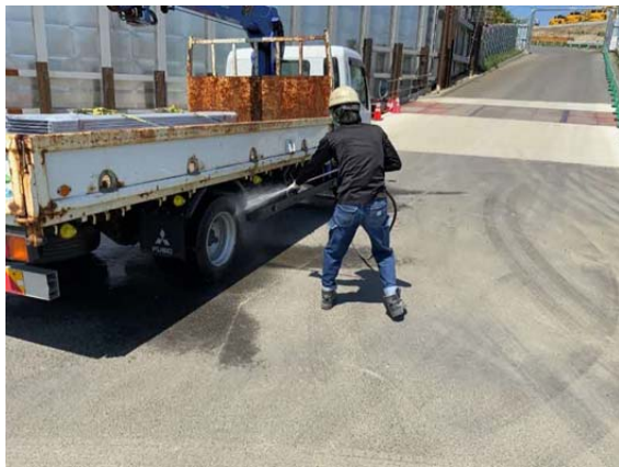
写真4-1-2-5 資材及び機械の運搬に用いる車両の出入口、周辺道路の清掃及び散水、タイヤの洗浄
