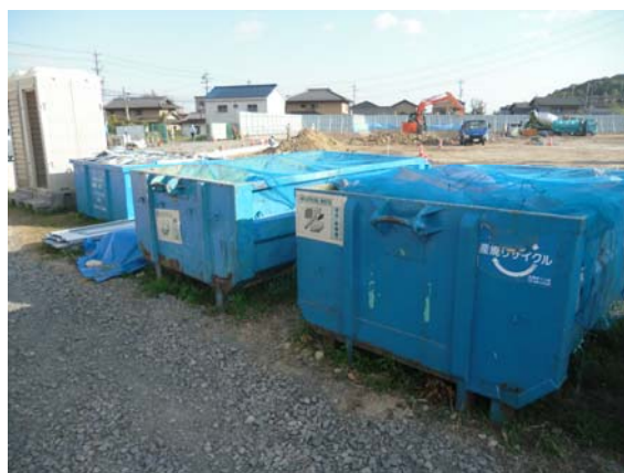
写真4-1-3-11 副産物の分別、再資源化
