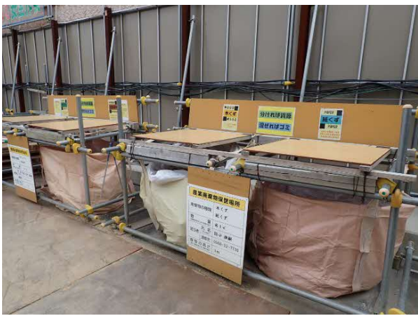
写真4-1-5-9 副産物の分別、再資源化
