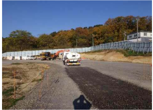
写真4-1-1-4 工事現場の清掃及び散水
