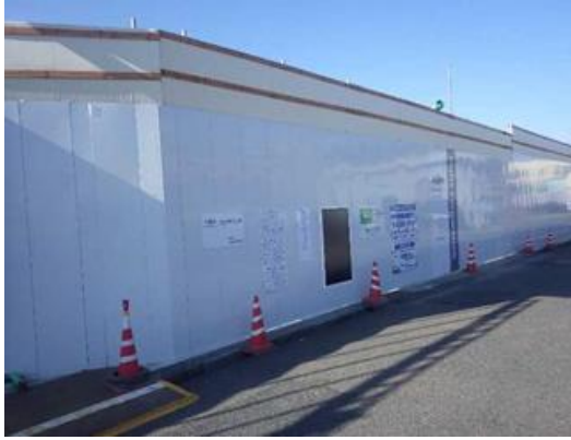
写真4-1-5-1 仮囲い・防音シート等の設置
