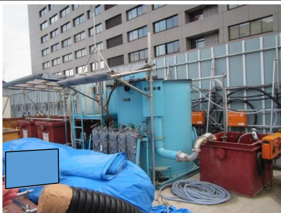
写真4-1-5-9 工事排水の適切な処理
