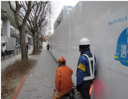
写真4-1-6-9 山留め材及び周辺地盤の計測管理
