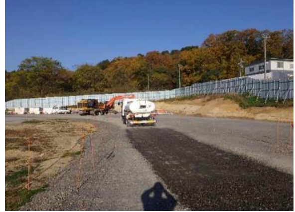
写真4-1-1-4 工事現場の清掃、散水
