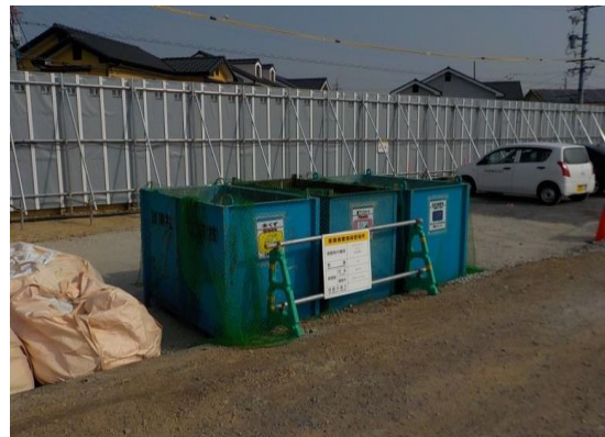
写真4-1-3-12 副産物の分別、再資源化
