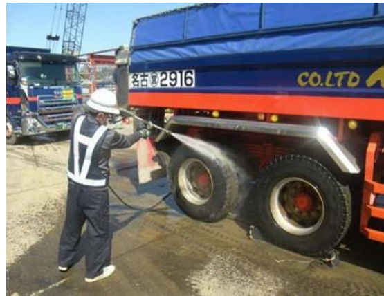
写真4-1-2-6 資材及び機械の運搬に用いる車両の 出入口、周辺道路の清掃及び散水、 タイヤの洗浄
