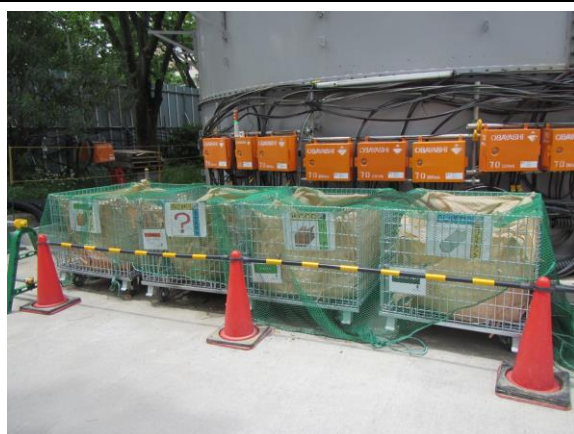
写真4-1-5-11 副産物の分別、再資源化
