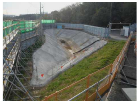
写真4-1-1-6 工事排水の適切な処理 (貯留施設等の設置)
