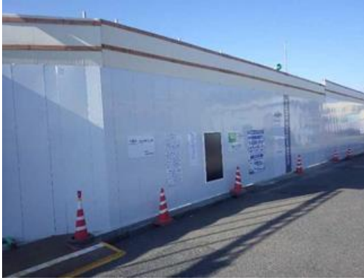
写真4-1-4-1 仮囲い・防音シート等の設置
