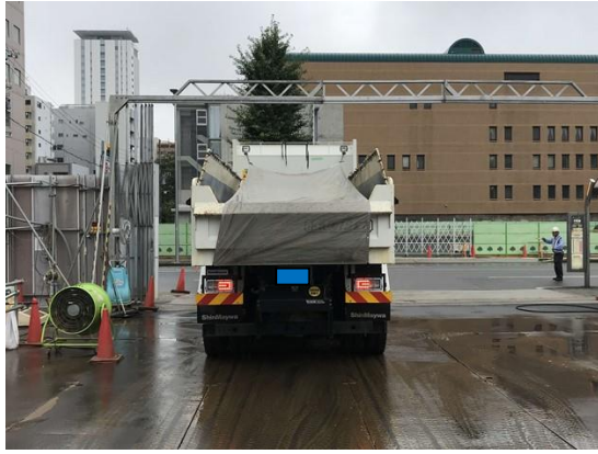
写真4-1-6-7 荷台への防塵シート敷設及び散水
