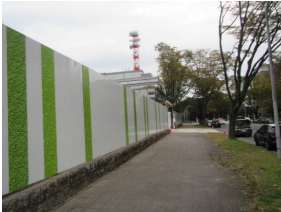
写真4-1-5-1 仮囲い等の設置
