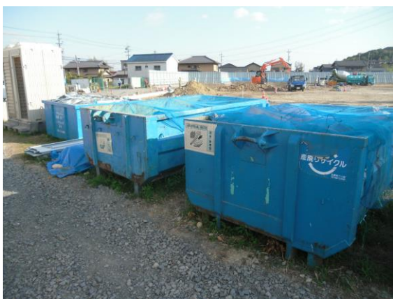
写真4-1-2-11 副産物の分別、再資源化
