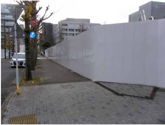
写真4-1-6-1 仮囲い等の設置
