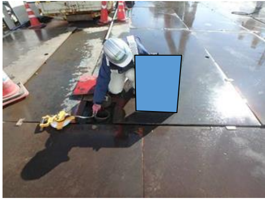
写真4-1-4-7 地下水の継続的な監視
