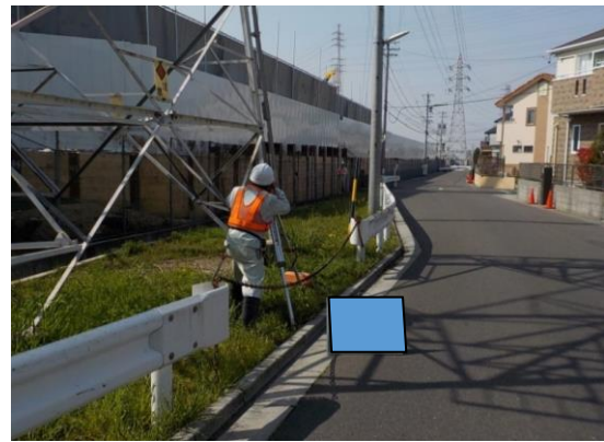
写真4-1-3-10 周辺地盤の計測管理
