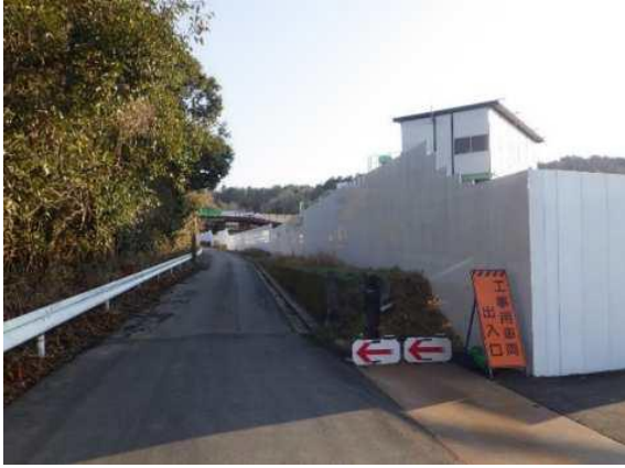
写真4-1-1-1 仮囲い等の設置
