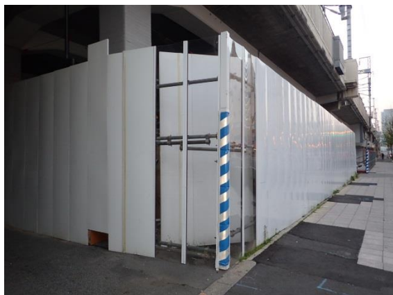
写真4-1-7-1 仮囲い等の設置
