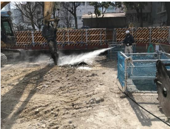
写真 4-1-6-5 工事現場の清掃、散水
