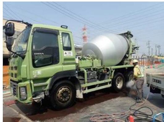
写真4-1-4-6 資材及び機械の運搬に用いる車両の出入口、周辺道路の清掃及び散水、タイヤの洗浄
