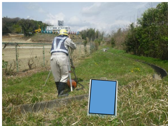
写真4-1-2-9 山留め材及び周辺地盤の計測管理
