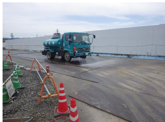
写真4-1-2-4 工事現場の清掃、散水
