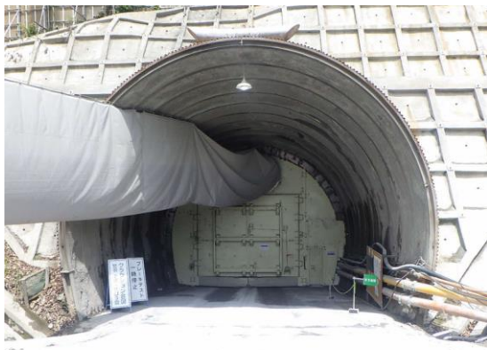
写真4-1-1-11 トンネル坑口への防音扉の設置
