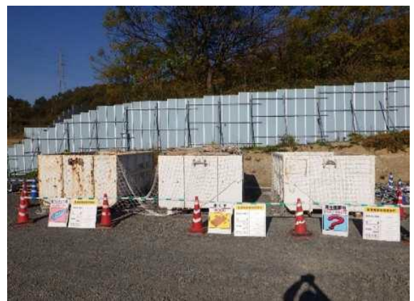
写真4-1-1-10 副産物の分別、再資源化
