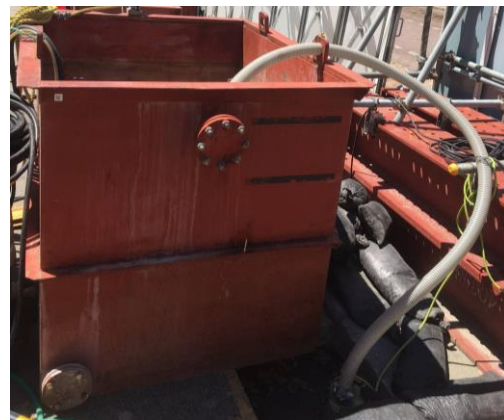
写真4-1-7-10 工事排水の適切な処理
