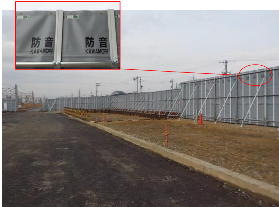
写真4-1-3-1 仮囲い・防音シート等の設置
