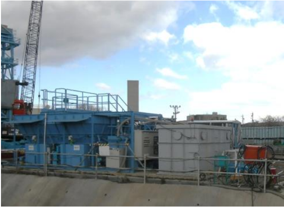
写真4-1-2-7 工事排水の適切な処理
