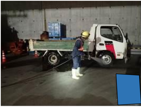
写真4-1-7-7 資材及び機械の運搬に用いる車両の出入口、周辺道路の清掃及び散水、タイヤの洗浄
