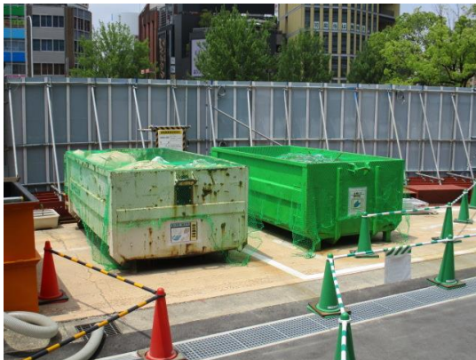
写真4-1-7-11 副産物の分別、再資源化
