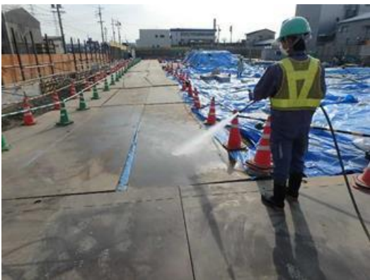
写真4-1-4-5 工事現場の清掃、散水
