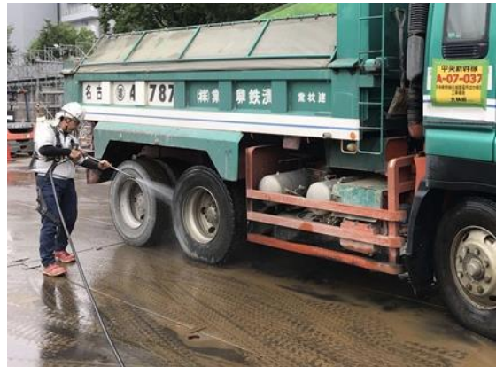
写真4-1-6-6 資材及び機械の運搬に用いる車両の 出入口、周辺道路の清掃及び散水、 タイヤの洗浄
