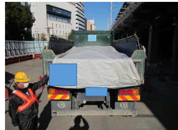
写真4-1-7-6 荷台への防塵シート敷設及び散水
