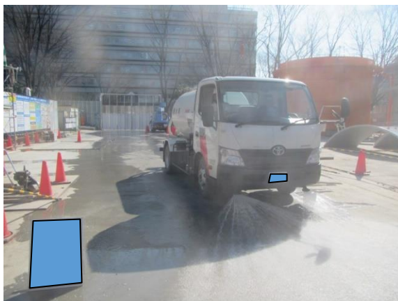
写真4-1-5-5 工事現場の清掃、散水
