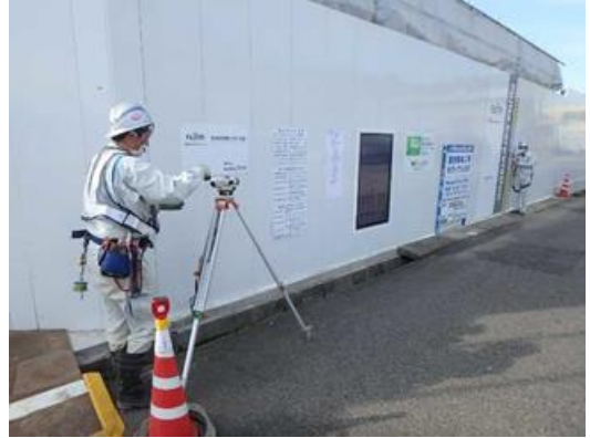
写真4-1-4-8 周辺地盤の計測管理
