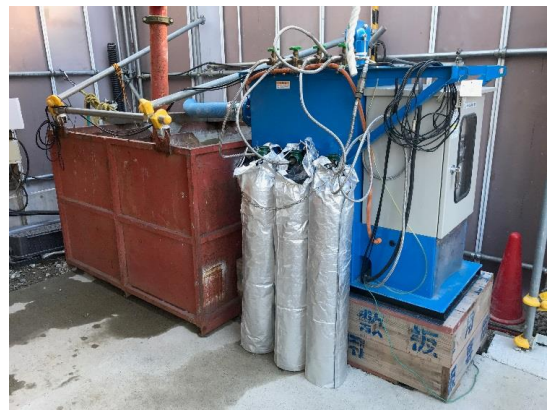
写真4-1-6-10 工事排水の適切な処理
