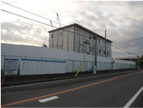
写真4-1-2-1 仮囲い等の設置
