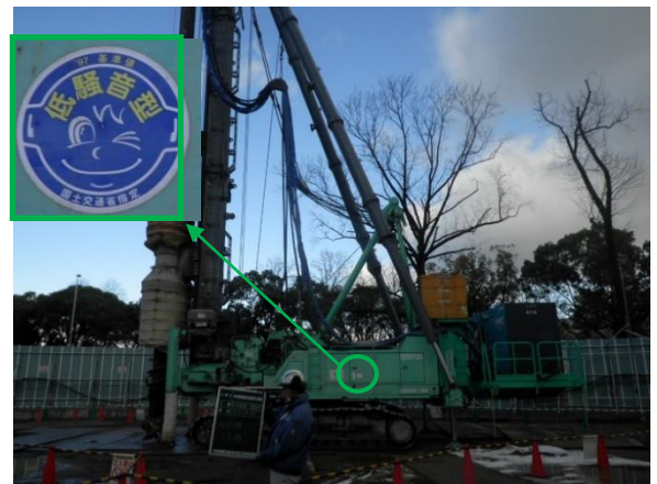
写真4-1-5-4 低騒音型建設機械の採用
