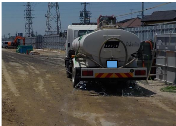
写真4-1-3-5 工事現場の清掃、散水
