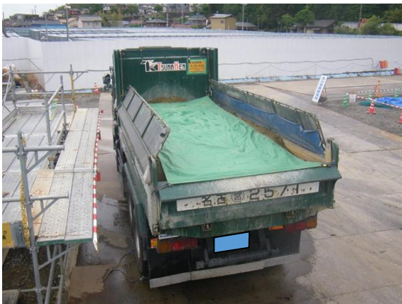
写真4-1-2-5 荷台への防塵シート敷設及び散水
