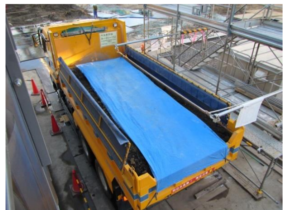
写真4-1-5-6 荷台への防塵シート敷設及び散水
