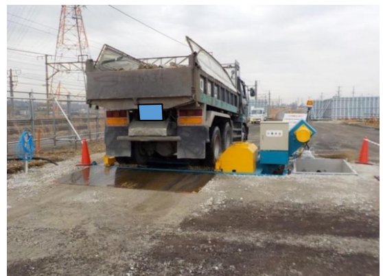
写真4-1-3-6 資材及び機械の運搬に用いる車両 の出入口の清掃及び散水、タイヤの 洗浄
