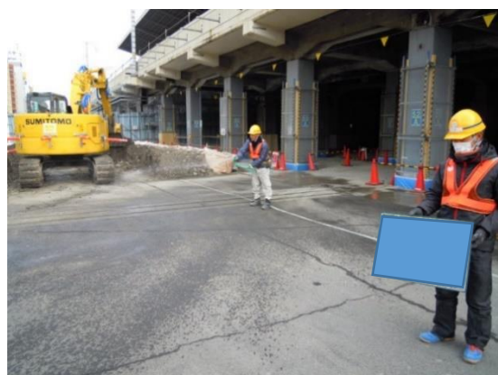
写真 4-1-7-5 工事現場の清掃、散水
