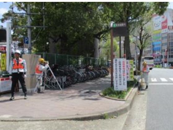
写真4-1-7-9 山留め材及び周辺地盤の計測管理
