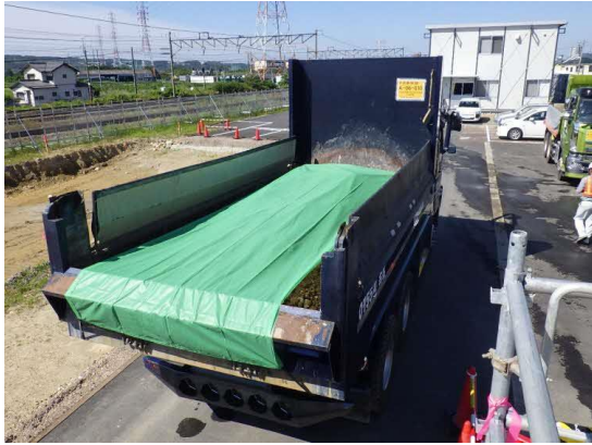
写真4-1-3-7 荷台への防塵シート敷設及び散水
