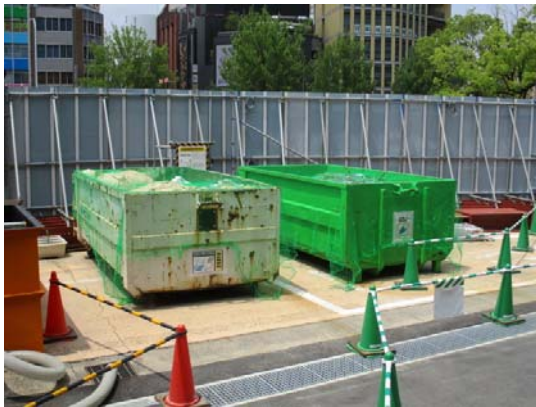
写真3-1-4-11 副産物の分別、再資源化
