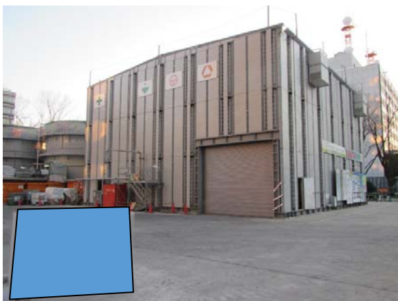
写真3-1-3-5 防音ハウスの設置
