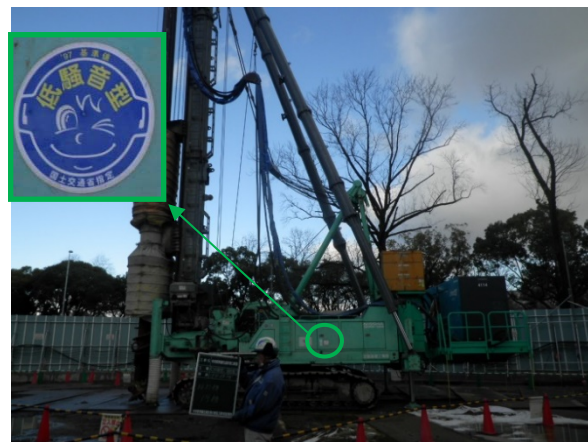
写真3-1-3-4 低騒音型建設機械の採用
