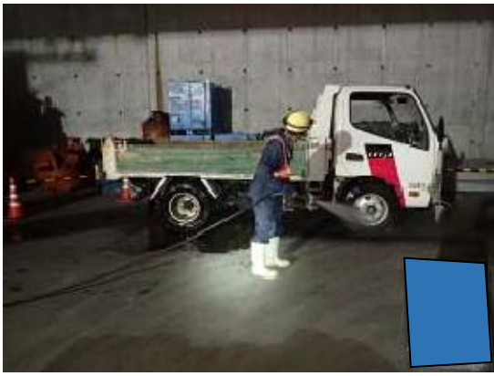
写真3-1-4-7 資材及び機械の運搬に用いる車両の出入口、周辺道路の清掃及び散水、タイヤの洗浄
