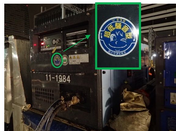
写真3-1-4-4 低騒音型建設機械の採用
