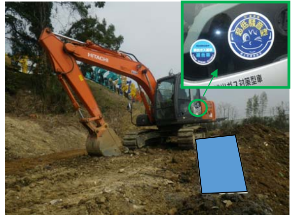
写真3-1-2-2 排出ガス対策型建設機械の採用 低騒音型建設機械の採用
