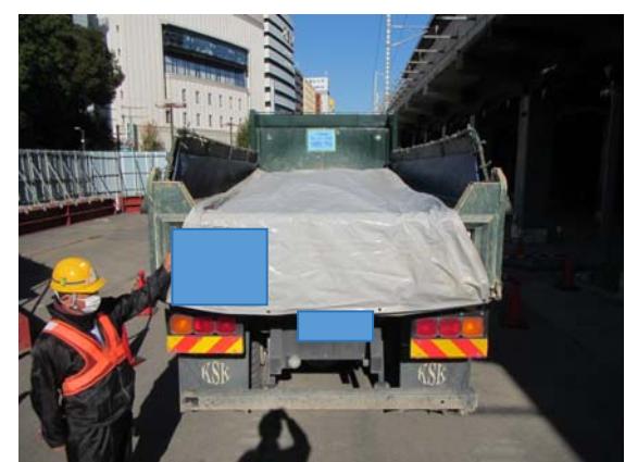
写真3-1-4-6 荷台への防じんシート敷設及び散水
