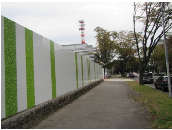
写真3-1-3-1 仮囲い等の設置
