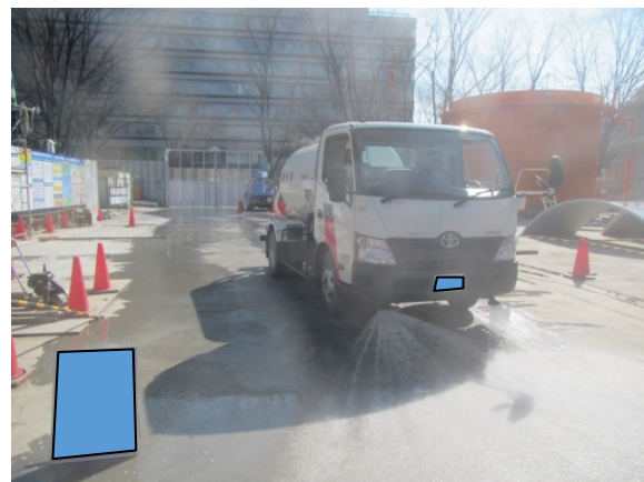
写真3-1-3-6 工事現場の清掃、散水
