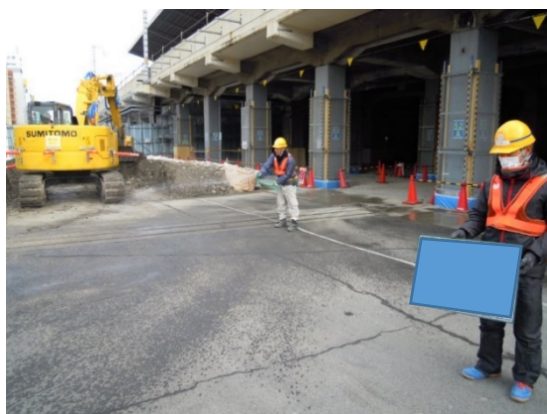
写真 3-1-4-5 工事現場の清掃、散水
