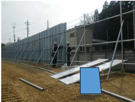
写真3-1-2-1 仮囲い等の設置
