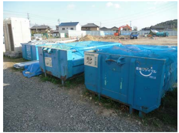
写真3-1-2-8 副産物の分別、再資源化
