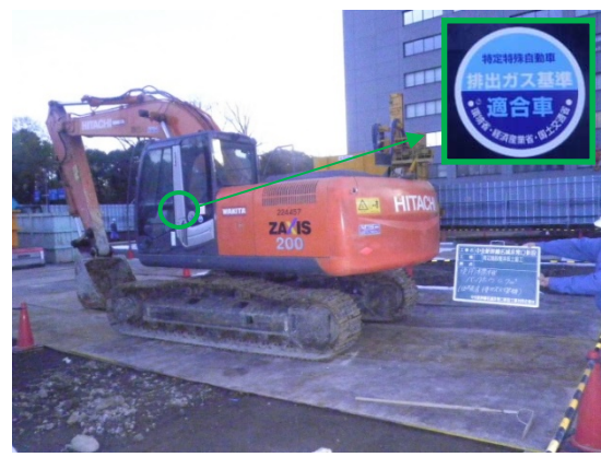
写真3-1-3-2 排出ガス対策型建設機械の採用
