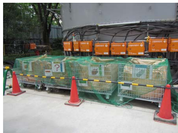
写真3-1-3-12 副産物の分別、再資源化
