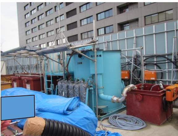
写真3-1-3-9 工事排水の適切な処理
