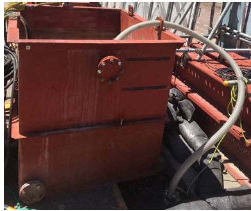
写真3-1-4-8 工事排水の適切な処理
