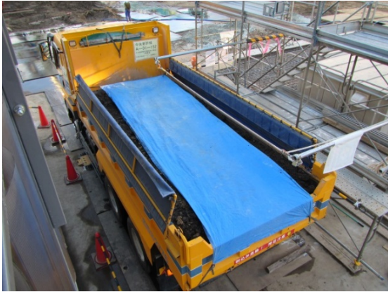
写真3-1-3-7 荷台への防じんシート敷設及び散水
