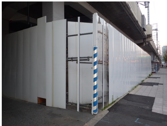
写真3-1-4-1 仮囲い等の設置
