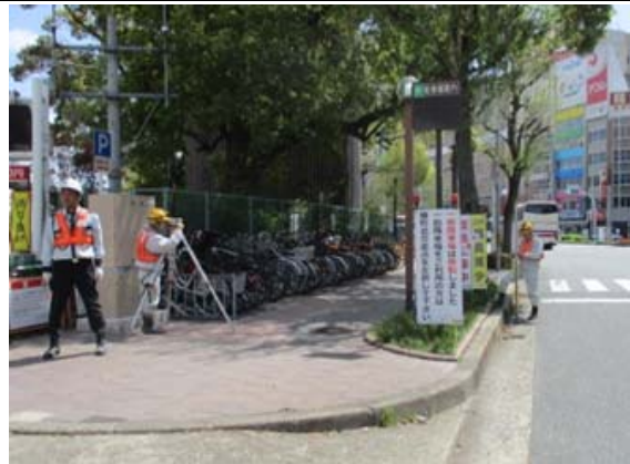
写真3-1-4-10 山留め材及び周辺地盤の計測管理
