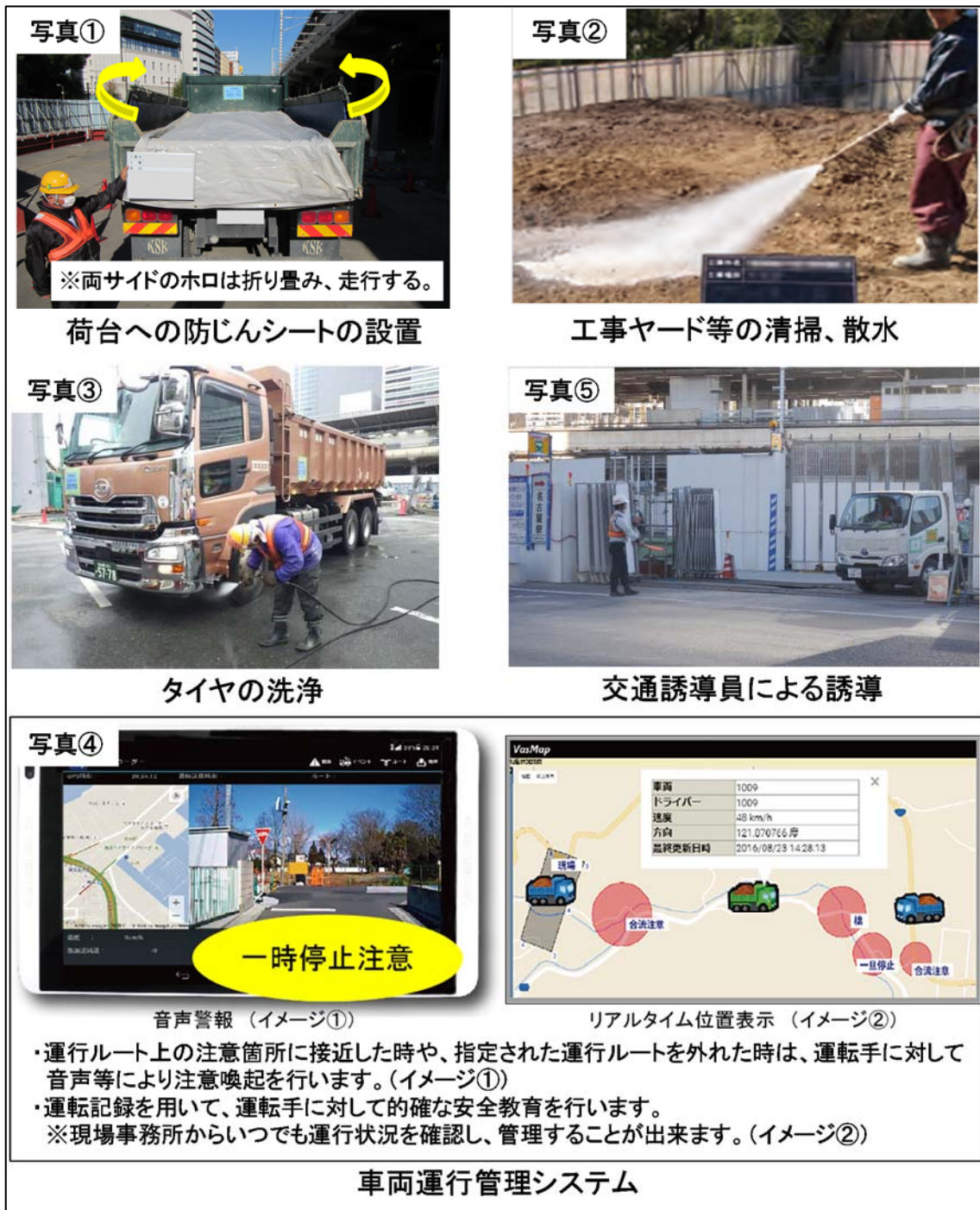
図 3-8 資材及び機械の運搬に用いる車両の運行による影響を低減するための環境保全措置
