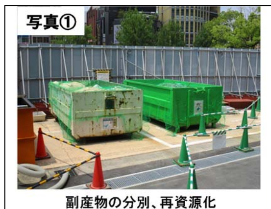
図 3-7 環境への負荷（廃棄物等、温室効果ガス）に関する工事実施時の環境保全措置
