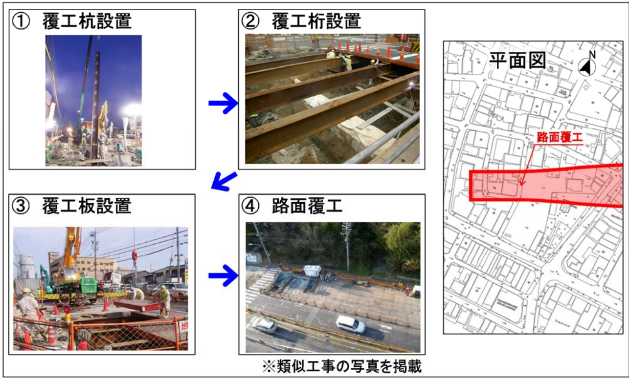
図 2-10(5) 路面覆工の施工
