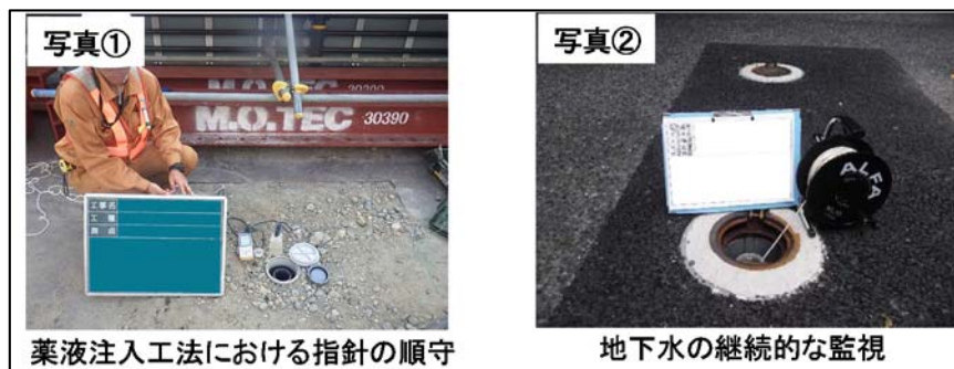
図 3-5 水環境に関する工事实施時の環境保全措置
