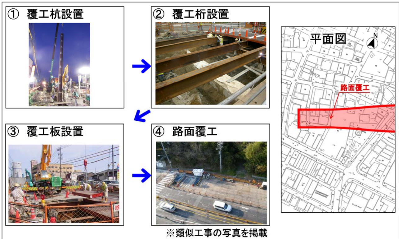
図 2-9 (5) 路面覆工の施工
