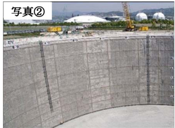
止水性の高い土留め壁 (地中連続壁)の設置
