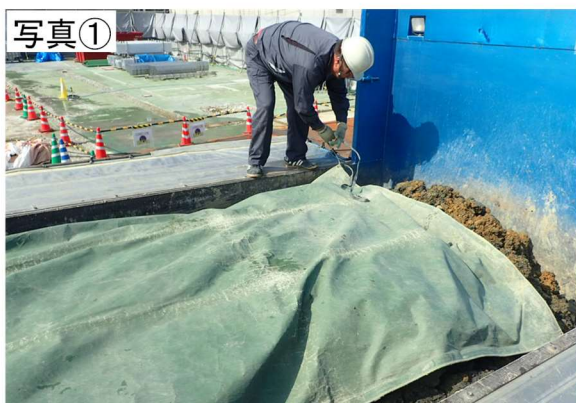
荷台への防じんシートの敷設
