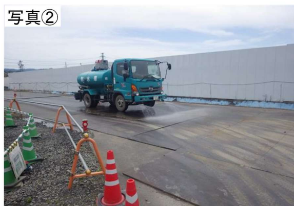
工事施工ヤード等の清掃、散水
