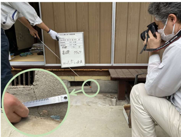
参考図 2-8 外壁・基礎調査
