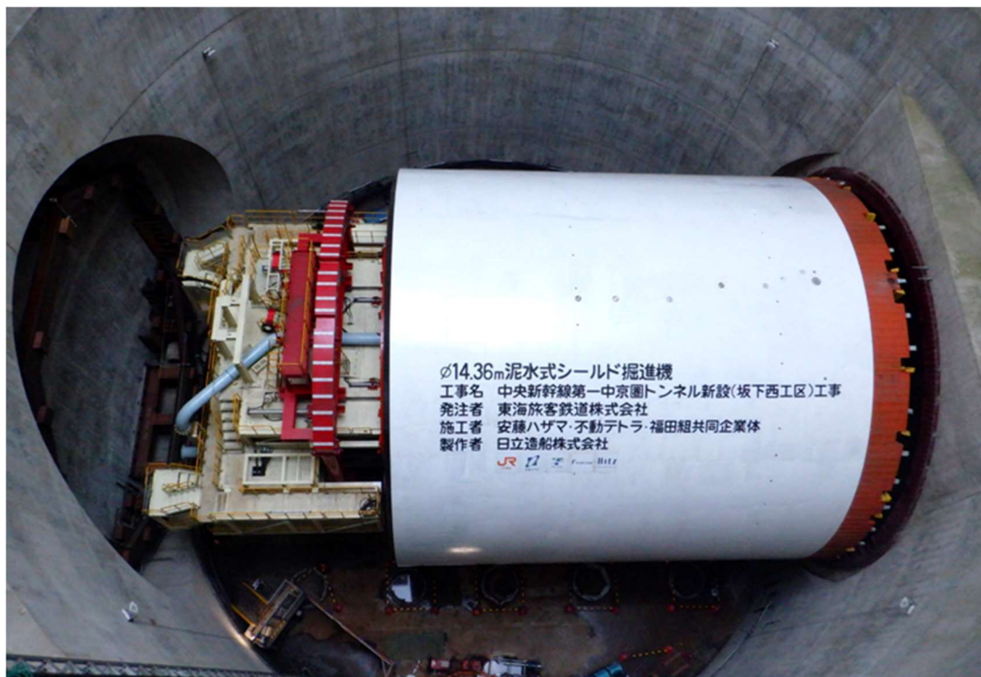
図 2-8 トンネル掘進に使用するシールド機
