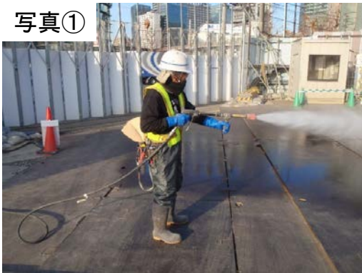
工事施工ヤード等の清掃、散水
