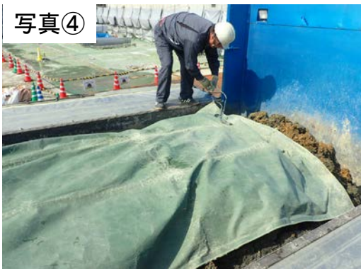
荷台への防じんシートの設置
