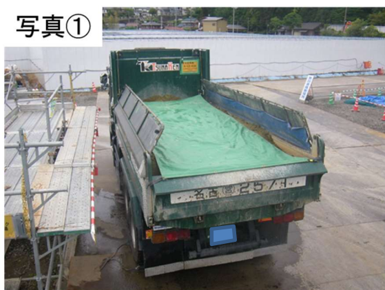
荷台への防じんシートの敷設
