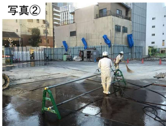
工事施工ヤード等の清掃、散水
