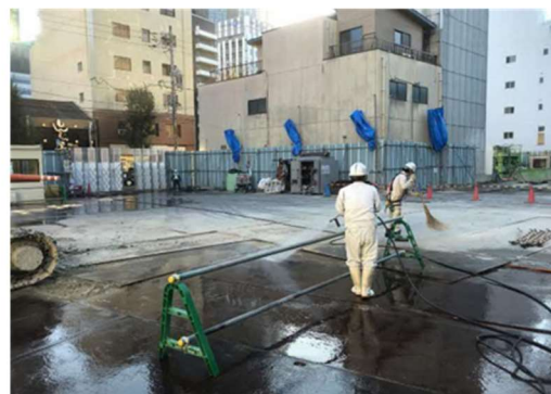
写真③ 工事施工ヤード等の清掃散水
