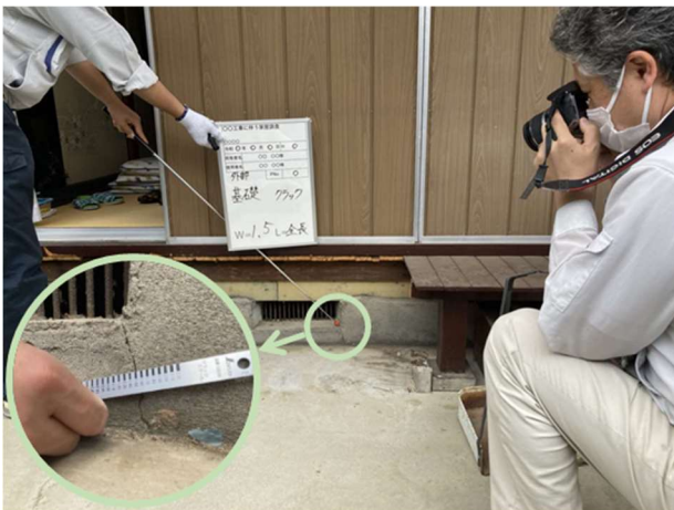
参考図 2-8 外壁・基礎調査
