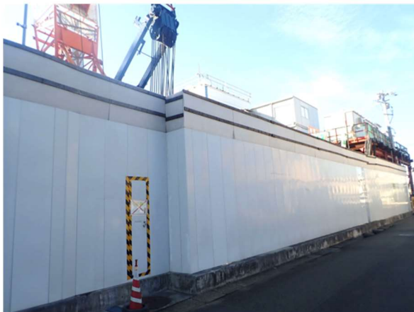
写真③ 工事施工ヤード周囲に 仮囲い設置 (3m)
