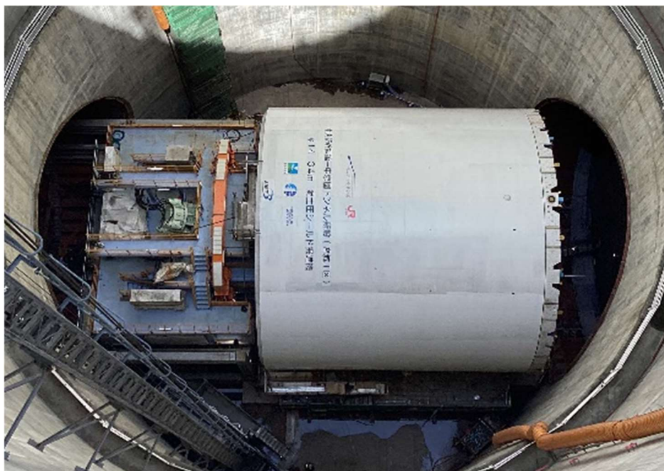
図 2-7 本工事に使用するシールド機（名城非常口）
