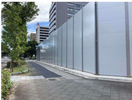
写真① 工事施工ヤード周囲に 仮囲い設置 (3m以上)
